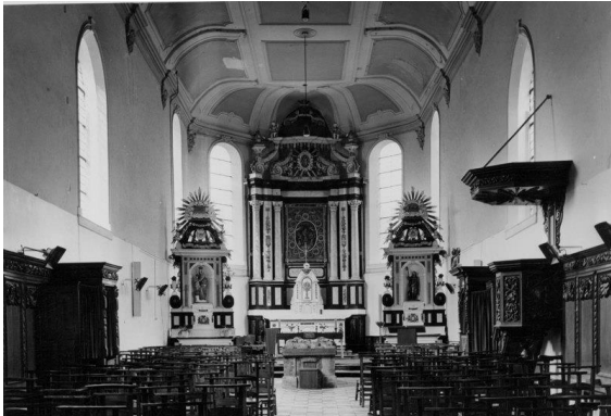
Figure 58 : Intérieur de la chapelle en 1972
