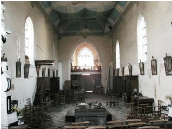
Figure 60 : intérieur de la chapelle en 2008.
