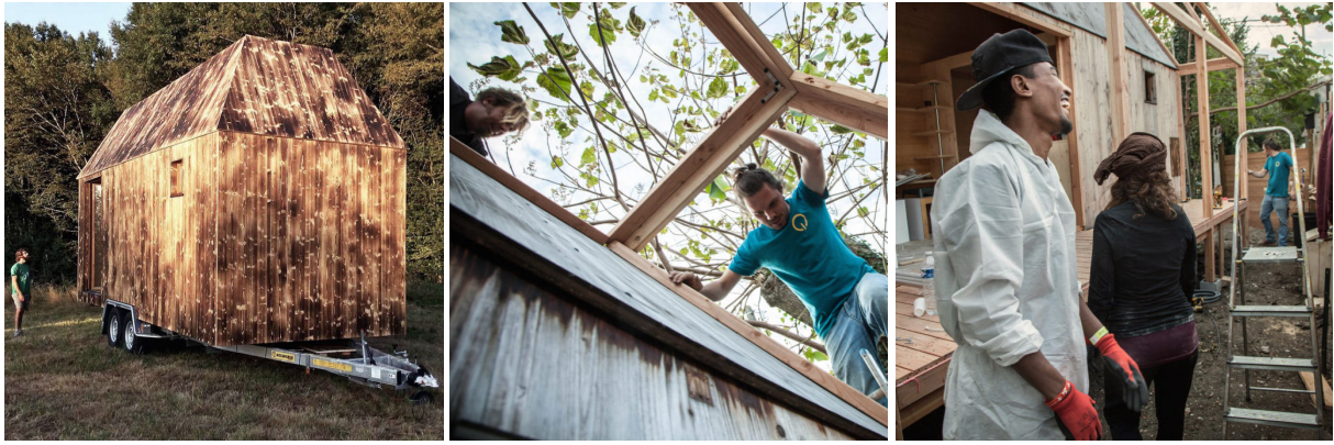
Figure 28: Une tiny house réalisée pour le projet « IMBY ». Figures 29 et 30: Construction d'une tiny house pour le projet « IMBY ».
