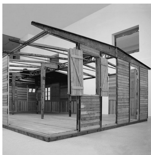
Figure 19: Montage de la maison démontable 6x9 de Jean Prouvé.
