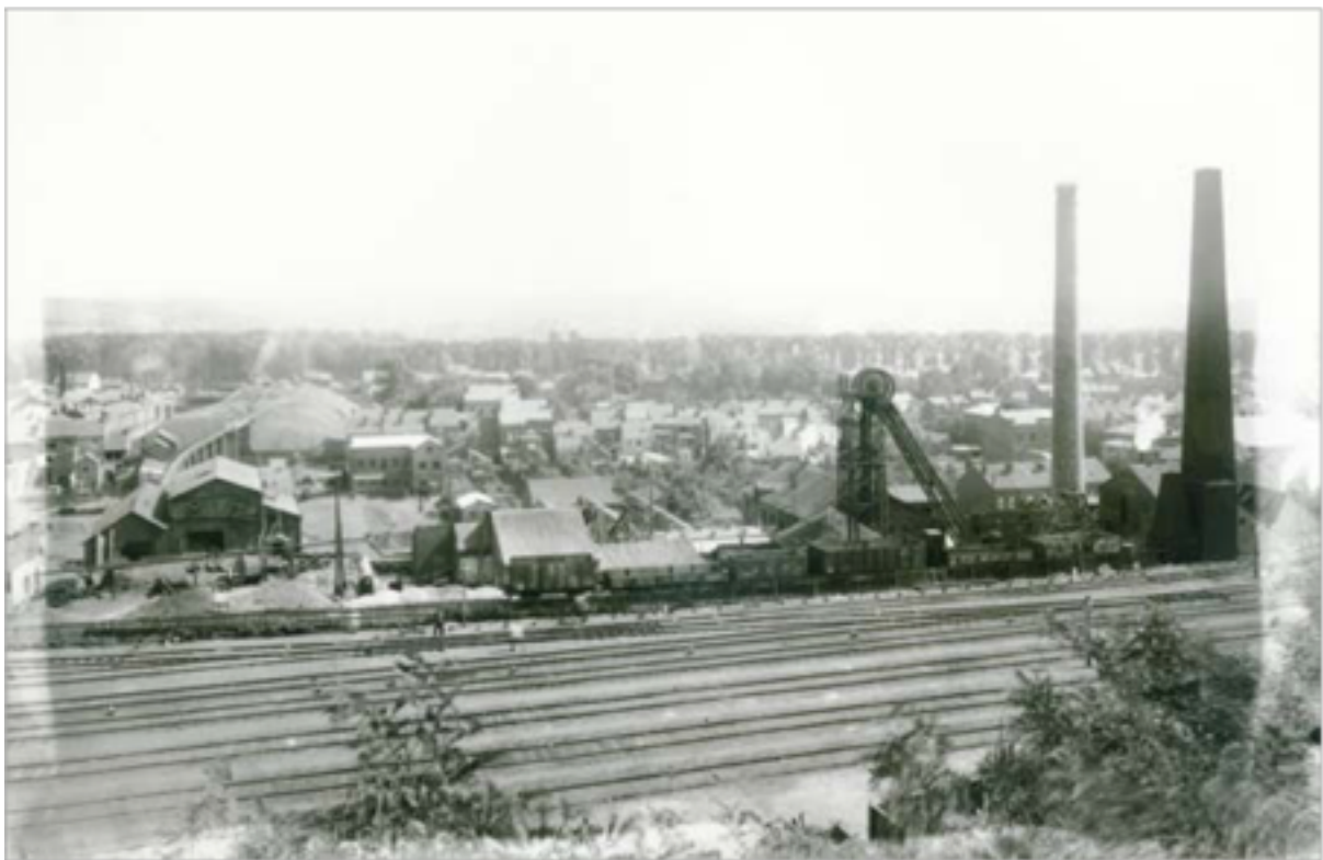
Photographie du charbonnage de Belle-Vue, Herstal, Collection du Musée Herstalien
