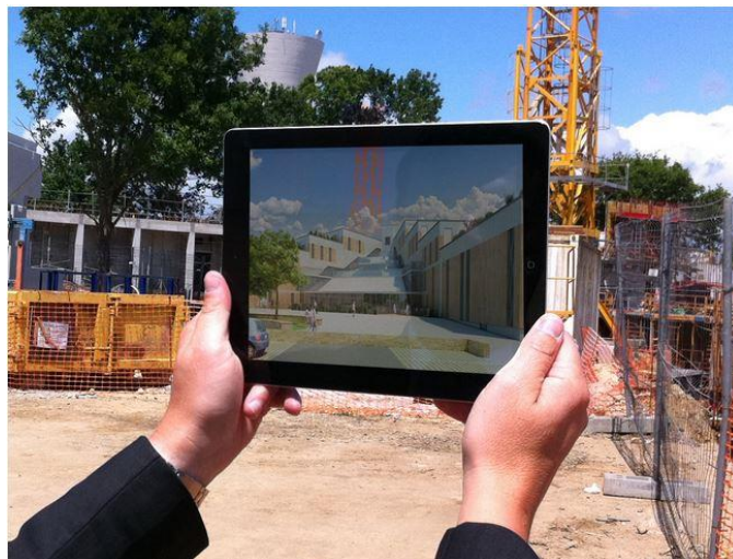
Photo 1 : Application de réalité augmentée pour le chantier de l'école d'ingénieur Ensibs, à Lorient.
