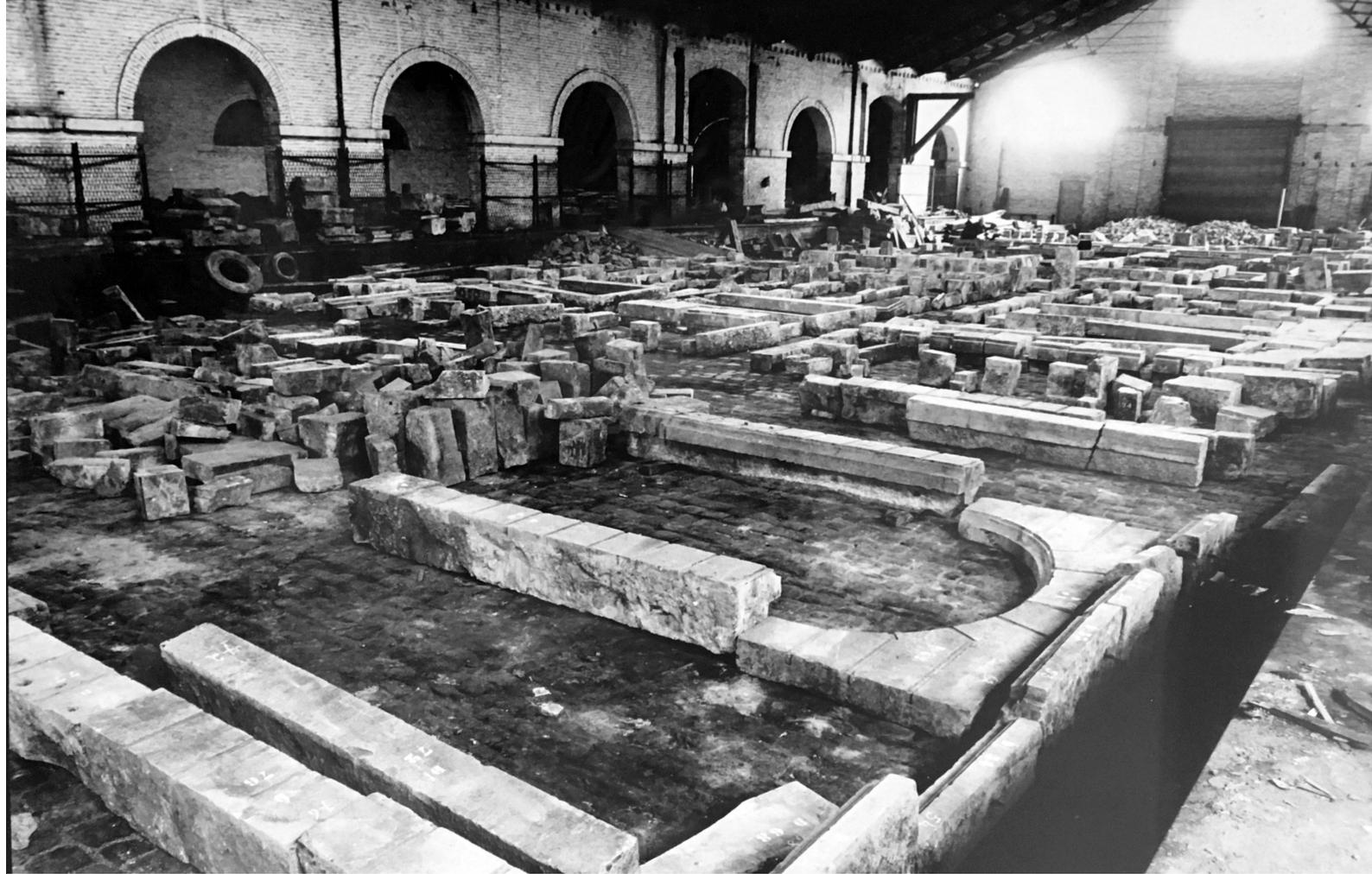
Figure 55 Stockage des façades démontées.
