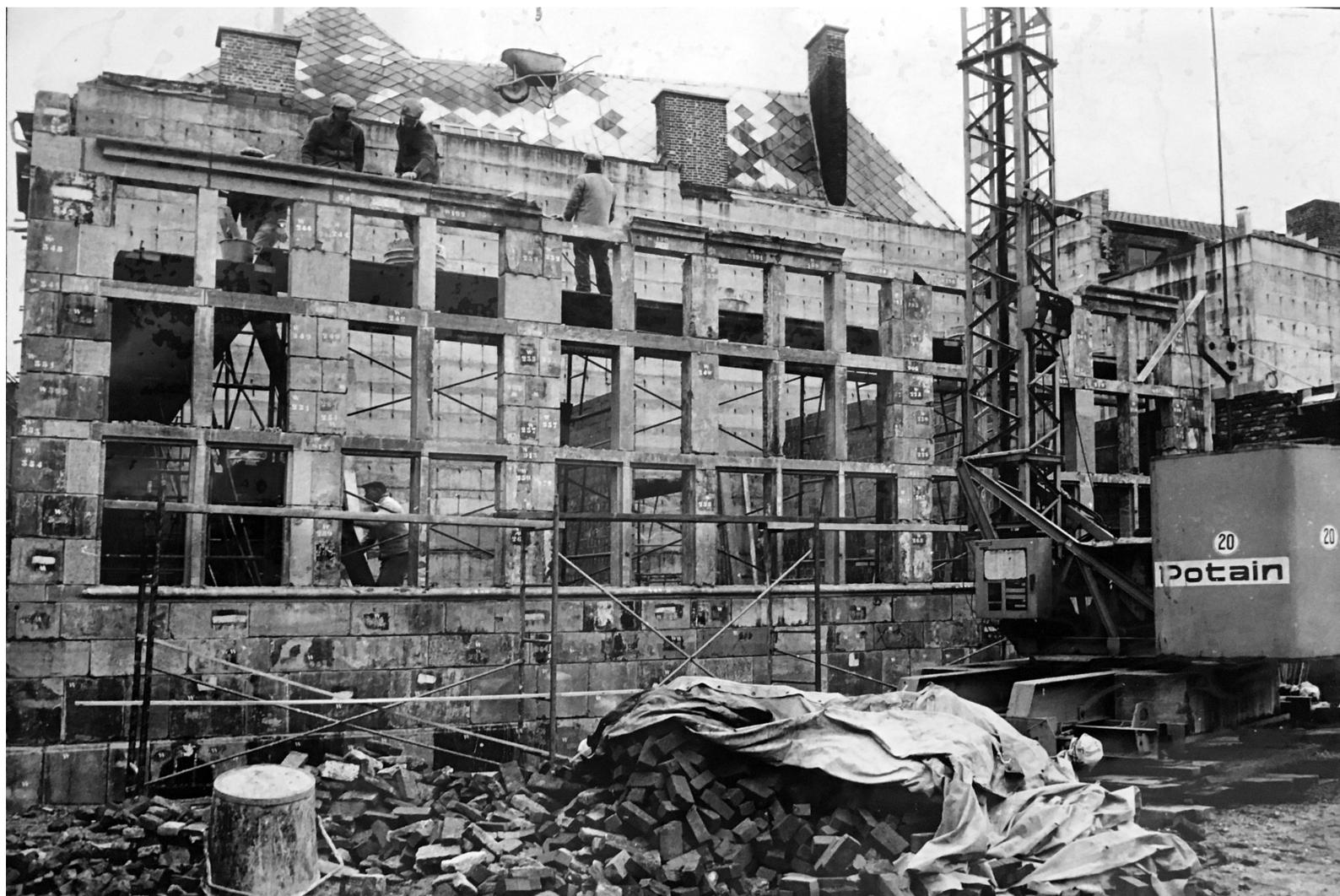
Figure 56 Reconstruction des façades pierre par pierre. On peut voir une numérotation sur chaque élément.
