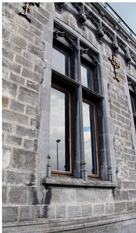
Figure 90: Photo d'une baie à meneaux
