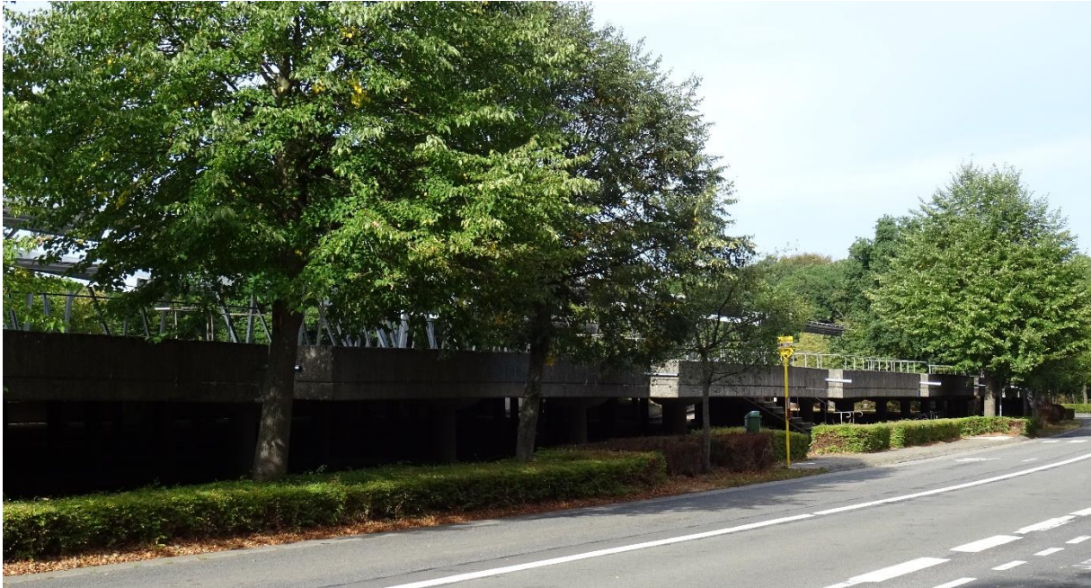
Figure 82: Parking double étage du site de l'ULG au Sart Tilman.
