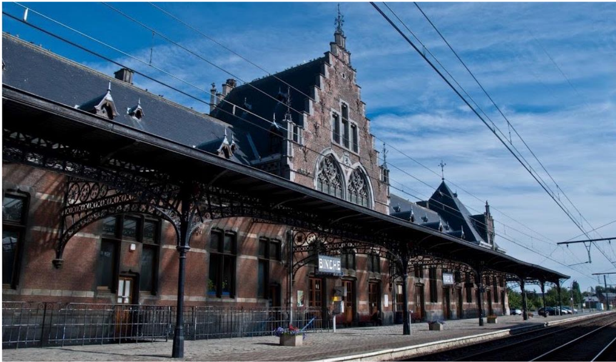
Figure 91: Photo de la façade arrière
