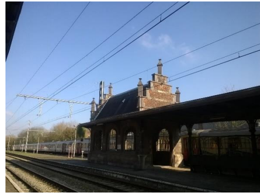
Figure 11: Photo des pavillons voyageurs
