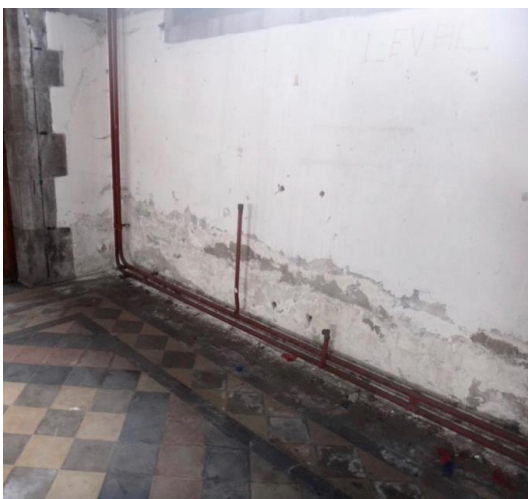
Figure 36:Photo intérieure du coin sud-est
