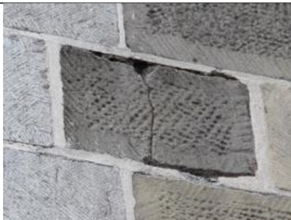
Figure 57: Bloc de grès fracturé
