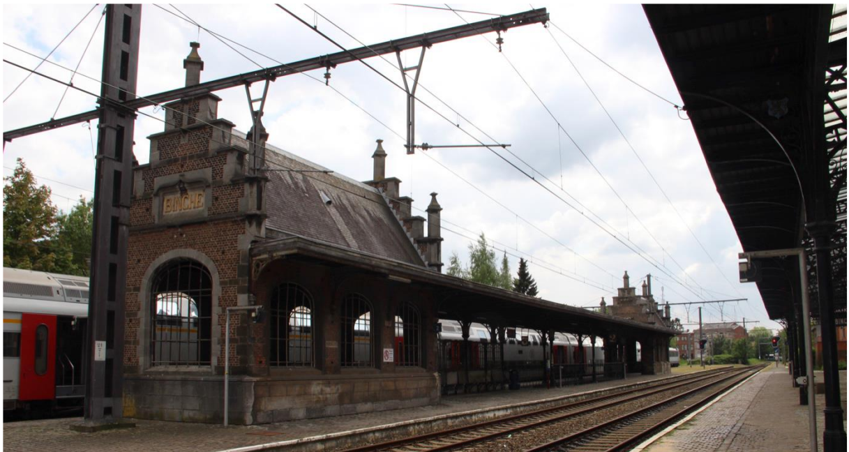
Figure 96: Photo des petits pavillons voyageurs
