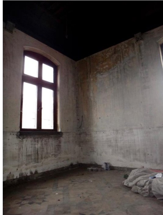
Figure 39: Photo intérieur du coin sud-ouest
