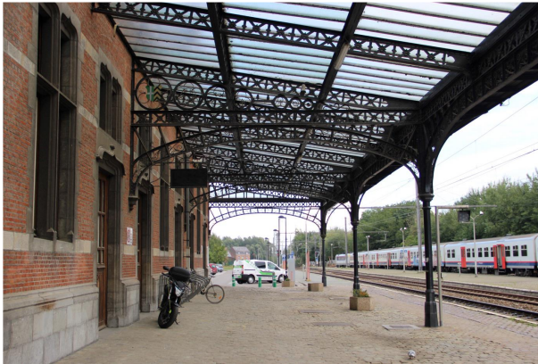
Figure 61: Auvent de la façade arrière
