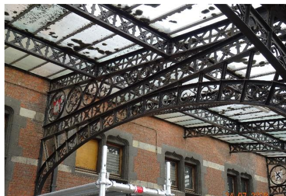
Figure 30: Structure en métal de l'auvent arrière
