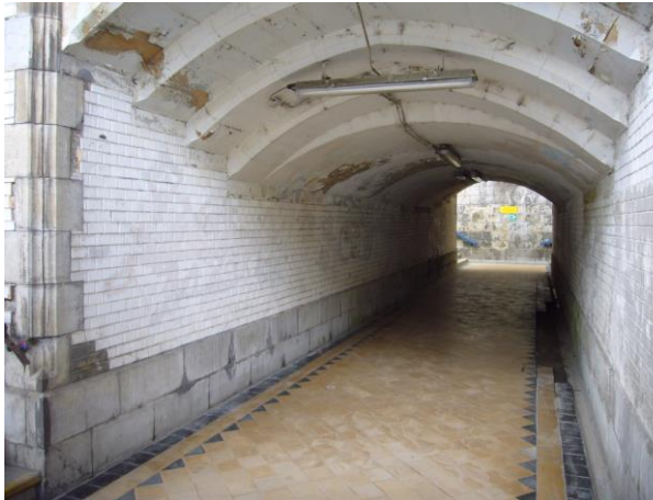
Figure 93: Photo du couloir sous voies
