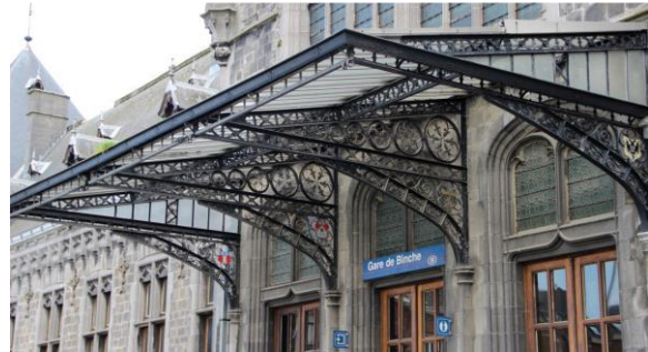
Figure 62: Marquise de la façade avant
