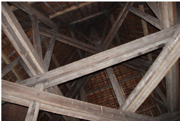
Figure 107: Photo des combles au-dessus du pavillon droit
