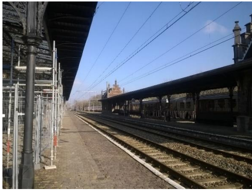
Figure 10: Photo des pavillons voyageurs
