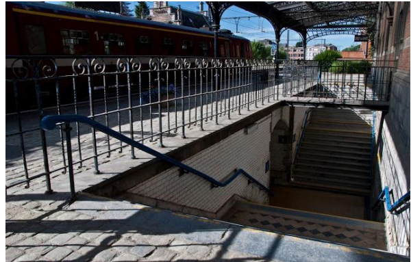
Figure 94: Escalier d'accès au couloir sous voies
