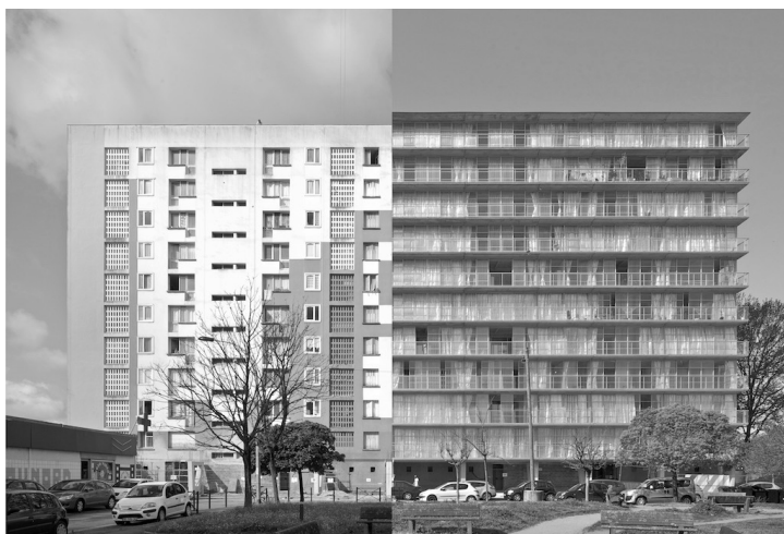
Figure 4 : Réhabilitation d'un immeuble des années 60 à Bordeaux par Lacaton et Vassal en 2016
