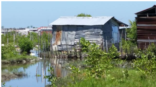
Photo 13 : Habitats construits avec des bidons aplatis à Fort St-Michel.
