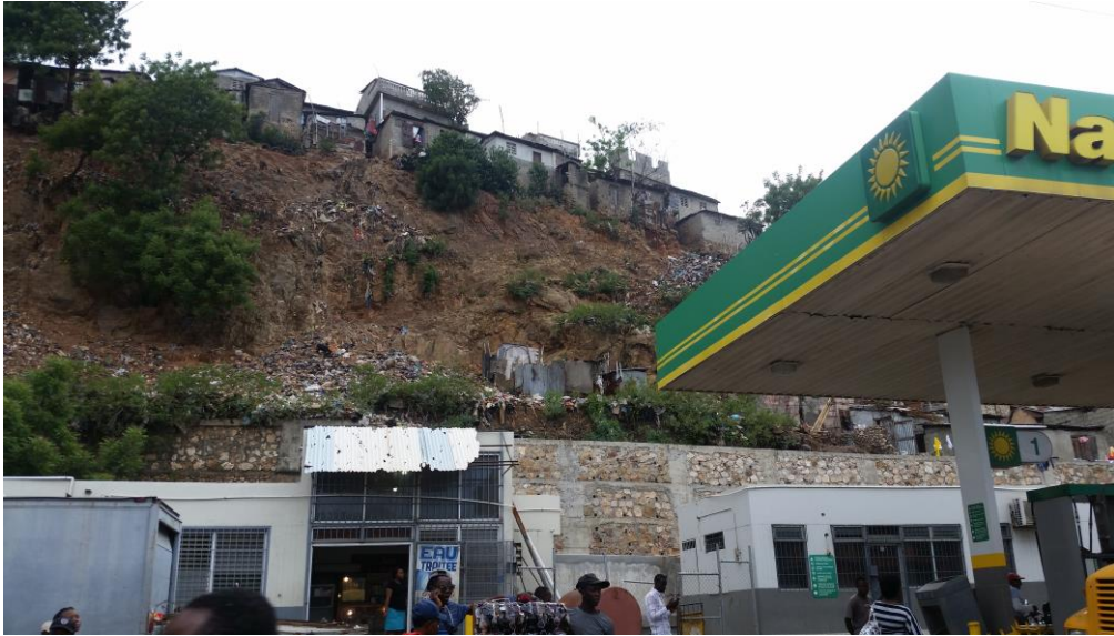
Photo 4 : Constructions anarchiques sur la falaise à Cap-Haïtien.
