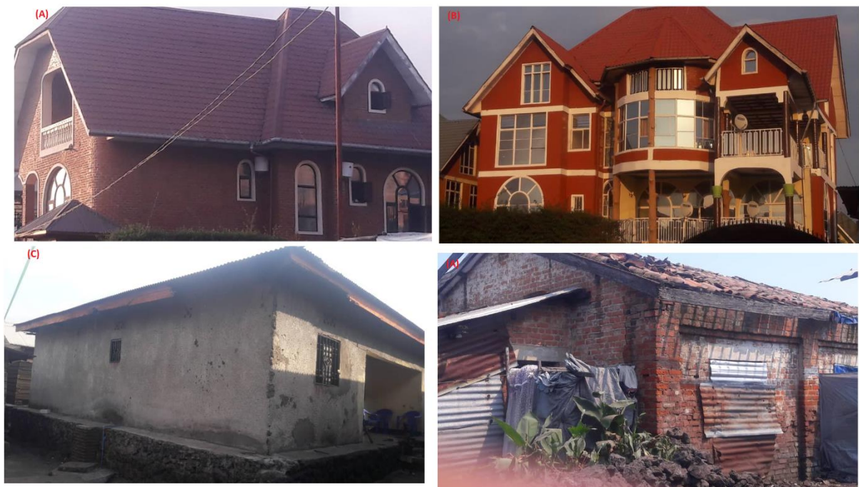
Figure 9. Première catégorie de bâtiments observés sur terrain suivant le coût de construction : bâtiments en Briques ou bloc-ciments avec ou sans colonne de béton armé. (A) Bâtiment en briques avec colonnes de béton armé, confort et ornement, avec ou sans en étage. Il constitue la catégorie dont le coût de construction est assez élevé, (B) Bâtiment en bloc ciment avec colonne de béton armé, enduits des fines couches d'ordre centimétrique de sable fin pour l'isolation et d'une autre fine couche d'ordre millimétrique de peinture pour l'ornement, avec ou sans en étages. Son coût de construction est presque le même que celui de (A) si on se base sur leurs tailles et leurs dimensions. (C) Bâtiment en Bloc-ciment sans colonne de béton. Ils peuvent ou ne pas être enduits des couches de sable ou de peinture, leur confort est faible. Généralement ces genres de bâtiment n'ont pas d'étage, peut-être que les propriétaires ont peur que suite au manque de soutien par des colonnes de béton armés, ces bâtiments puissent s'effondrer sur eux-mêmes en cas d'un séisme de faible magnitude par exemple. (D) Les anciens bâtiments en briques. Ils sont des colonnes de béton armé et le confort est devenu faible suite à leur âge. Ils sont plus observés que dans le Quartier Murara qui était occupé par les colons belges.
