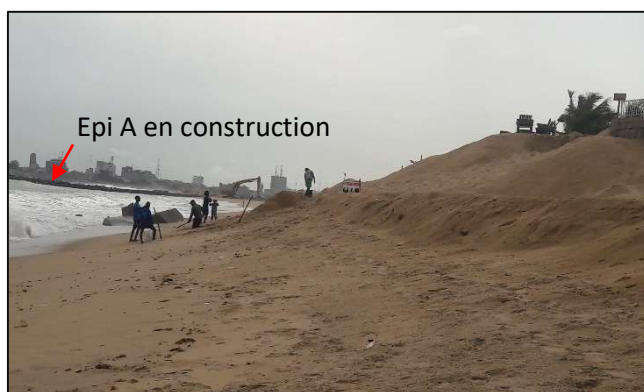
Photo 2 : Mise en place et entretien continu de dune artificielle sur la façade de l'hôtel Biergarten – entre l'épi ABis et l'épi A en construction (cliché Assogba, 2018).
