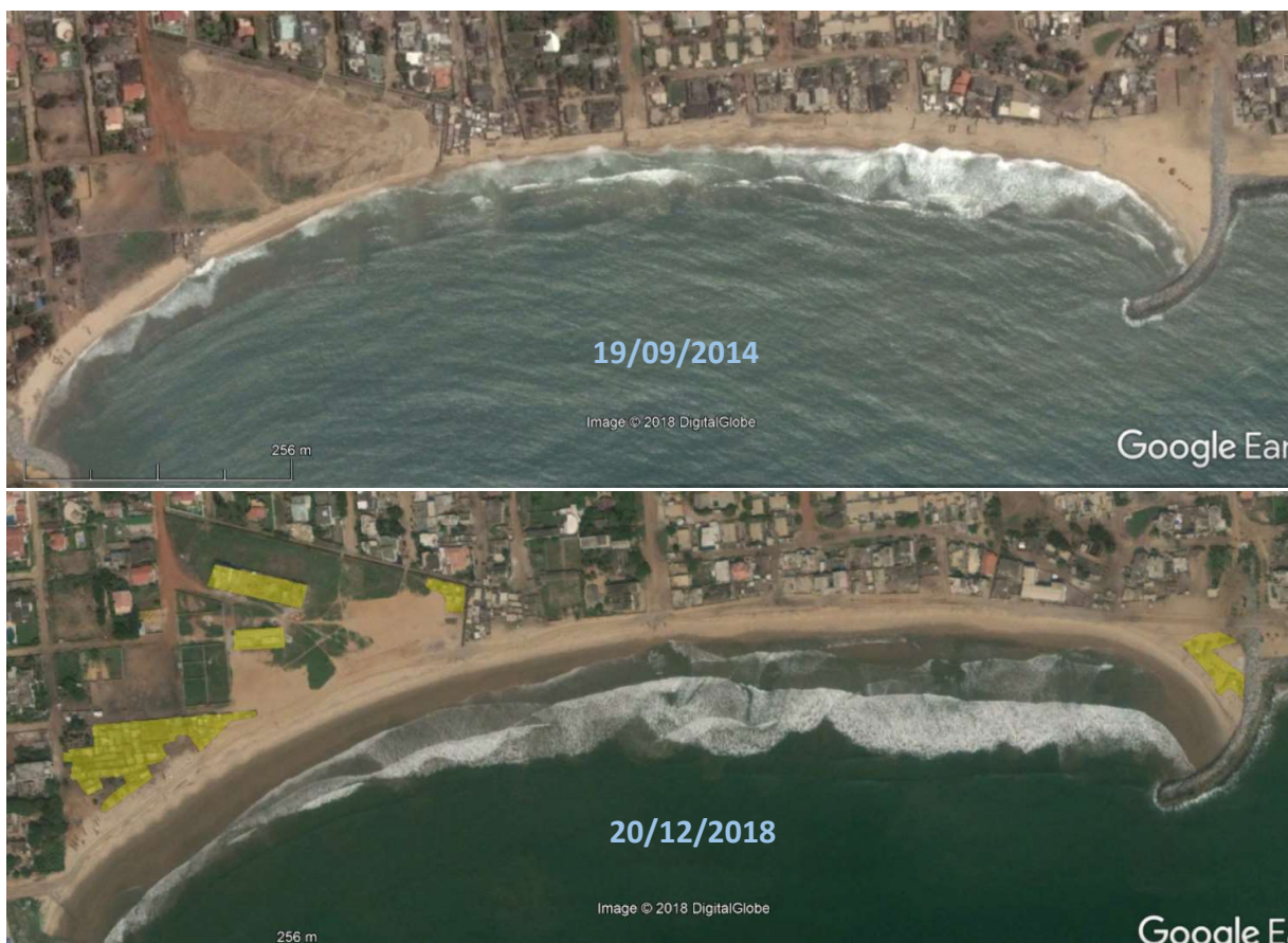
Figure 21 : Retour à l'occupation de la zone côtière entre l'épi de Sifato et l'Epi 1 (Google Earth, données de terrain, 2018).
