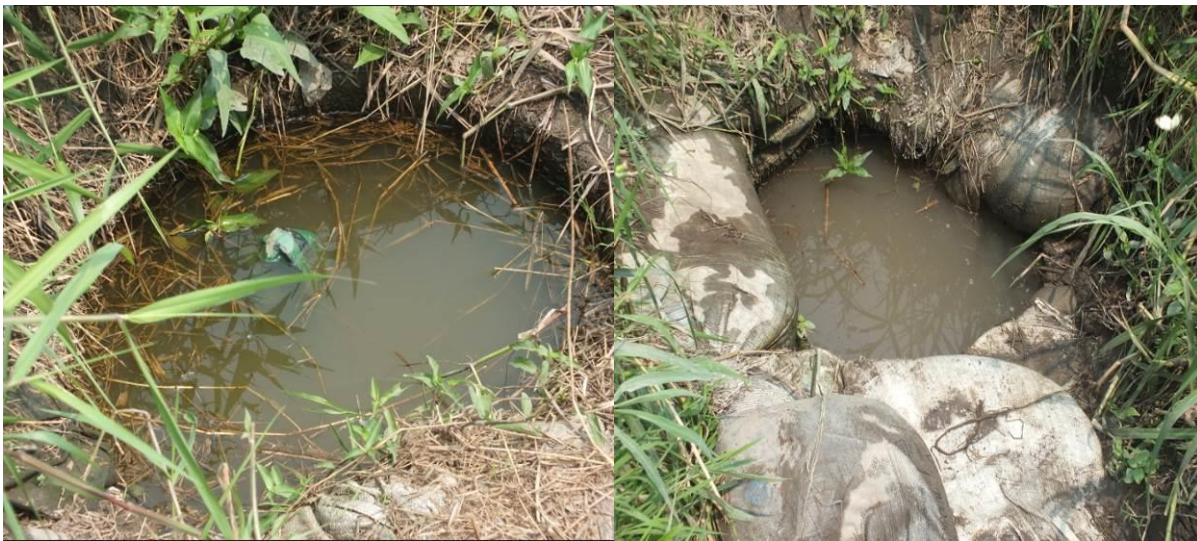
Figure 13 : Puits à buse dans les rizières
