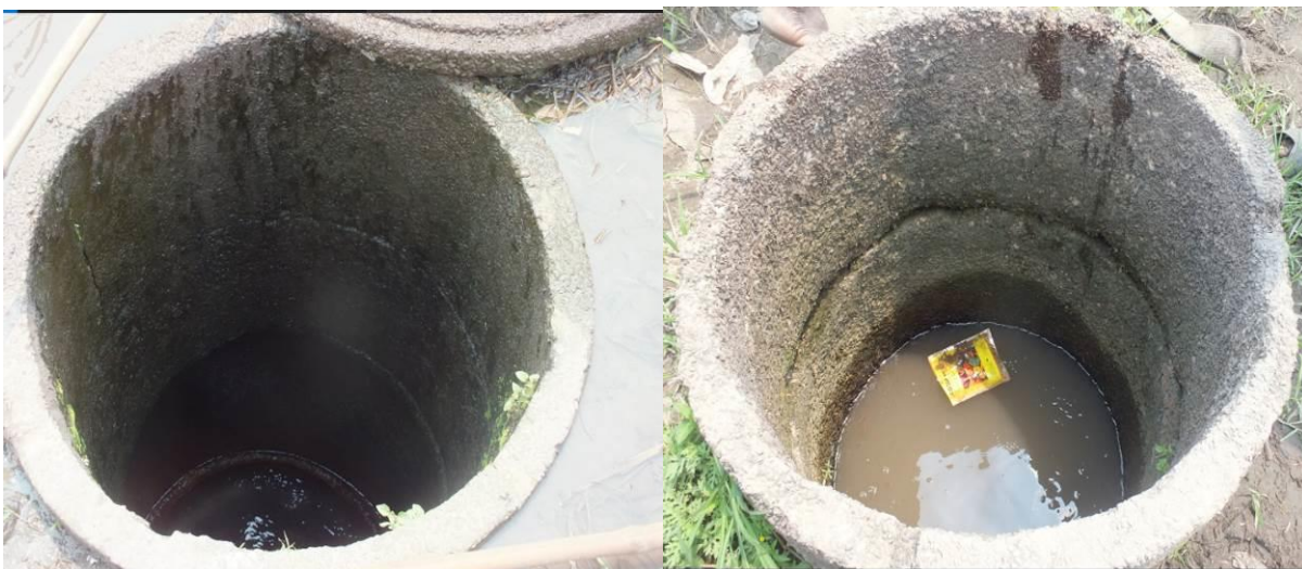
Figure 11 : Couverture ou non des puits à buse
