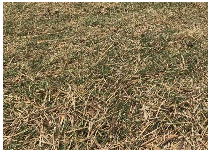
Etat des berges en avril 2018
