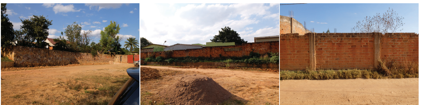
Figure 7.24 : Exemples de limite imperméable visible en périphérie de l'IV, au niveau d'habitations dont les parcelles sont entièrement murées pour le point PO 55 (Harold Strammer, 2018).
