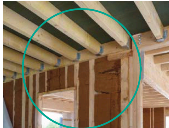
Illustration 7 : Dégradation irréversible des propriétés physiques d'une LDB suite à l'exposition prolongée à l'humidité sur chantier.
