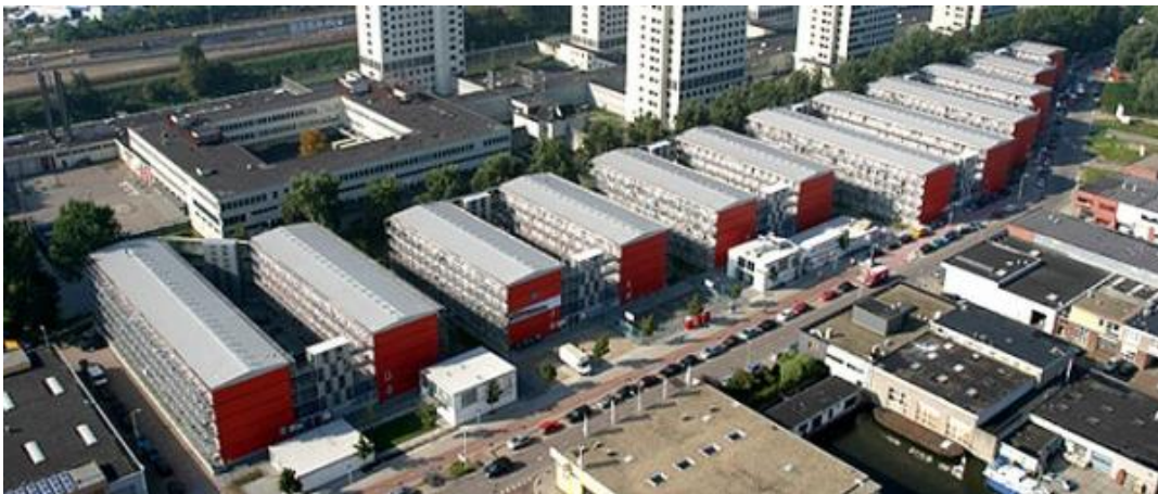
Figure 2: Tempohousing _ Photo aérienne du Keetwonen _ 2005 (Tempohousing, n.d.)
