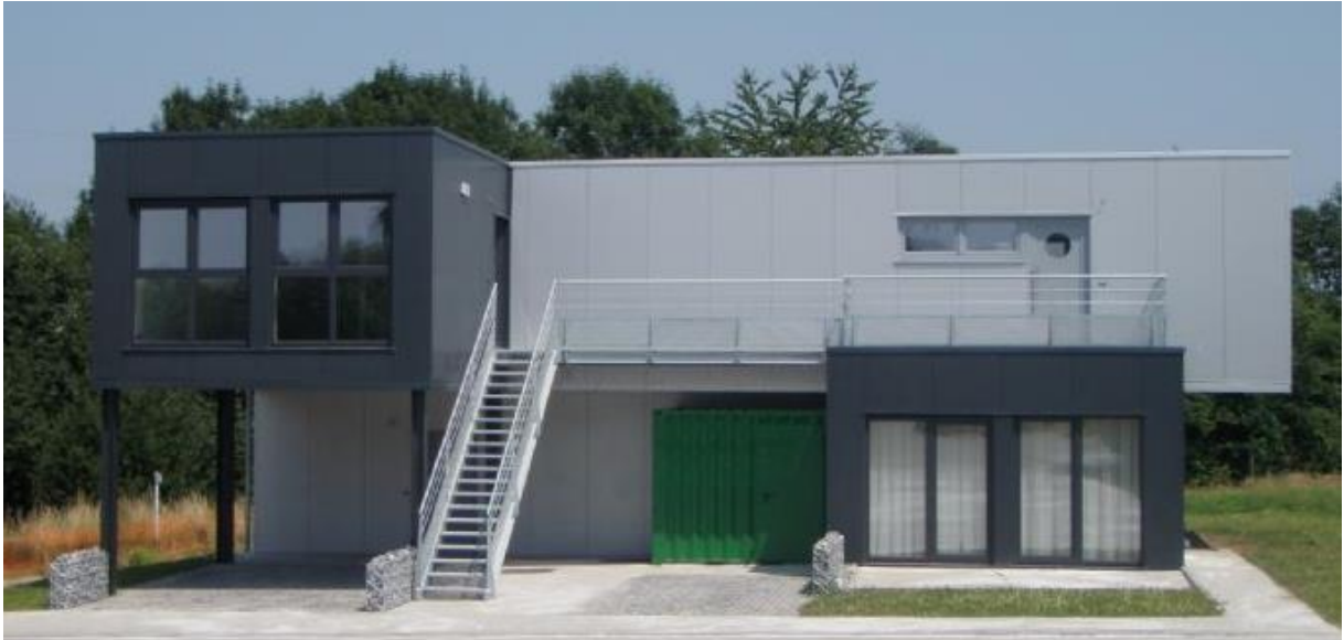
Figure 38 : Okube _ Façade bâtiment de quatre logements _ 2015 (Selke, 2016)
