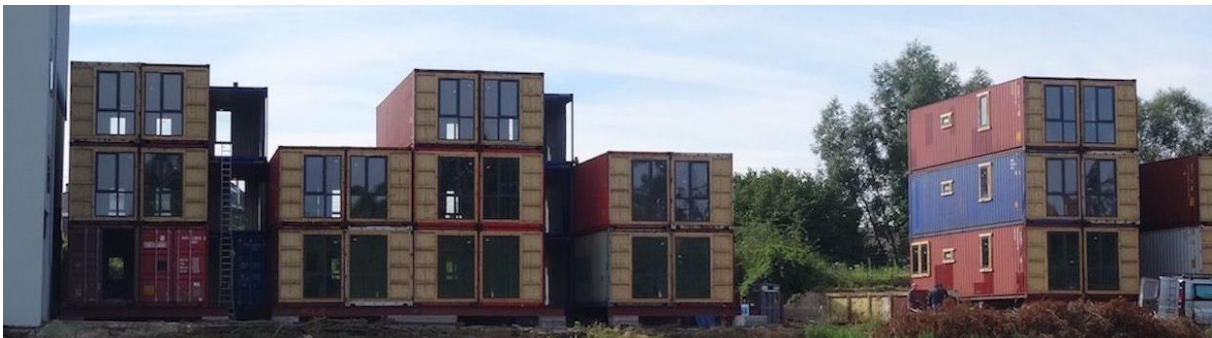
Figure 39 : Francesco Colabufalo _ Photo du chantier _ 2015 (Devaux, 2016)
