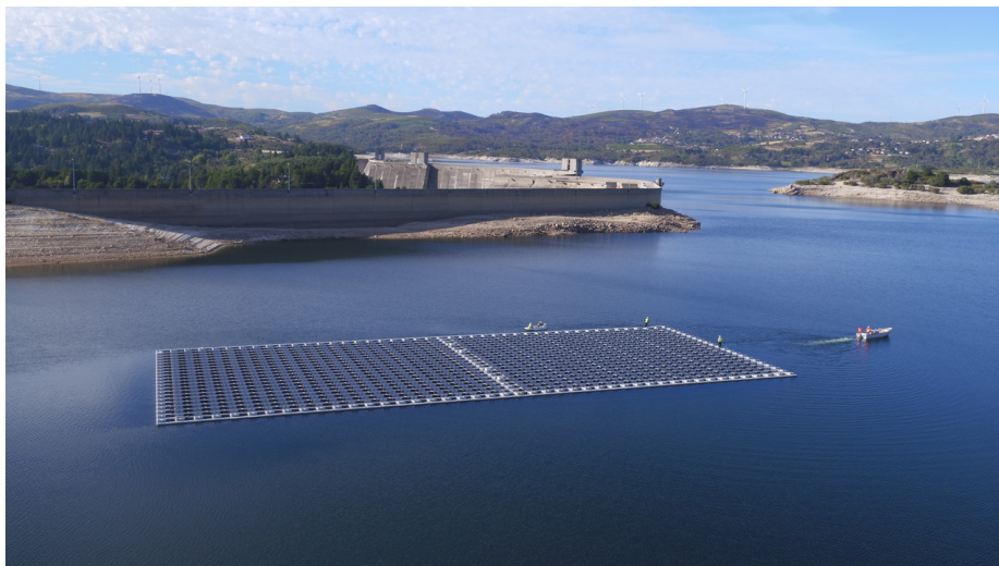
FIGURE 7.2 – Installation sur une retenue au Portugal (source : LinkedIn)
