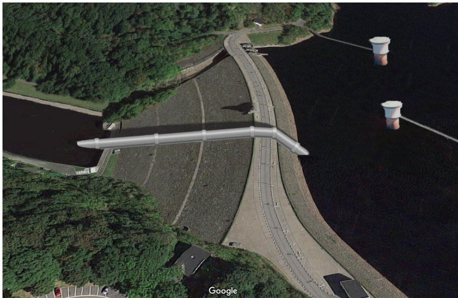
FIGURE 9.1 – Position du tuyau sur le barrage
