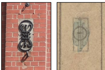
Ci-contre, une des ancrés présentes sur le bâtiment (à gauche), et le dessin original des ancrés (à droite). On remarque que le dessin n'est pas le même.
