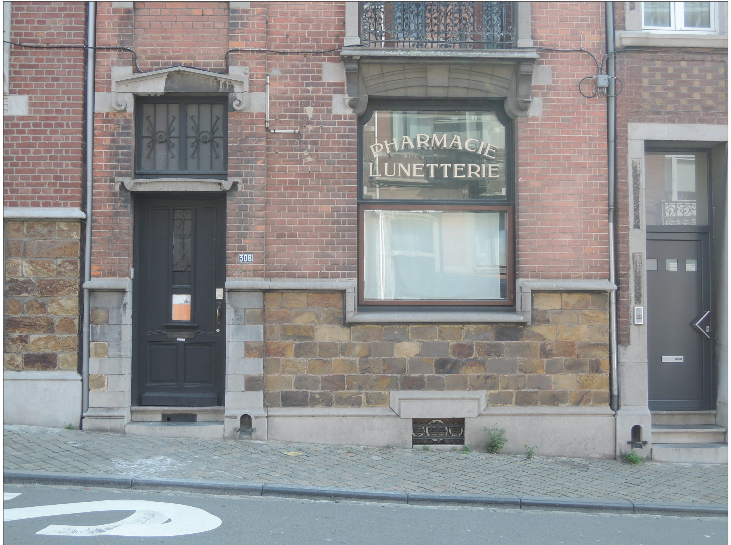
Photo © Hendrickx Guillaume ; 05/04/2019
