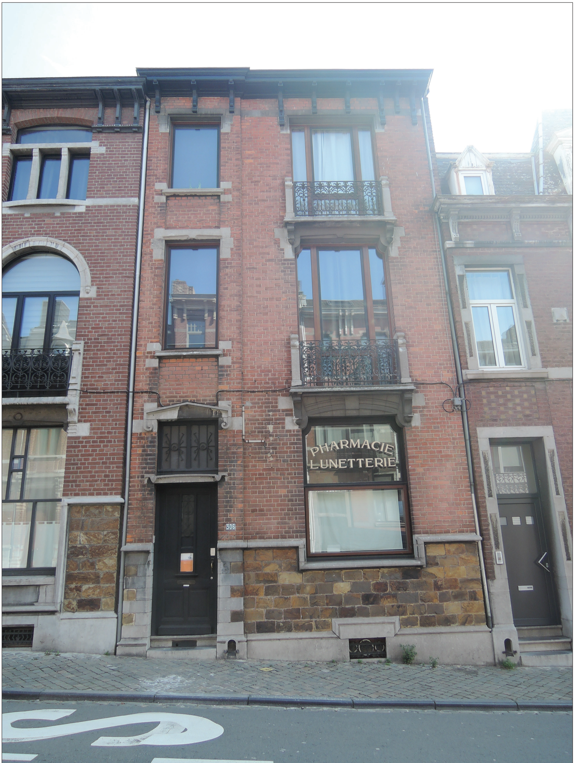
Photo © Hendrickx Guillaume ; 05/04/2019
