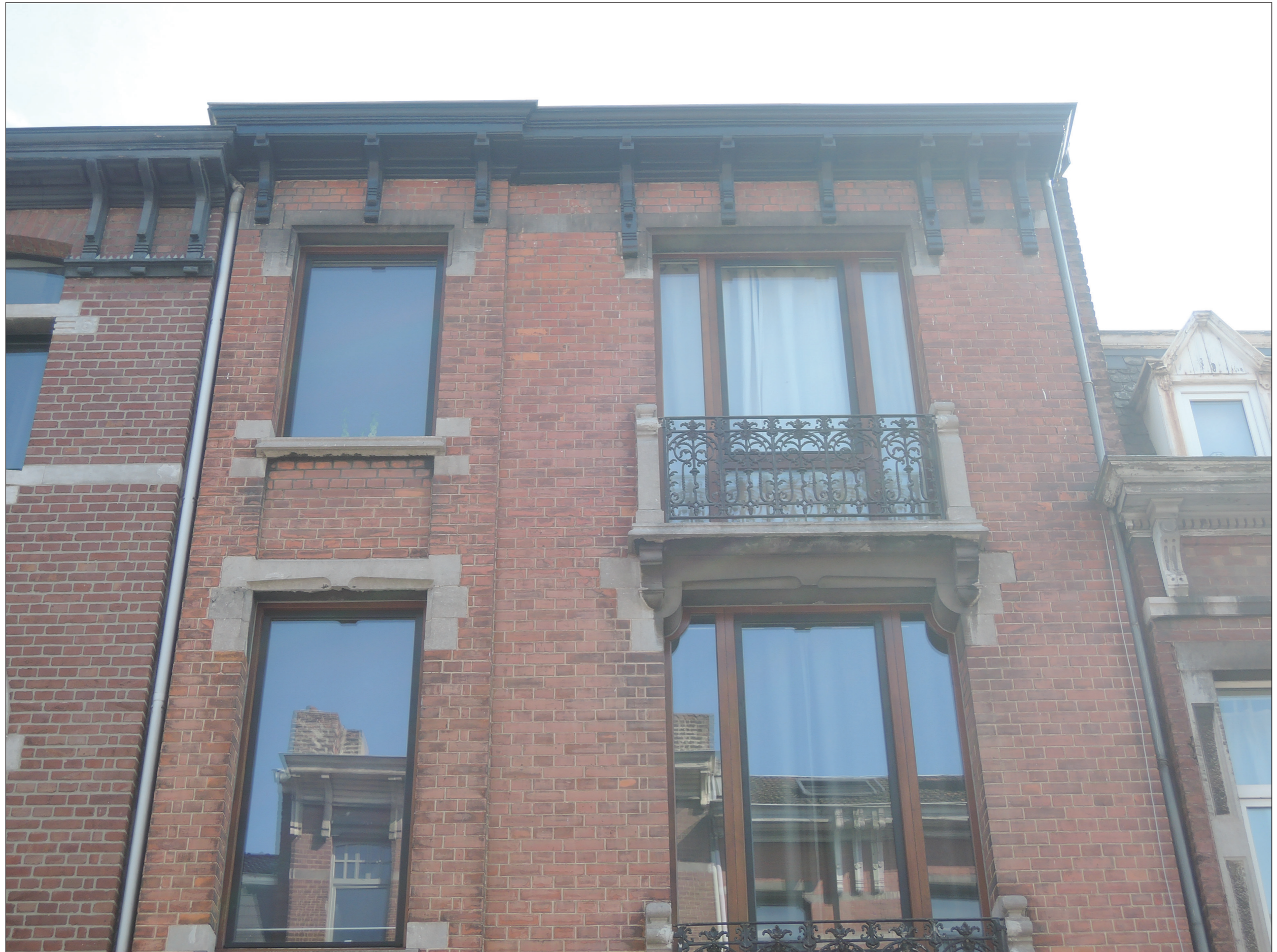
Photo © Hendrickx Guillaume ; 05/04/2019
