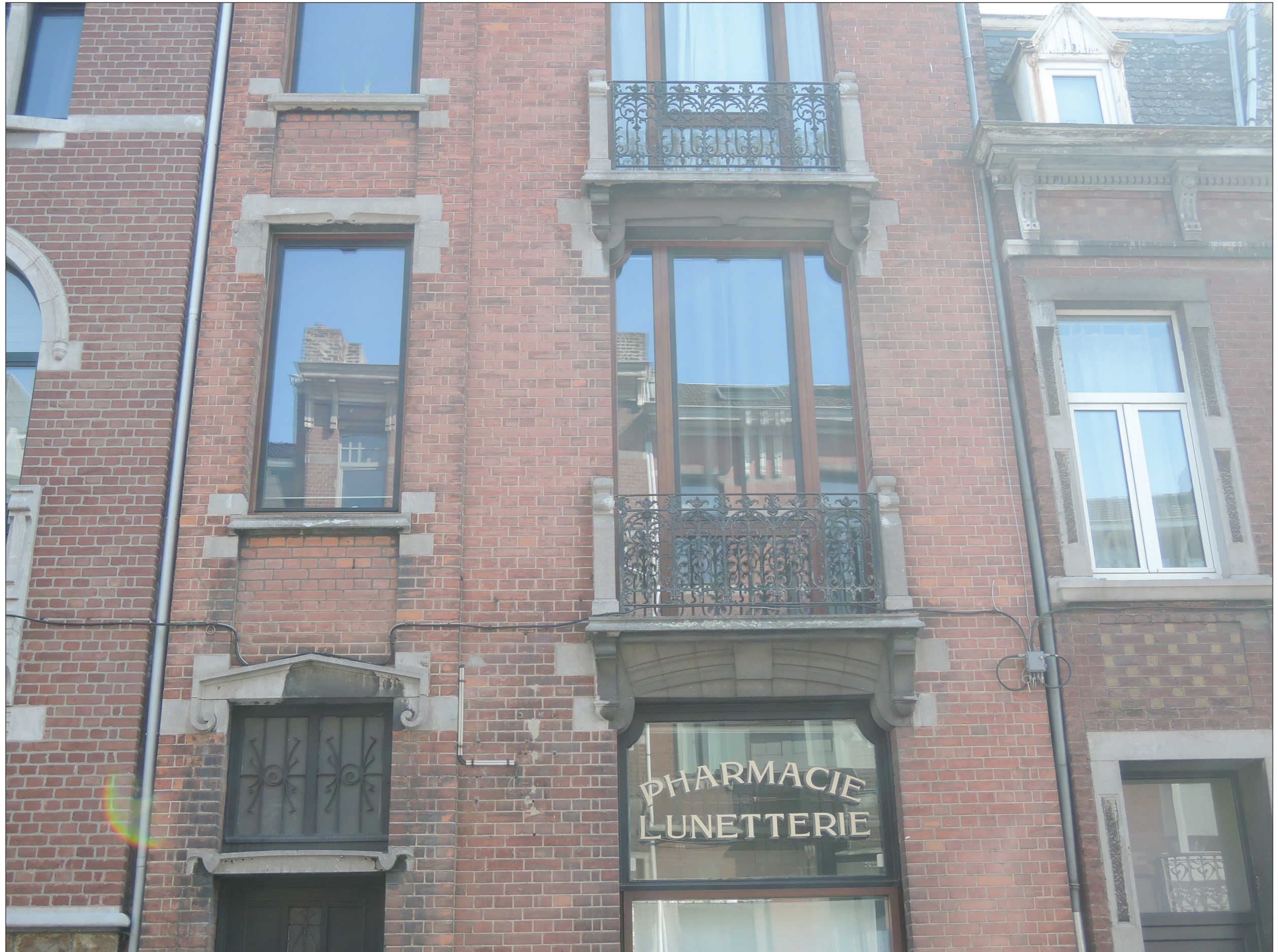
Photo © Hendrickx Guillaume ; 05/04/2019
