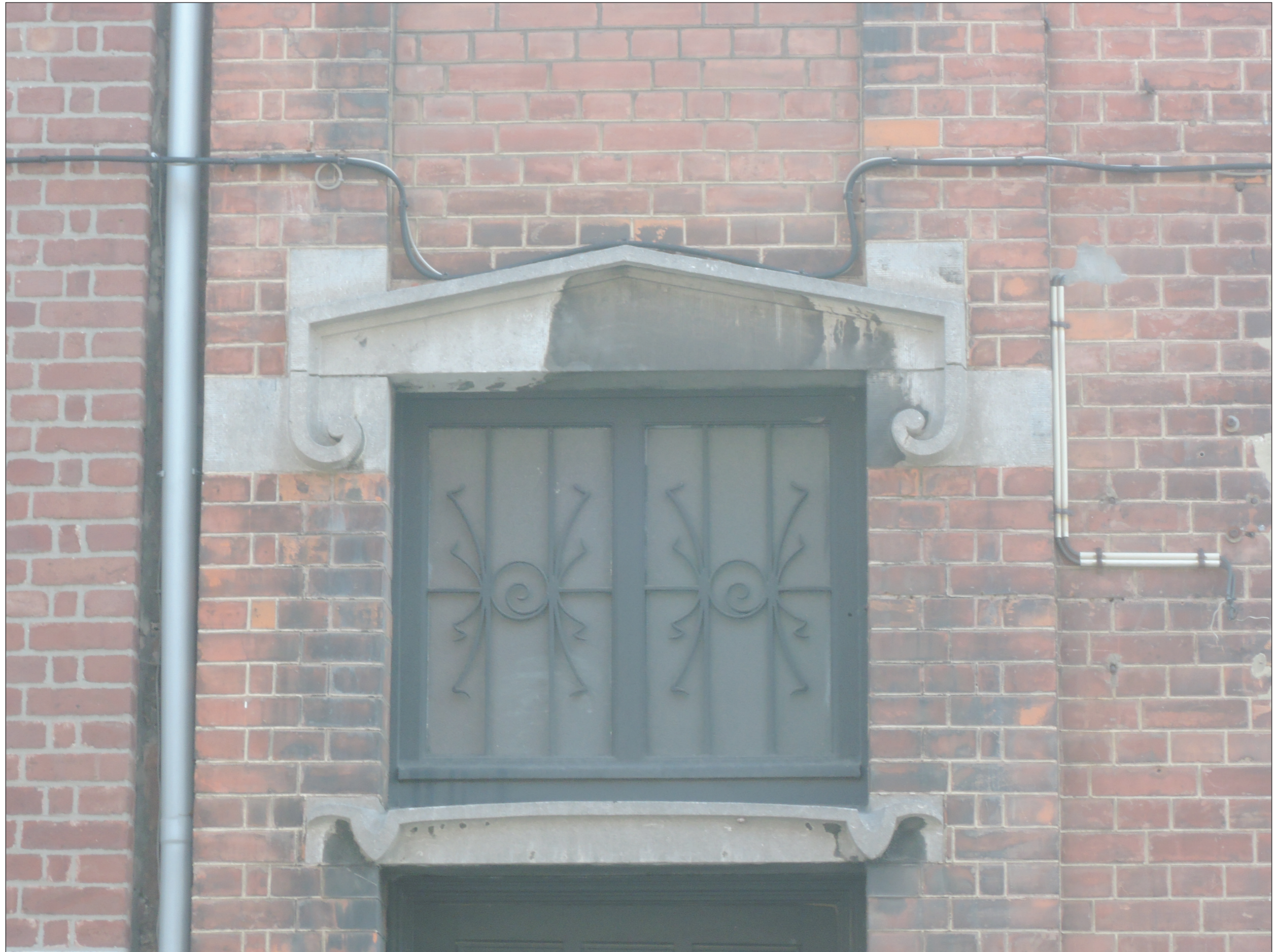
Photo © Hendrickx Guillaume ; 05/04/2019
