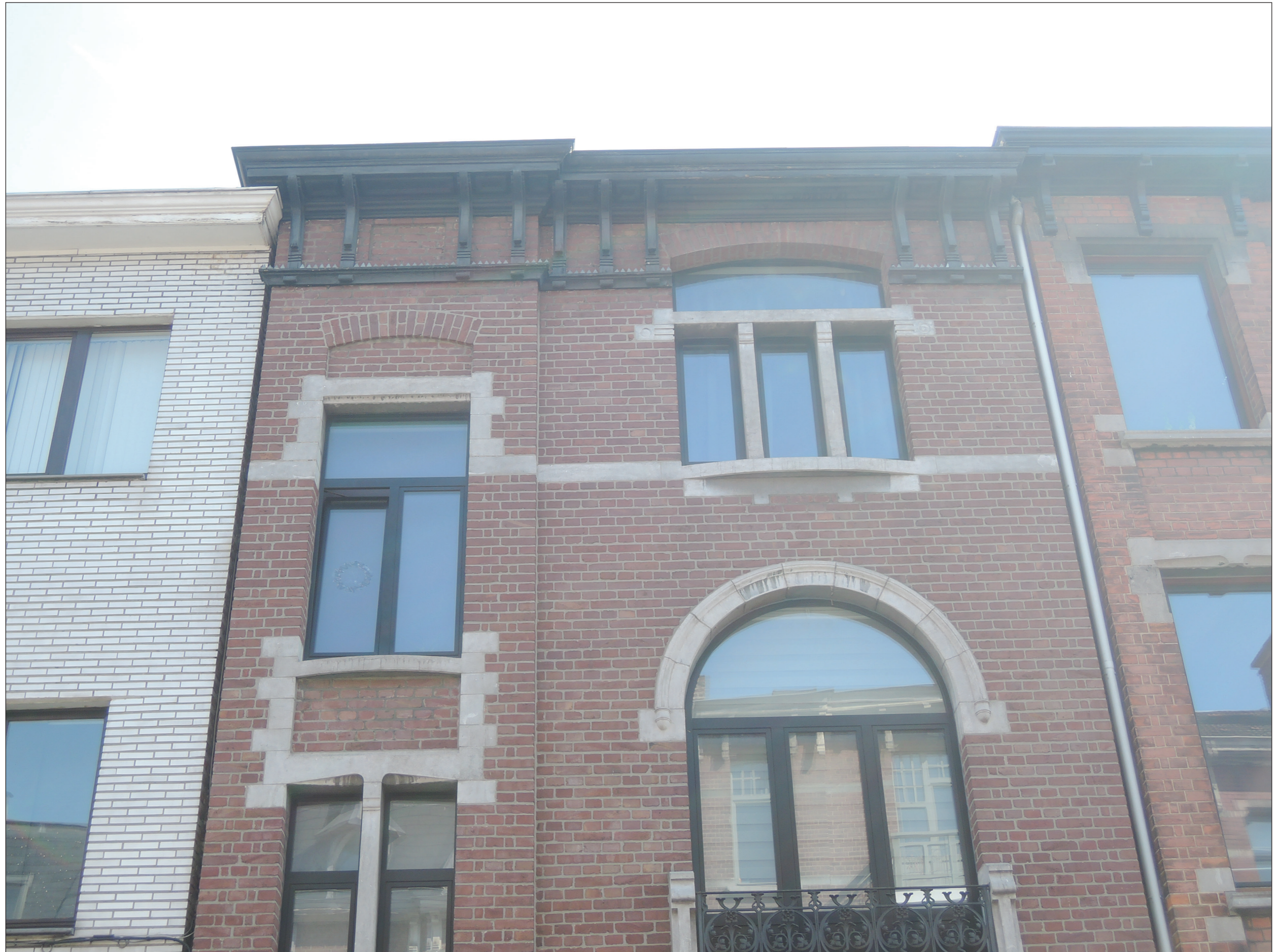
Photo © Hendrickx Guillaume ; 05/04/2019
