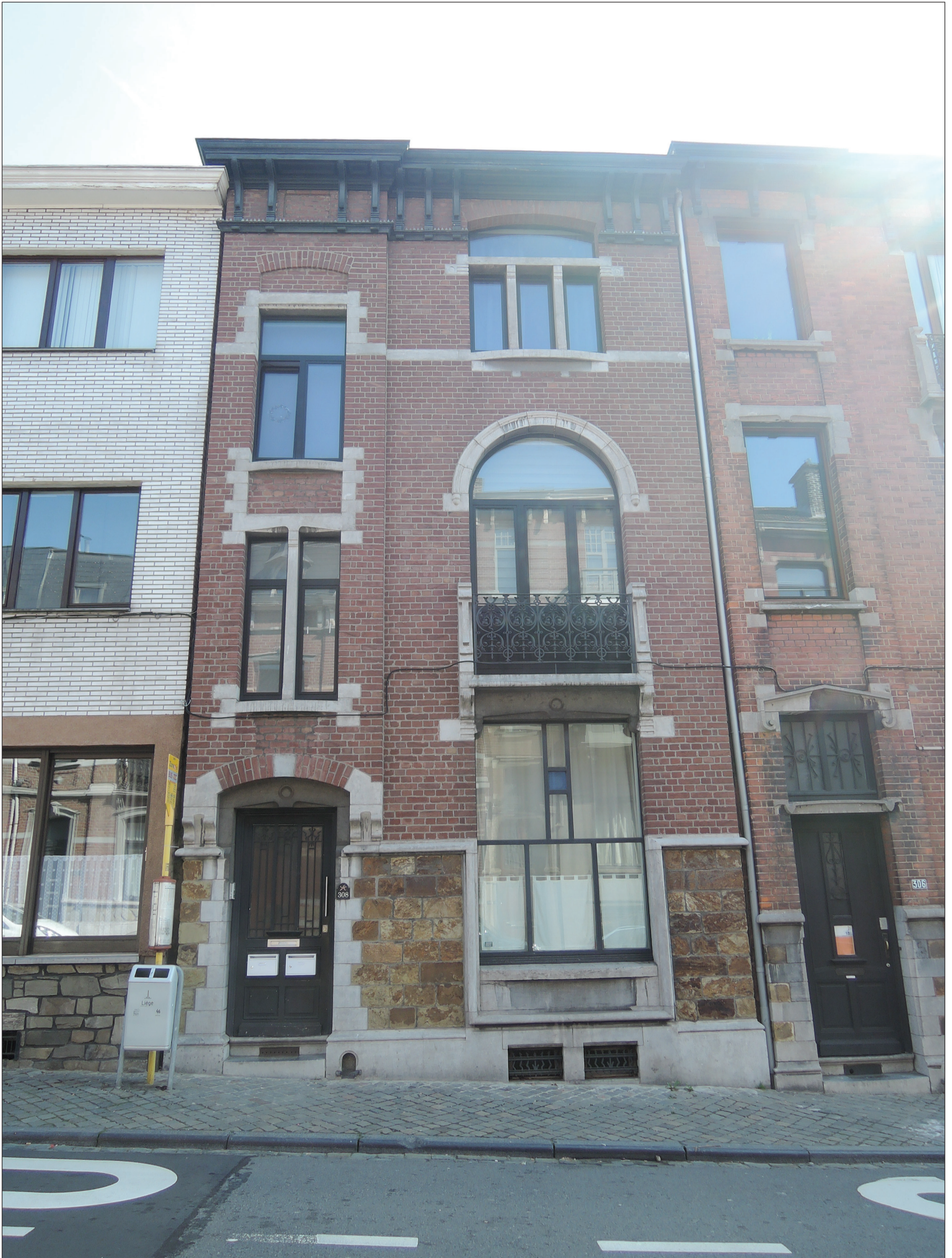
Photo © Hendrickx Guillaume ; 05/04/2019
