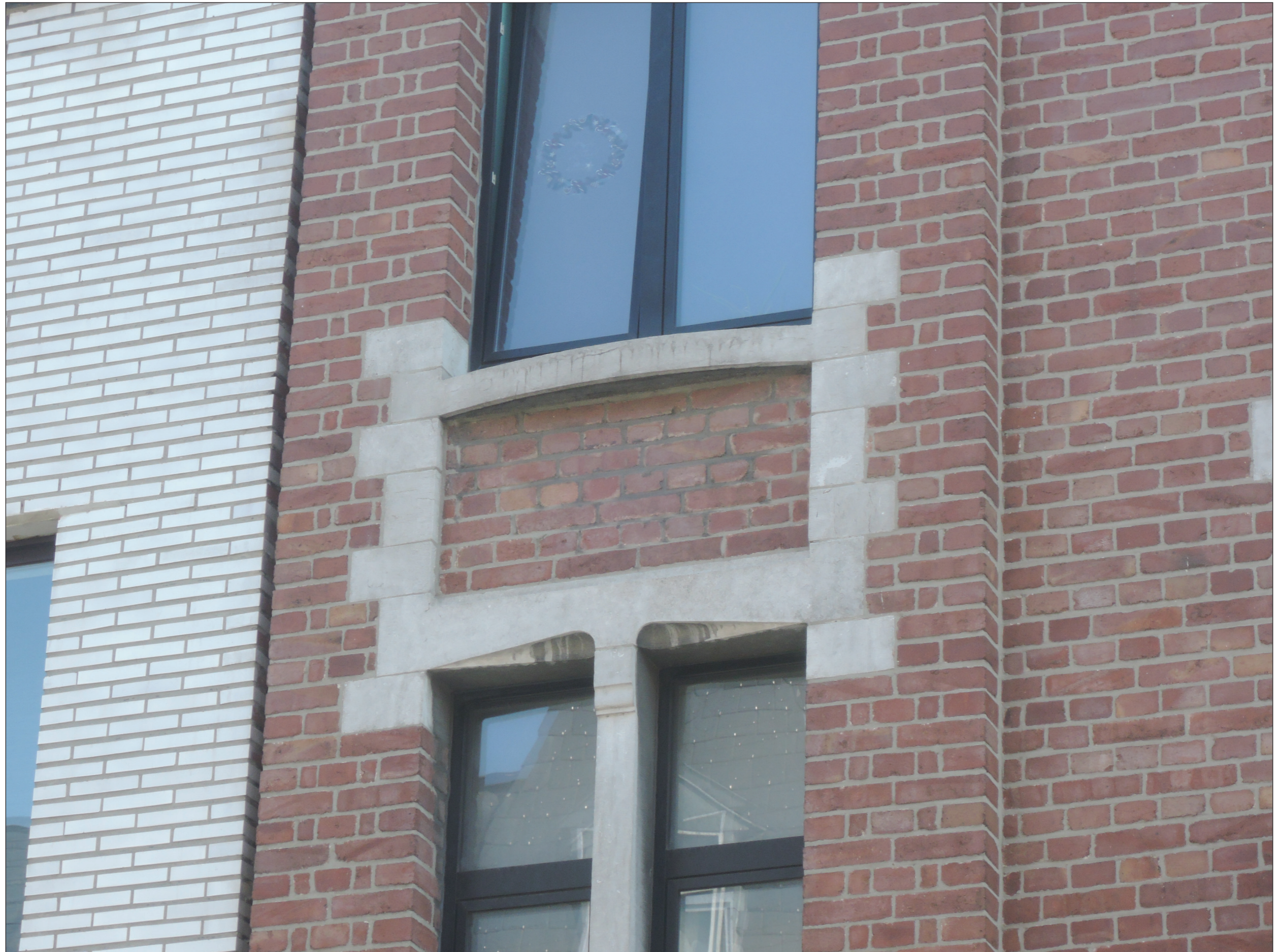
Photo © Hendrickx Guillaume ; 05/04/2019
