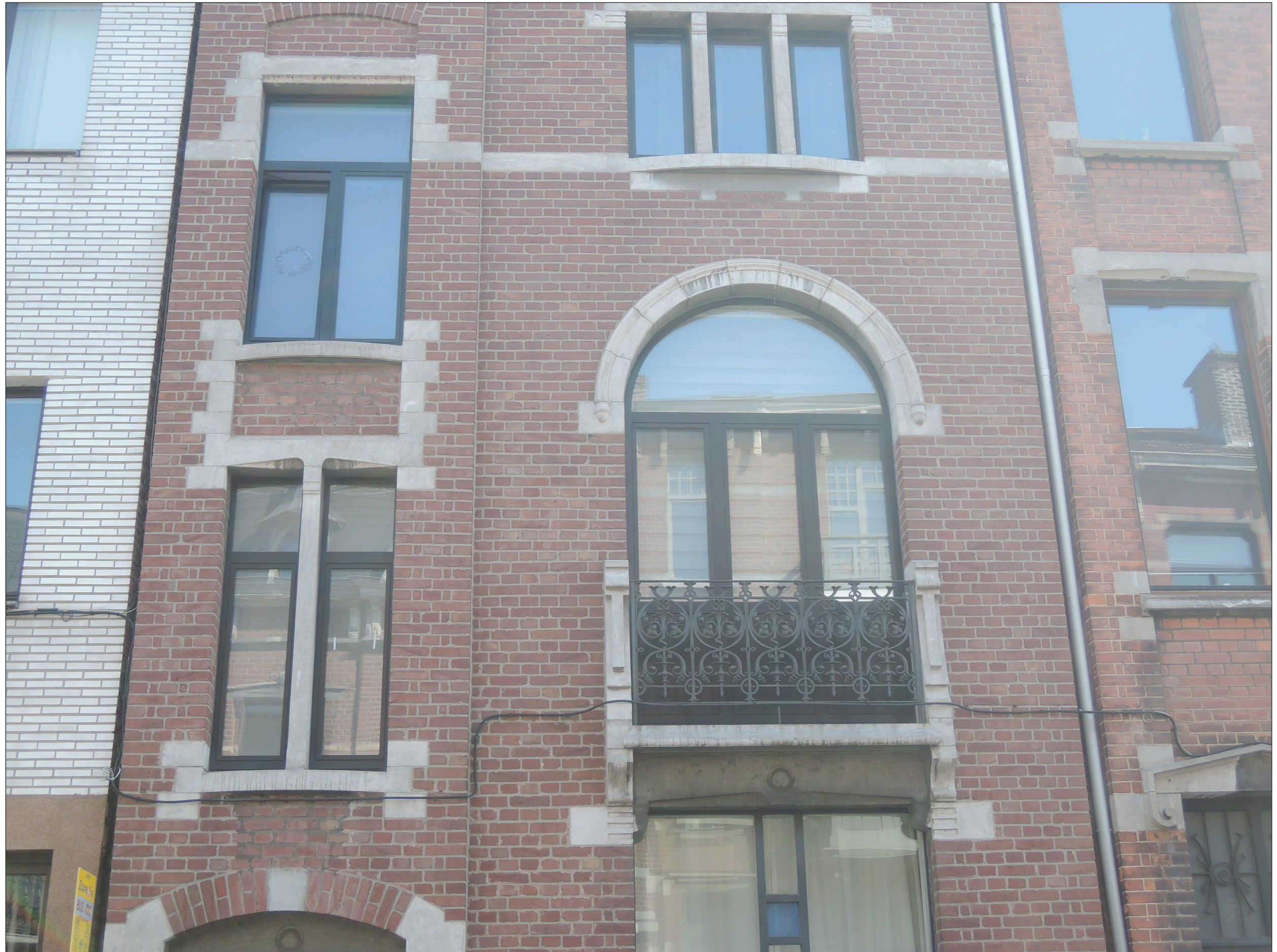
Photo © Hendrickx Guillaume ; 05/04/2019
