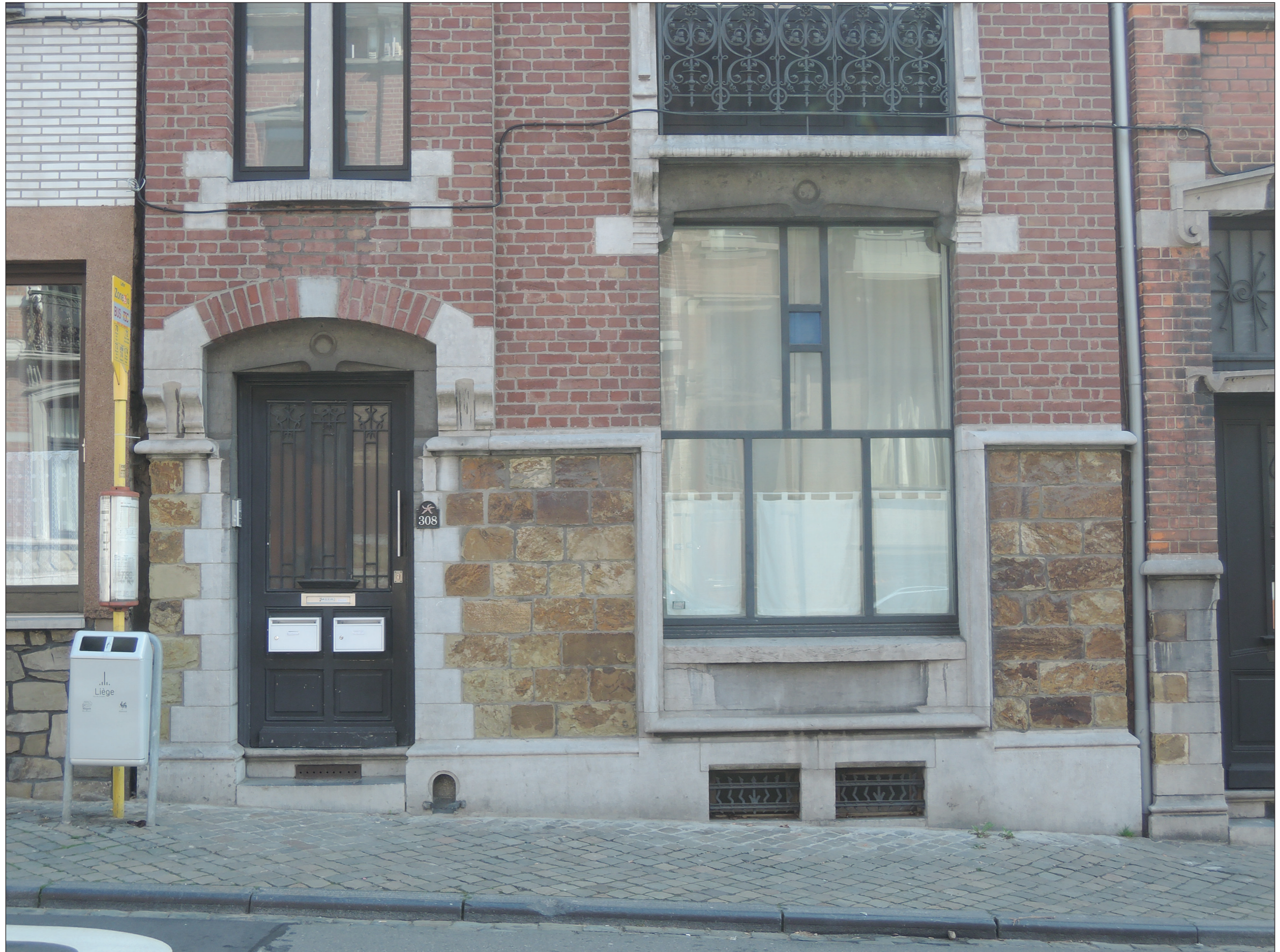
Photo © Hendrickx Guillaume ; 05/04/2019
