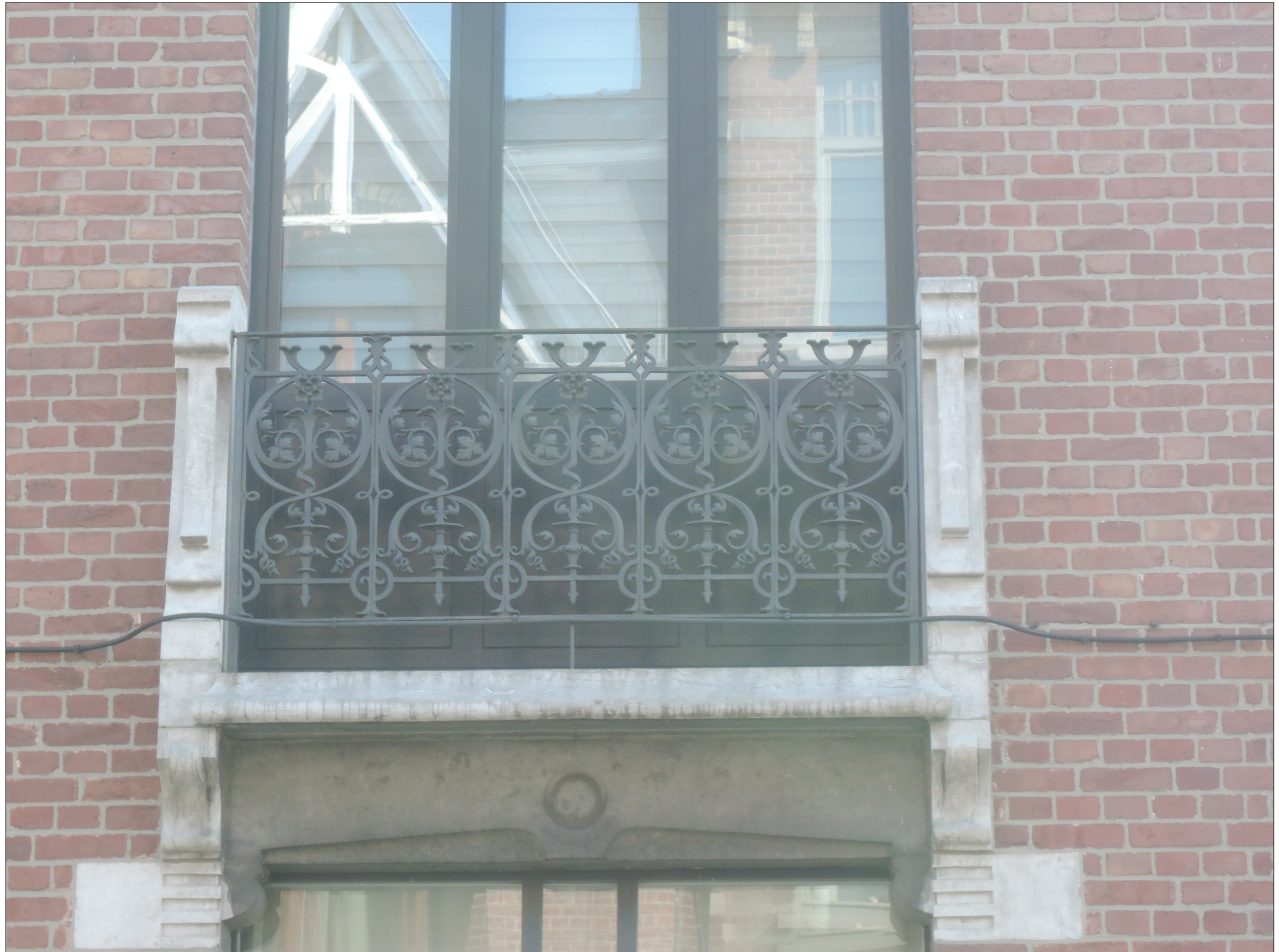
Photo © Hendrickx Guillaume ; 05/04/2019
