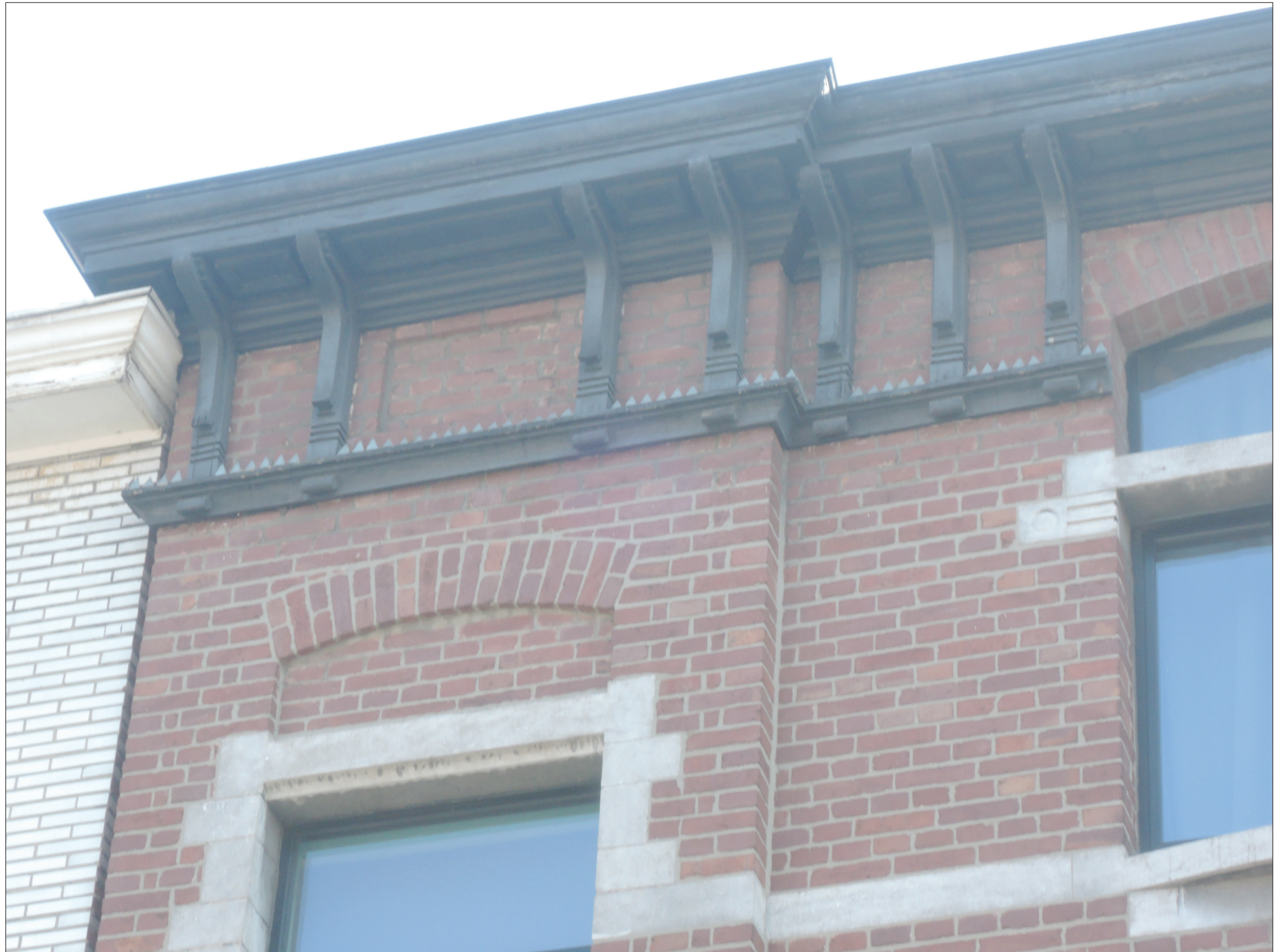
Photo © Hendrickx Guillaume ; 05/04/2019
