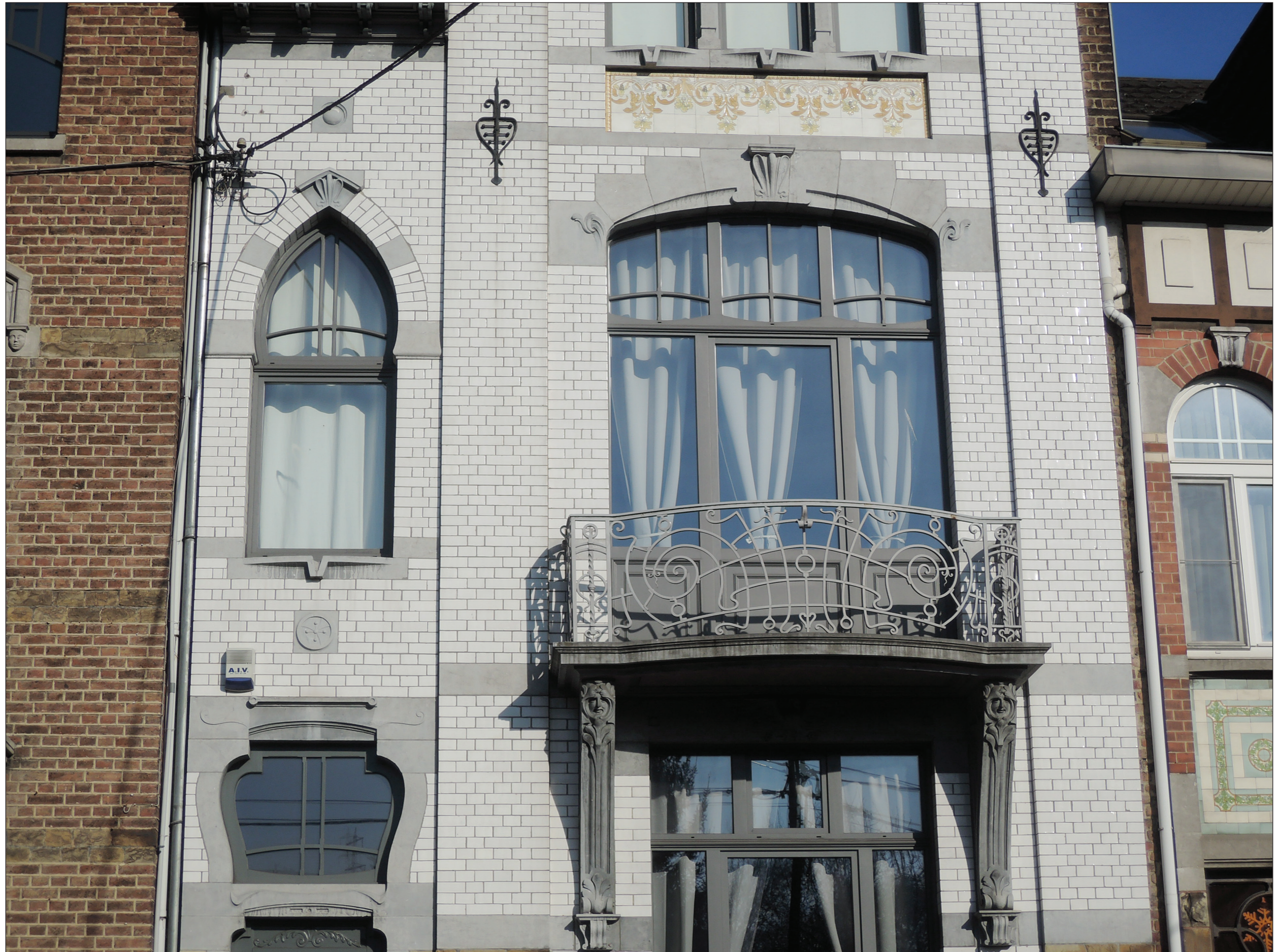
Photo © Hendrickx Guillaume ; 05/04/2019
