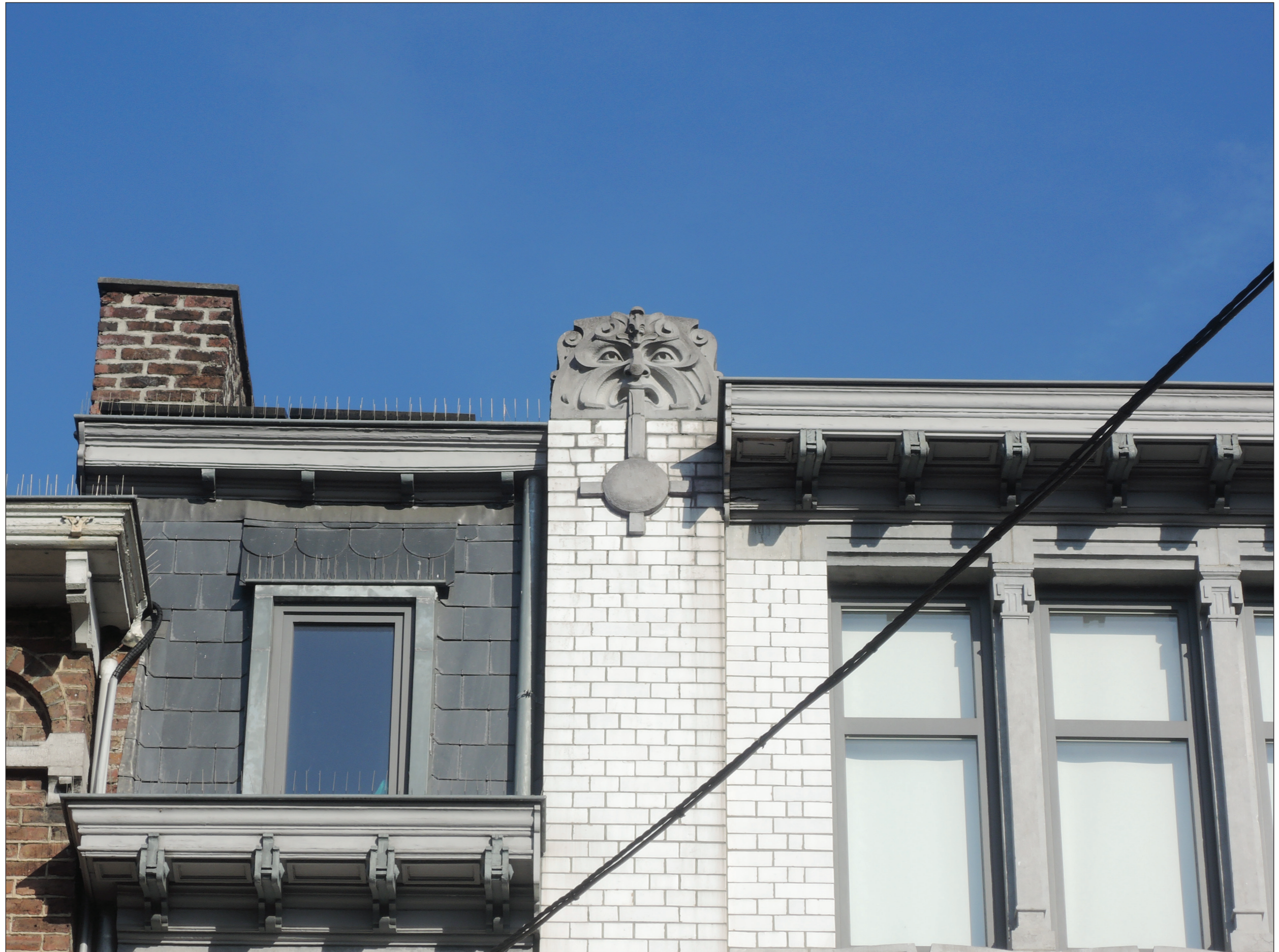
Photo © Hendrickx Guillaume ; 05/04/2019
