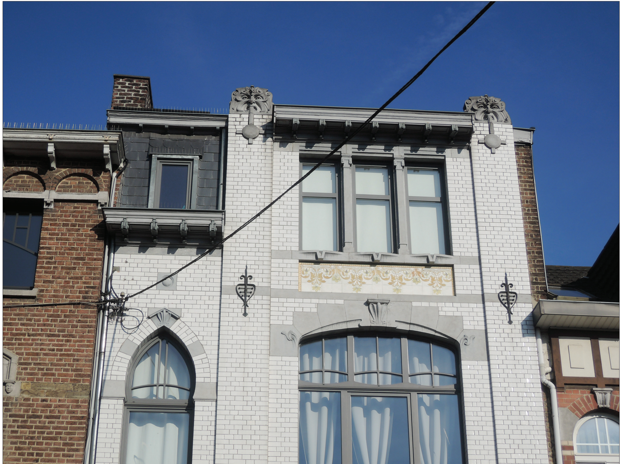
Photo © Hendrickx Guillaume ; 05/04/2019
