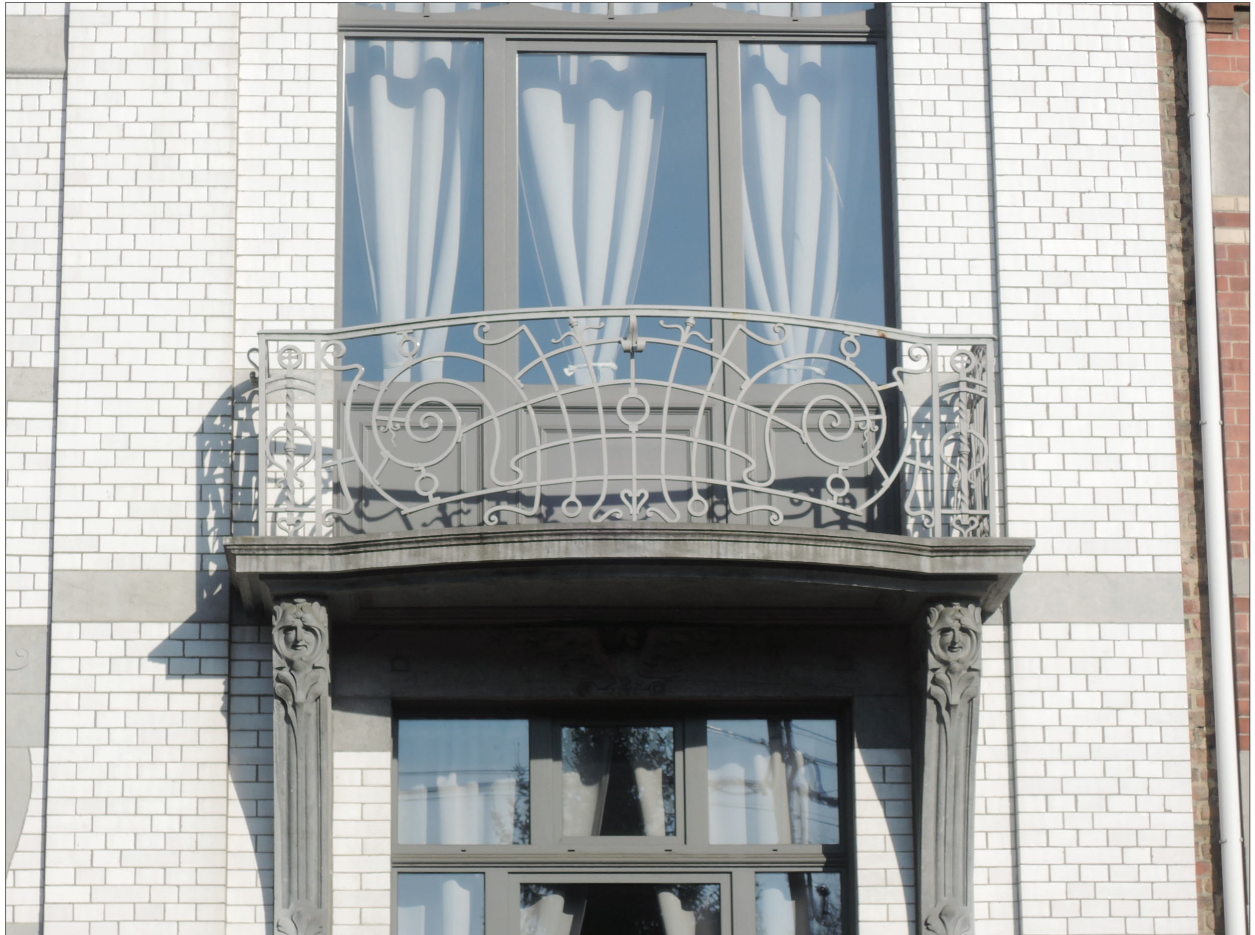
Photo © Hendrickx Guillaume ; 05/04/2019
