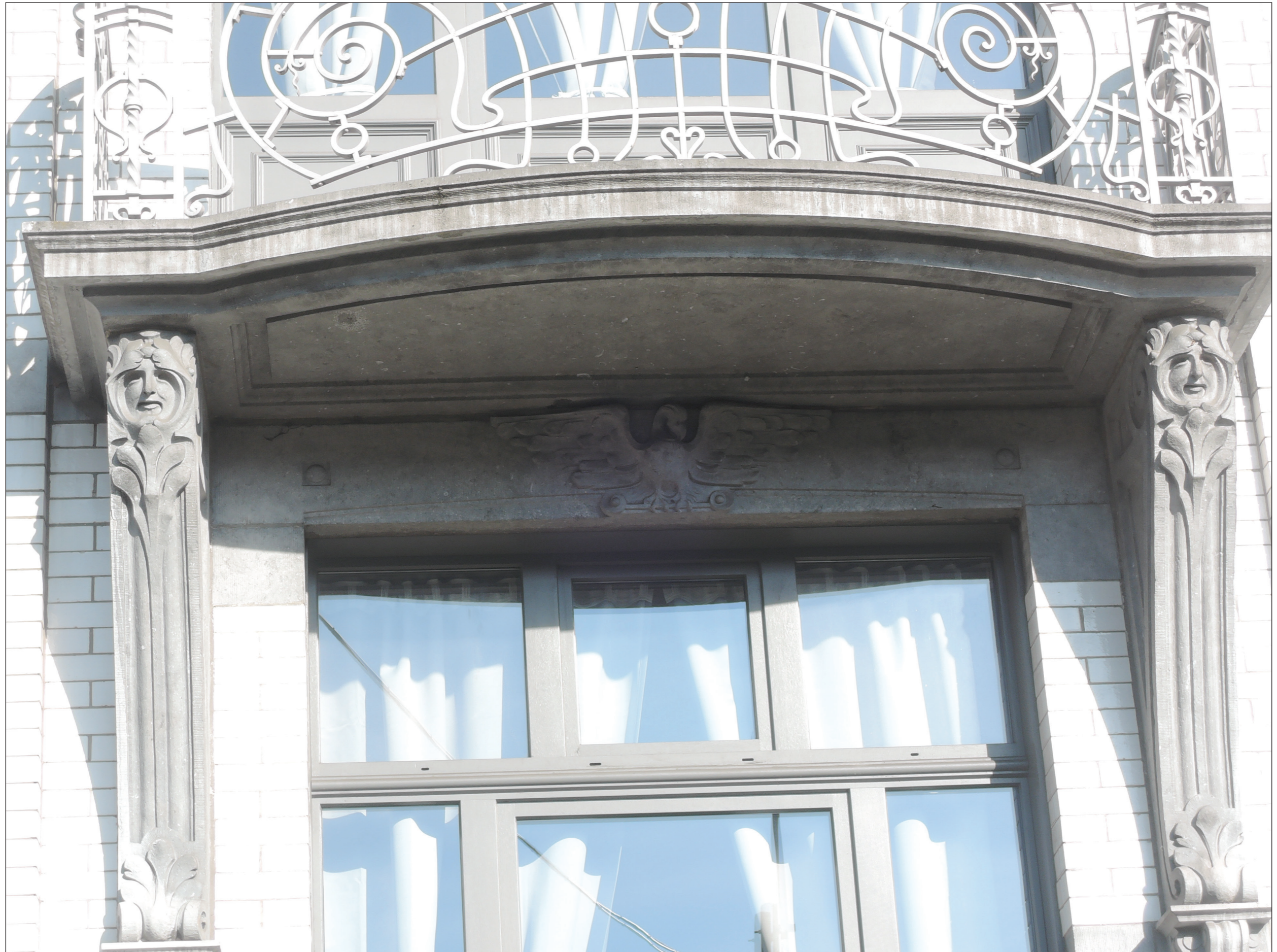
Photo © Hendrickx Guillaume ; 05/04/2019
