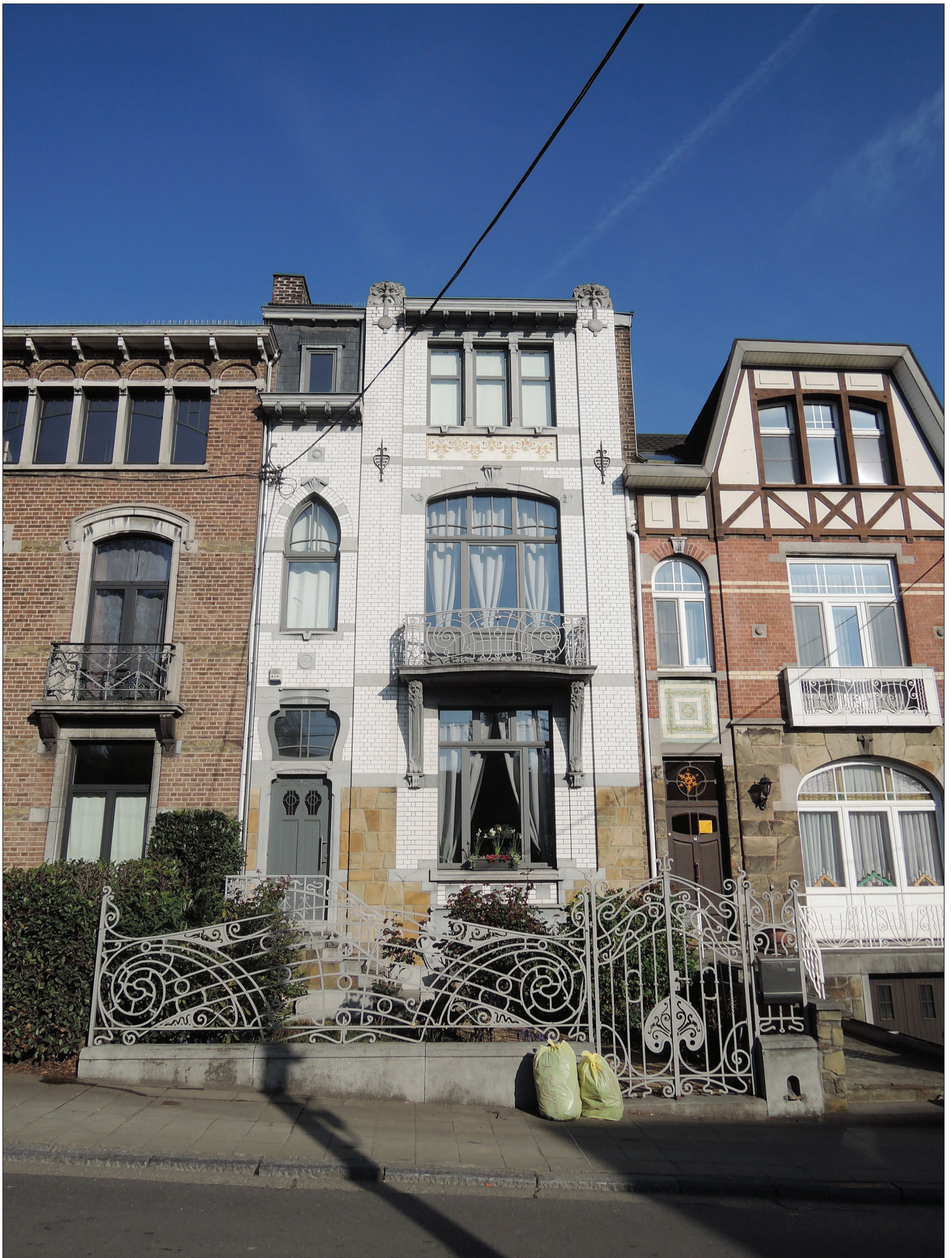
Photo © Hendrickx Guillaume ; 05/04/2019
