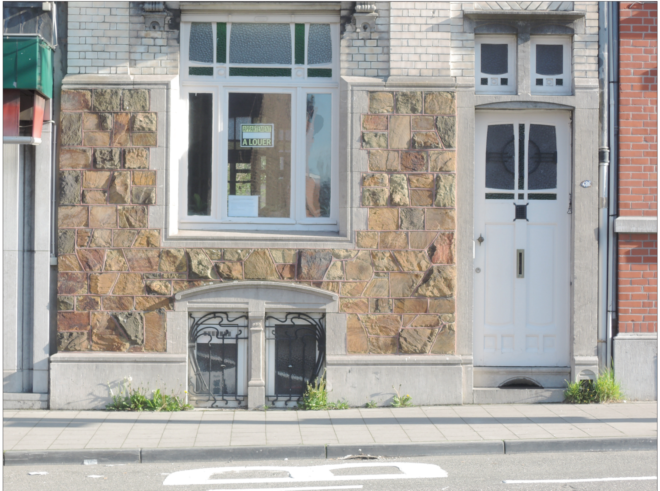
Photo © Hendrickx Guillaume ; 05/04/2019
