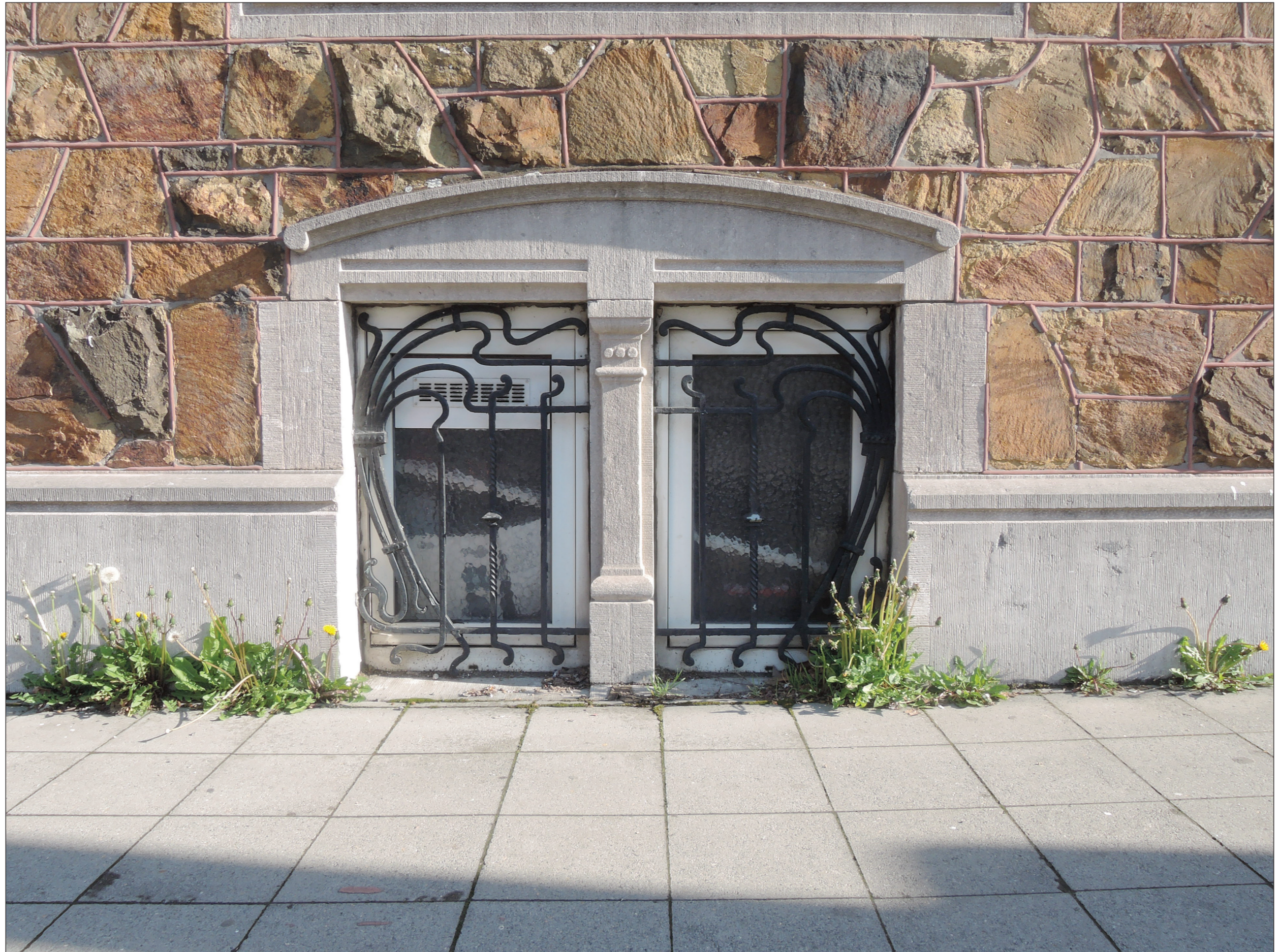
Photo © Hendrickx Guillaume ; 05/04/2019
