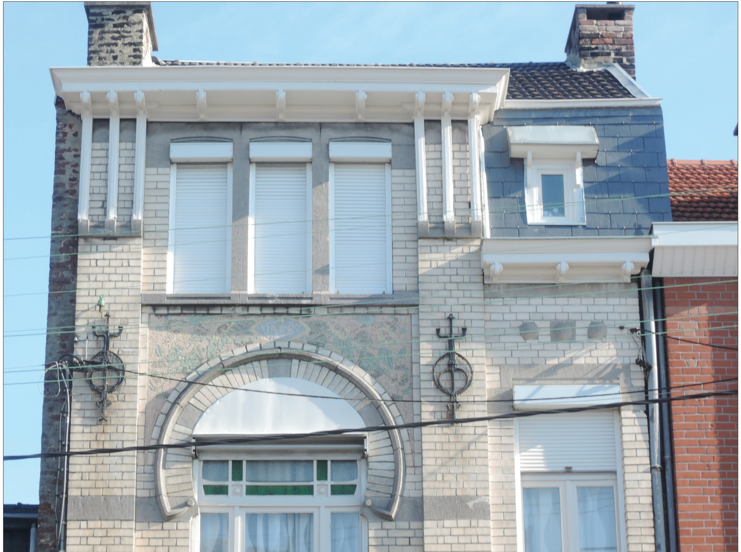
Photo © Hendrickx Guillaume ; 05/04/2019
