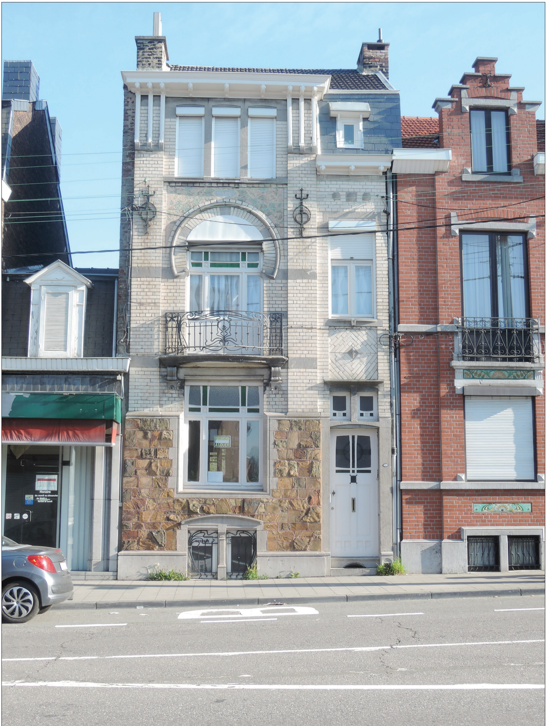
Photo © Hendrickx Guillaume ; 05/04/2019
