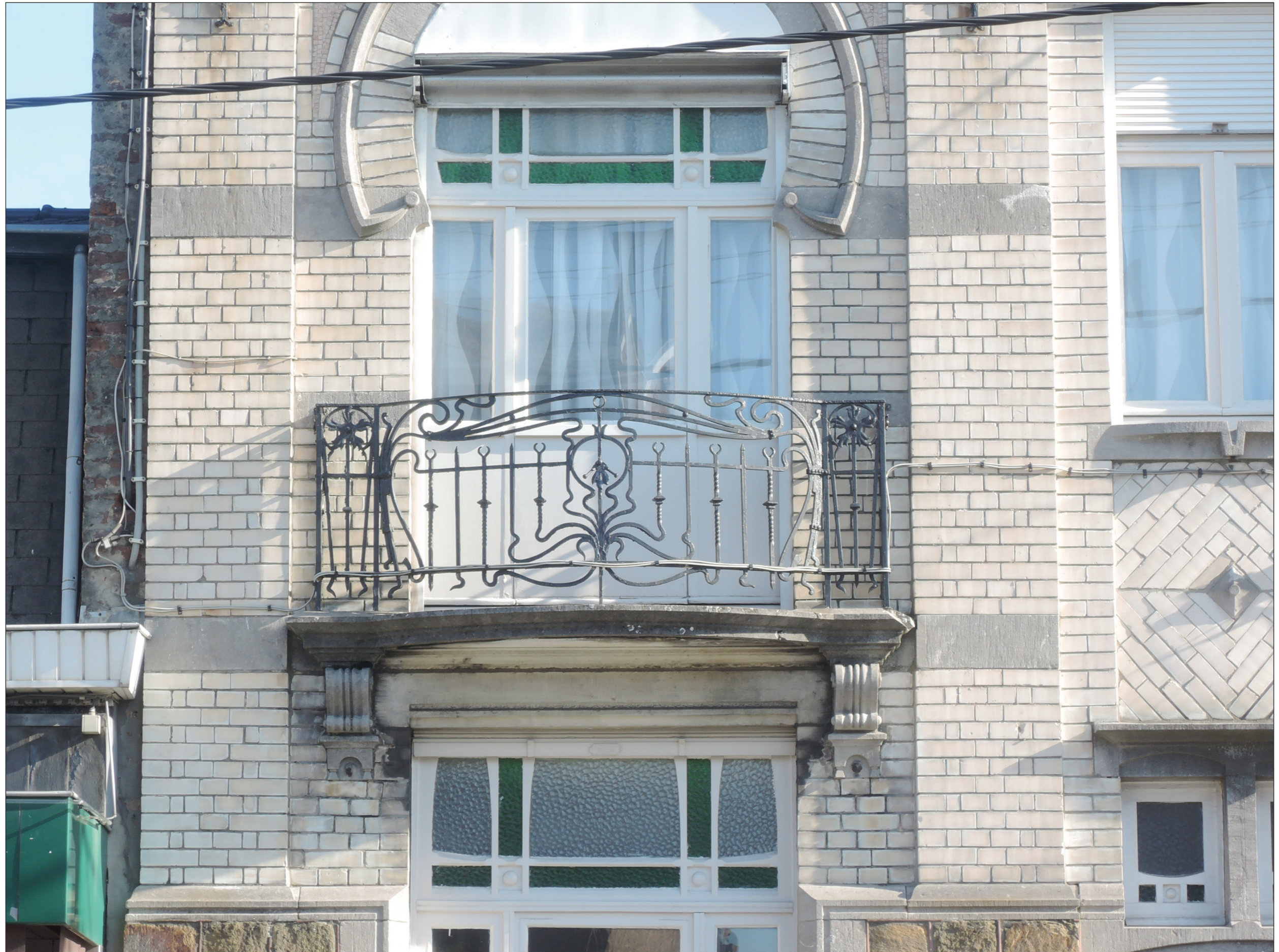
Photo © Hendrickx Guillaume ; 05/04/2019
