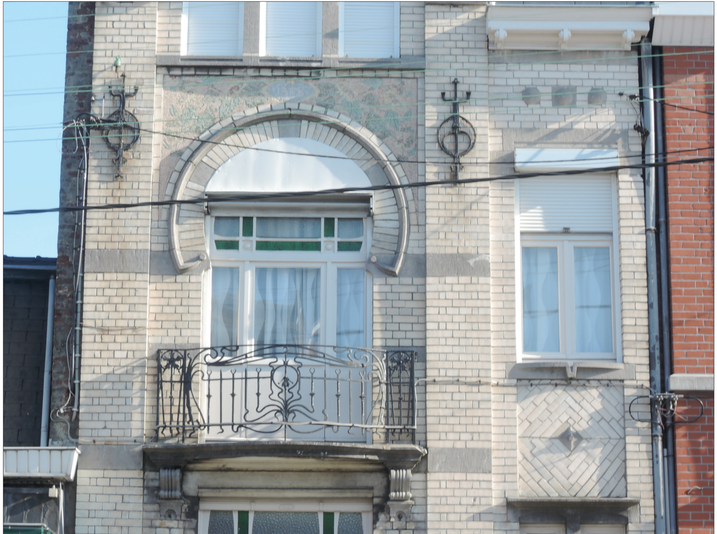
Photo © Hendrickx Guillaume ; 05/04/2019
