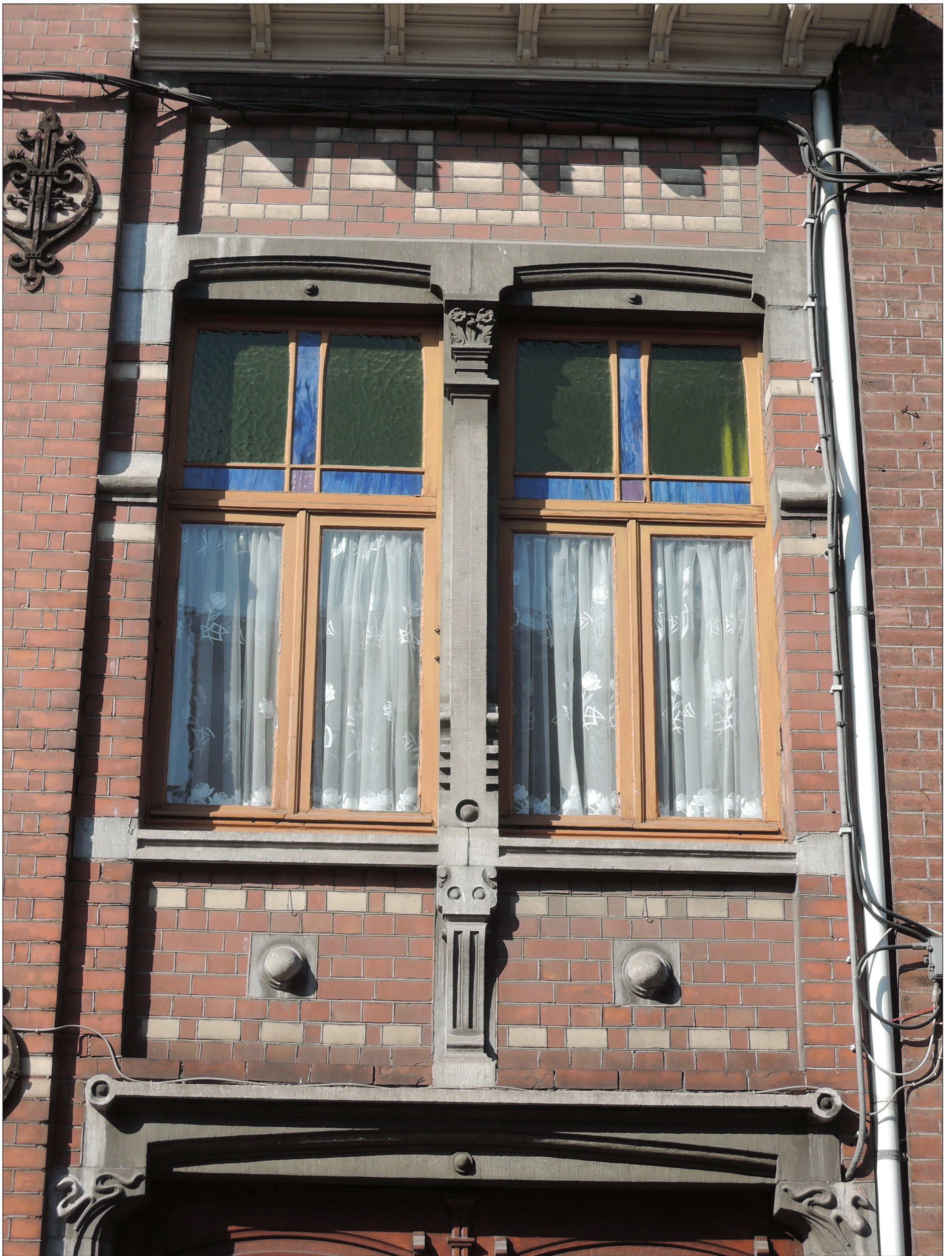
Photo © Hendrickx Guillaume ; 05/04/2019
