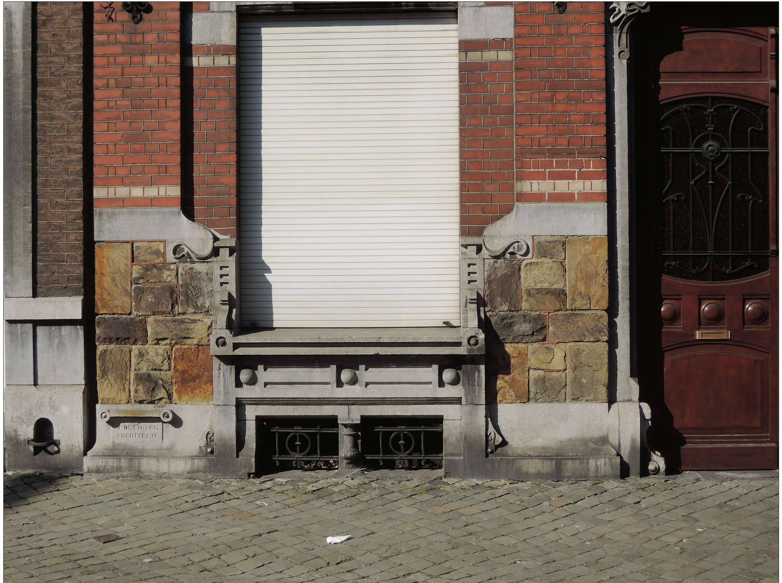
Photo © Hendrickx Guillaume ; 05/04/2019
