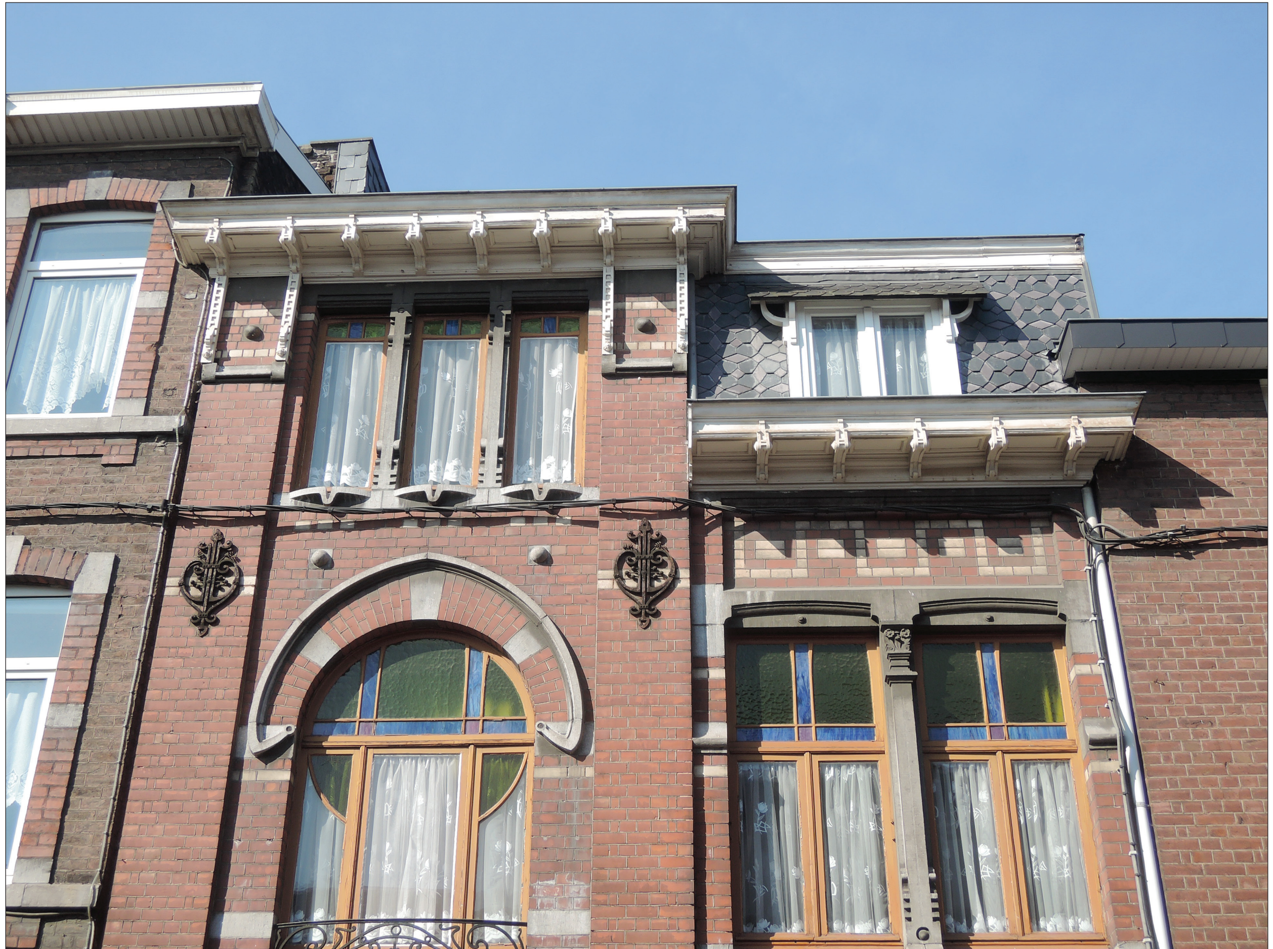
Photo © Hendrickx Guillaume ; 05/04/2019
