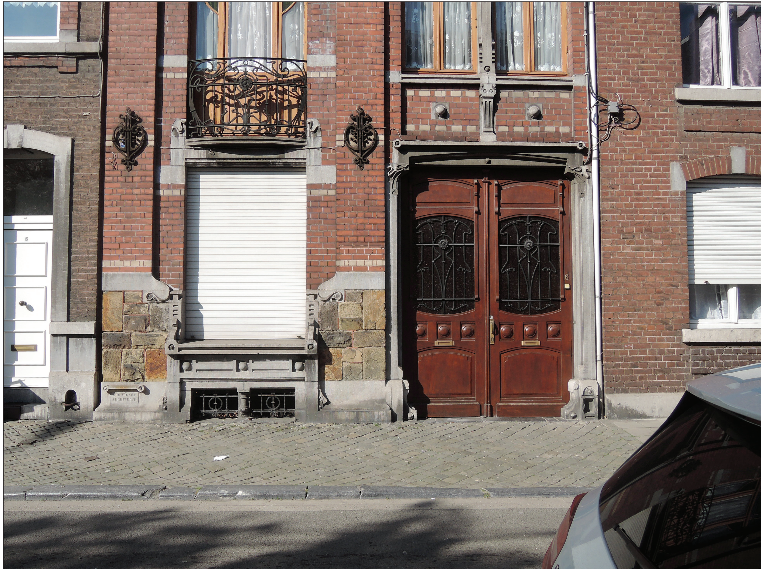
Photo © Hendrickx Guillaume ; 05/04/2019
