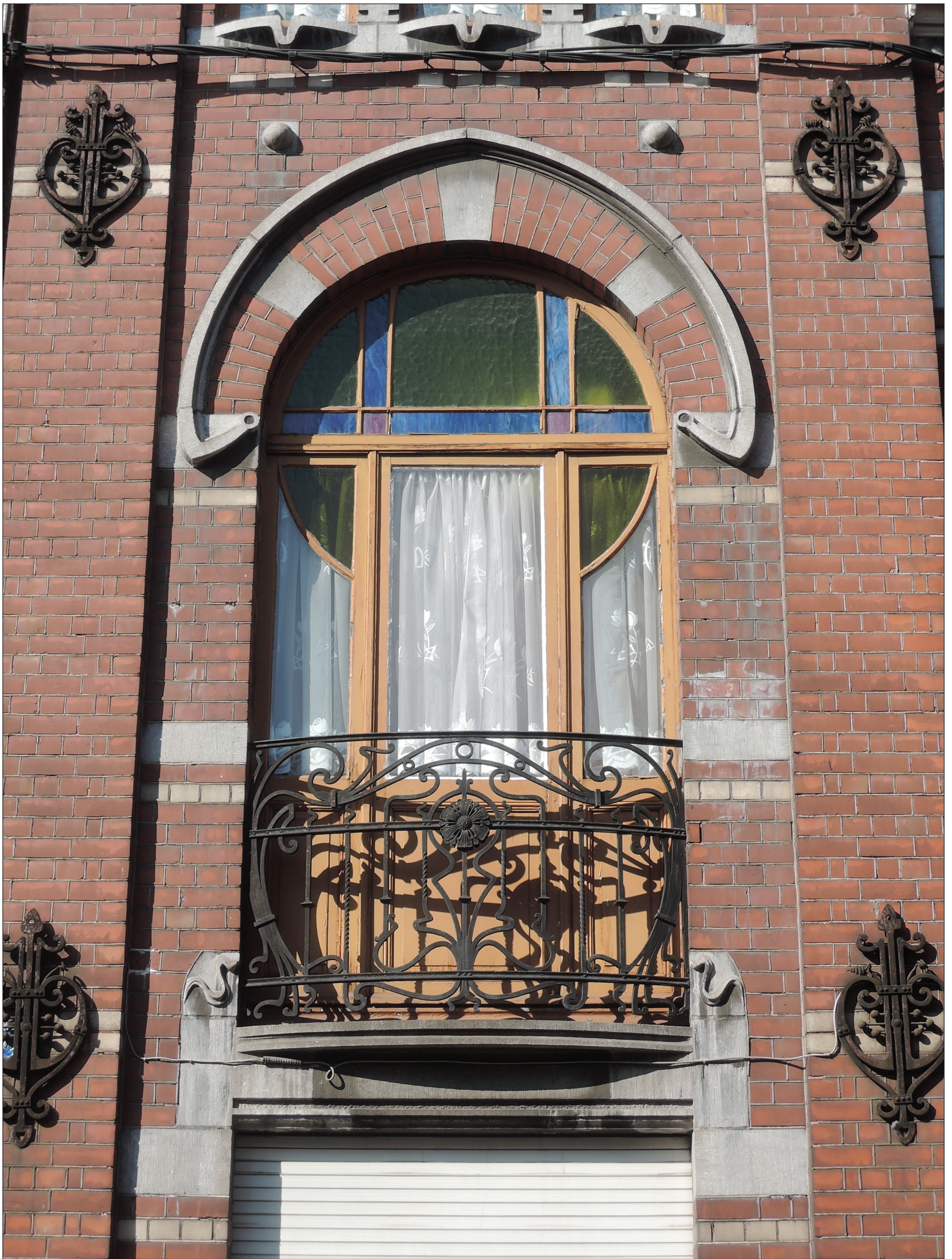
Photo © Hendrickx Guillaume ; 05/04/2019
