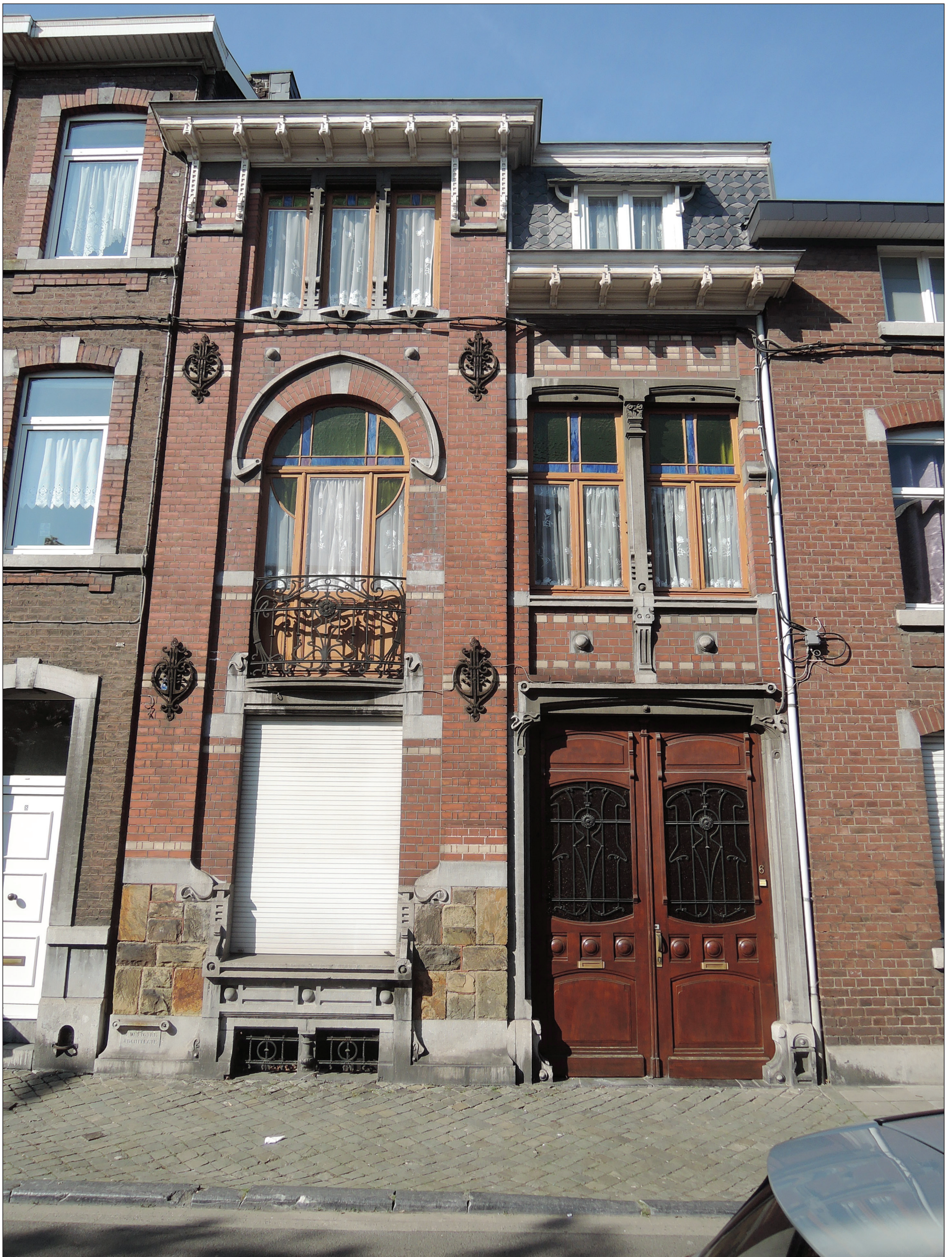
Photo © Hendrickx Guillaume ; 05/04/2019
