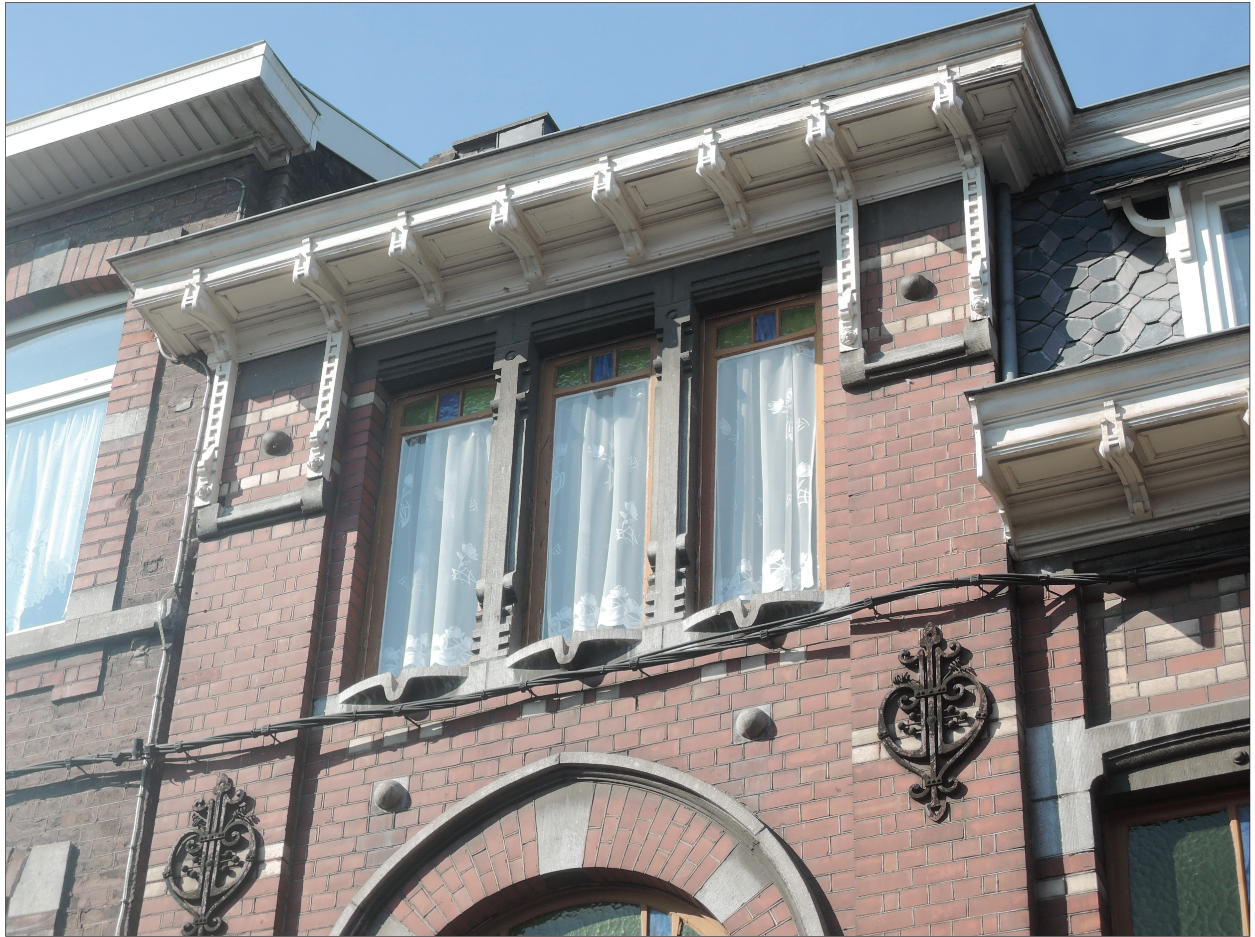
Photo © Hendrickx Guillaume ; 05/04/2019
