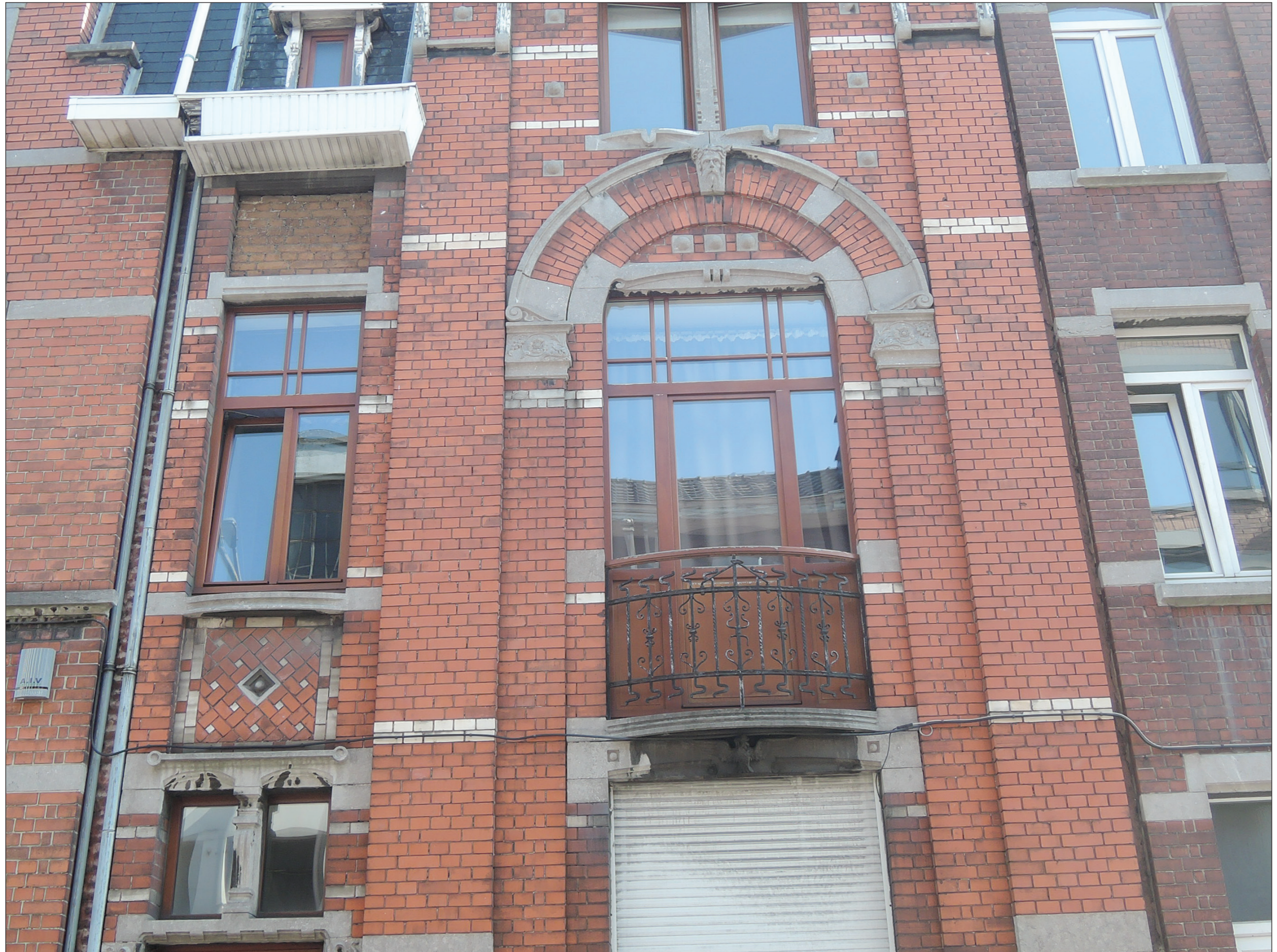
Photo © Hendrickx Guillaume ; 05/04/2019
