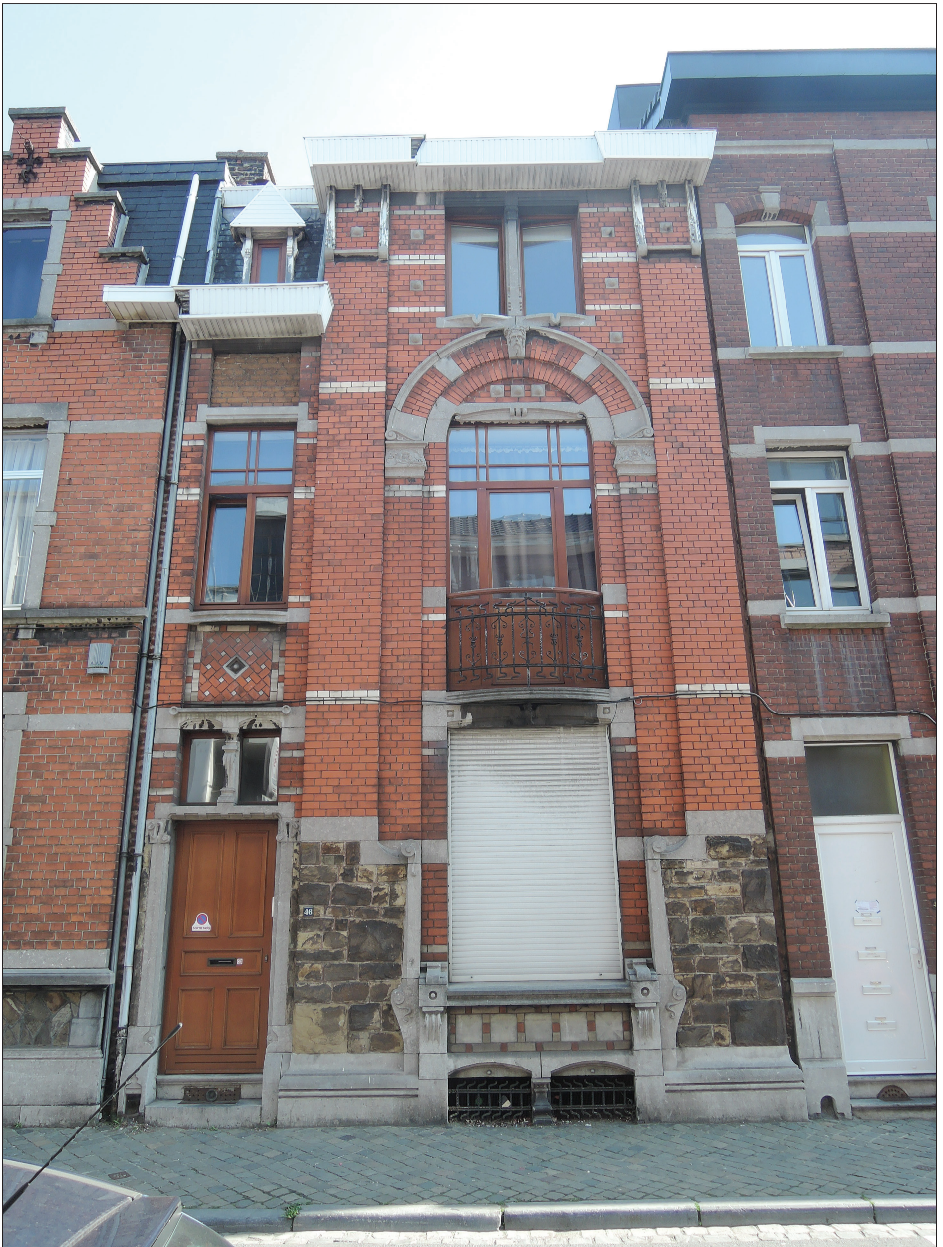
Photo © Hendrickx Guillaume ; 05/04/2019
