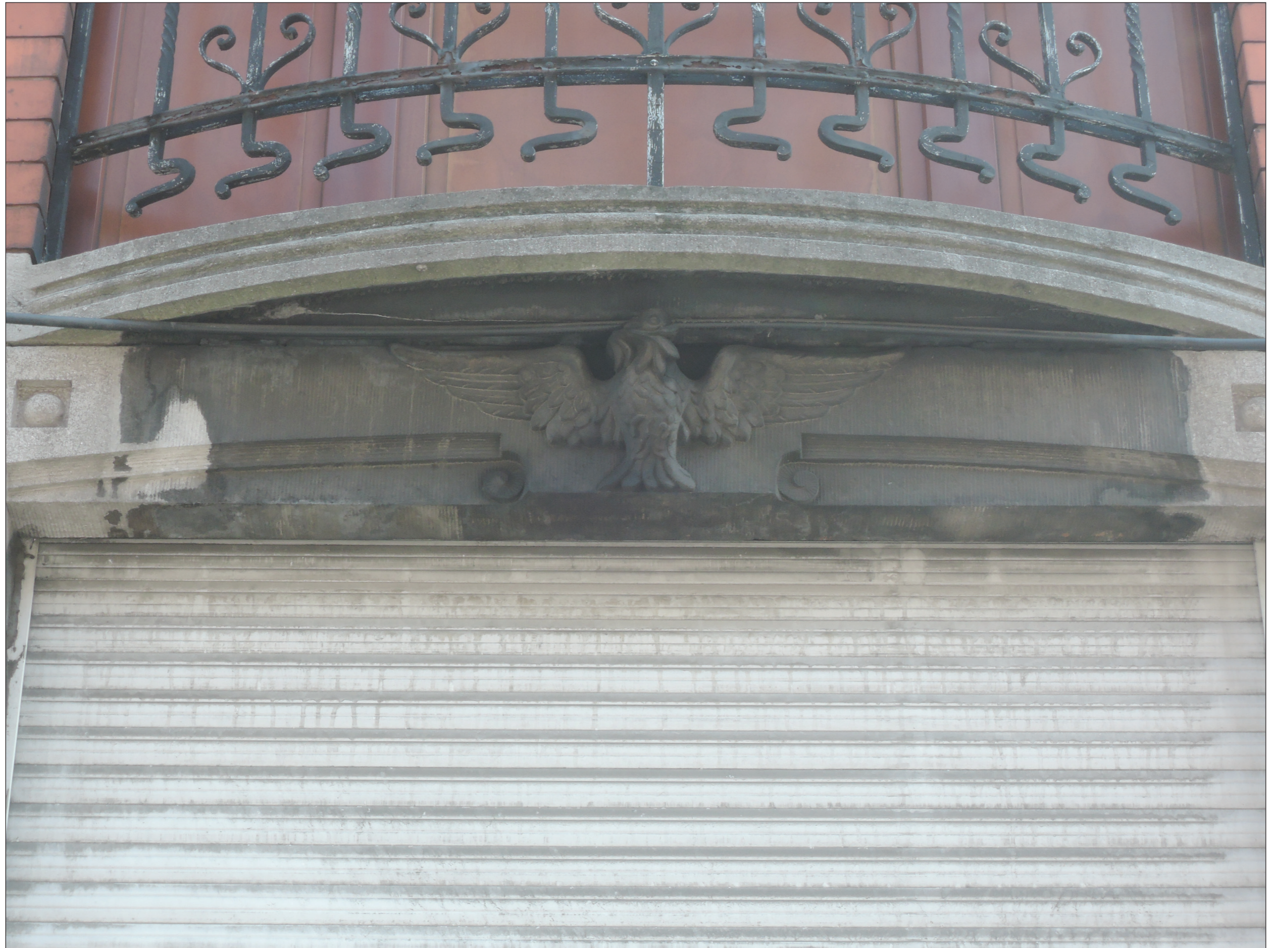
Photo © Hendrickx Guillaume ; 05/04/2019
