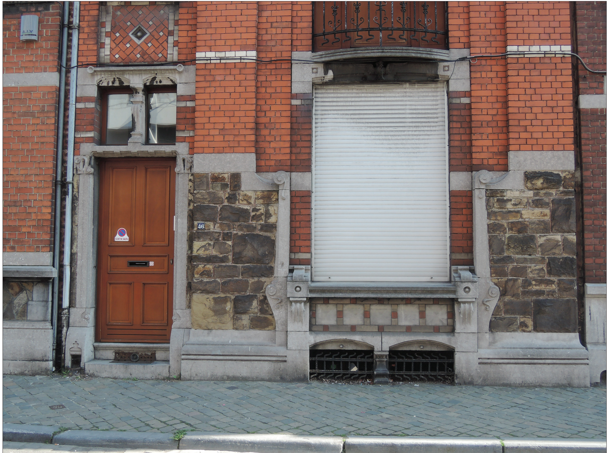
Photo © Hendrickx Guillaume ; 05/04/2019
