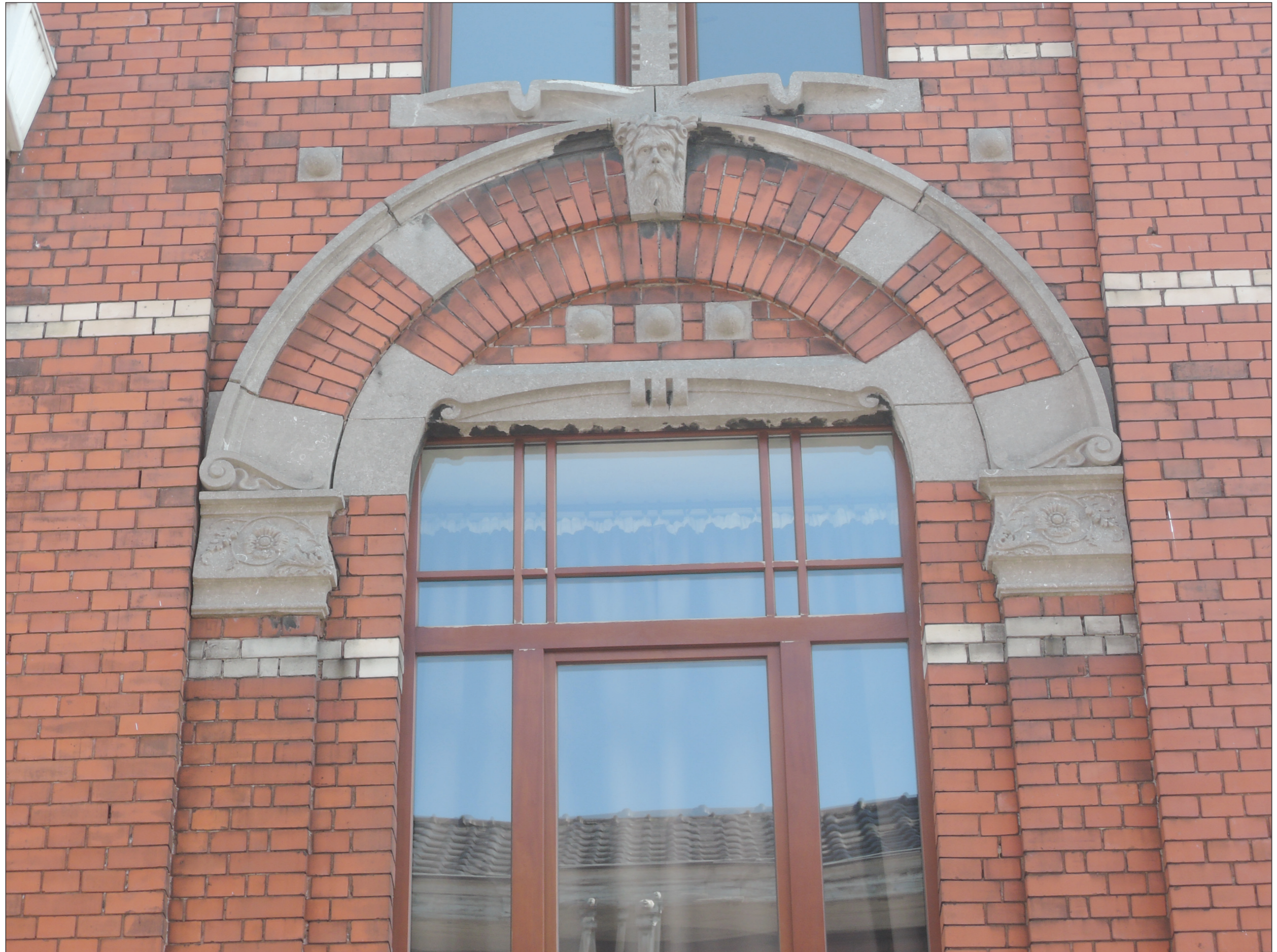
Photo © Hendrickx Guillaume ; 05/04/2019
