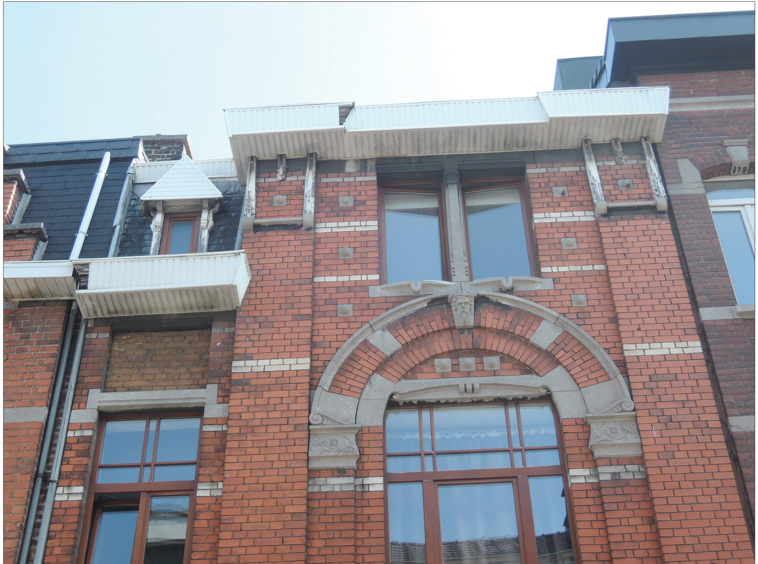
Photo © Hendrickx Guillaume ; 05/04/2019
