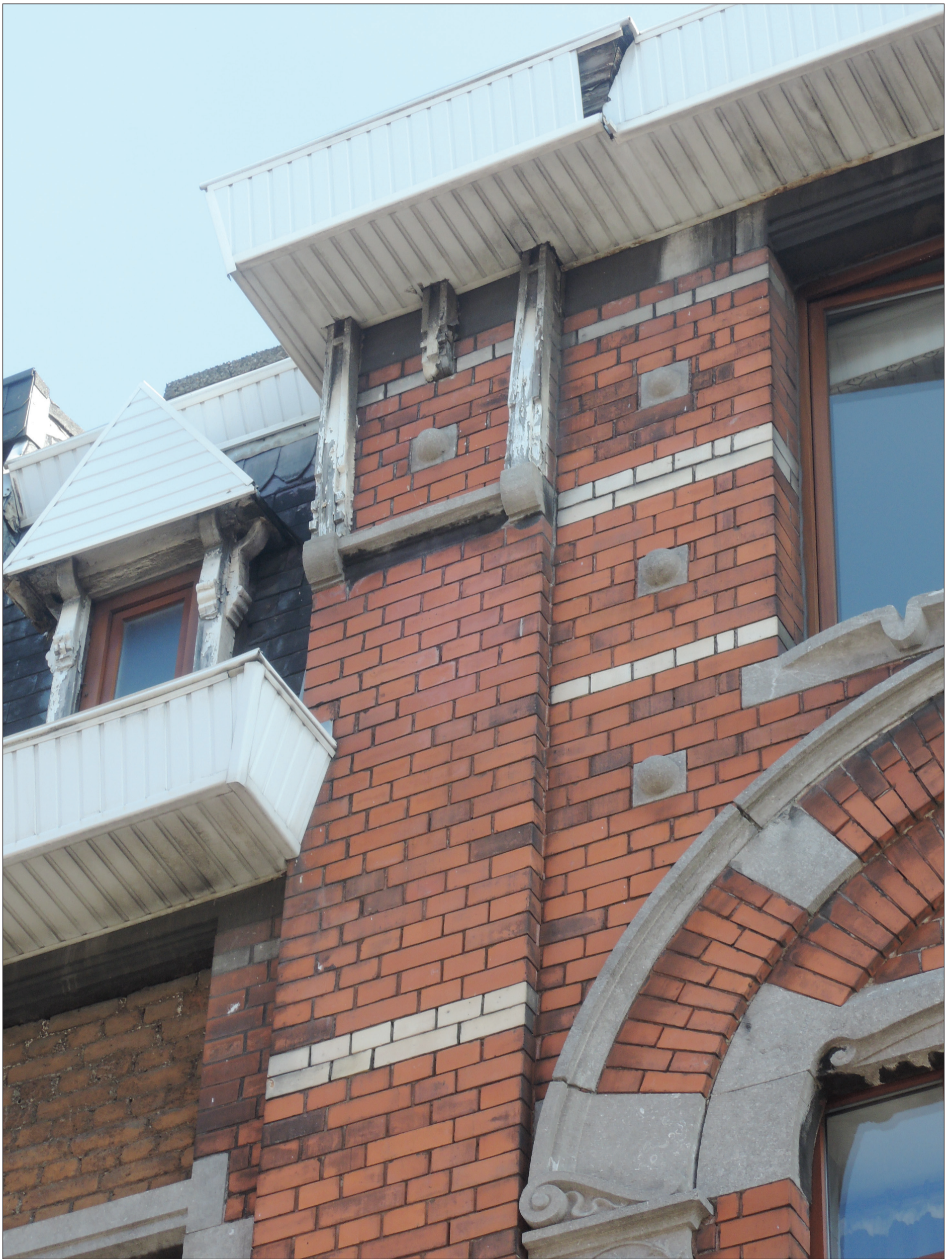
Photo © Hendrickx Guillaume ; 05/04/2019
