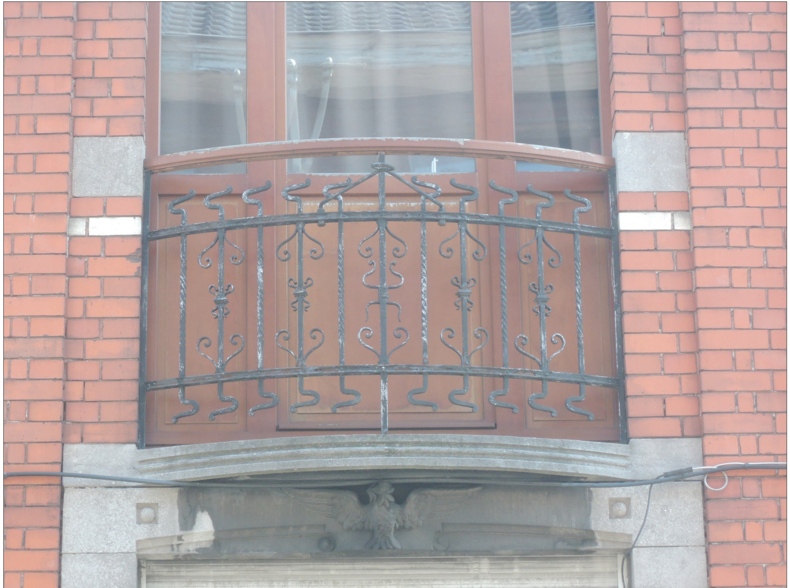
Photo © Hendrickx Guillaume ; 05/04/2019
