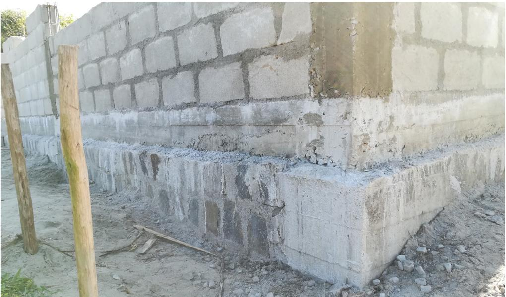
Figure 32 : Début de l'élévation des murs sur fondations
