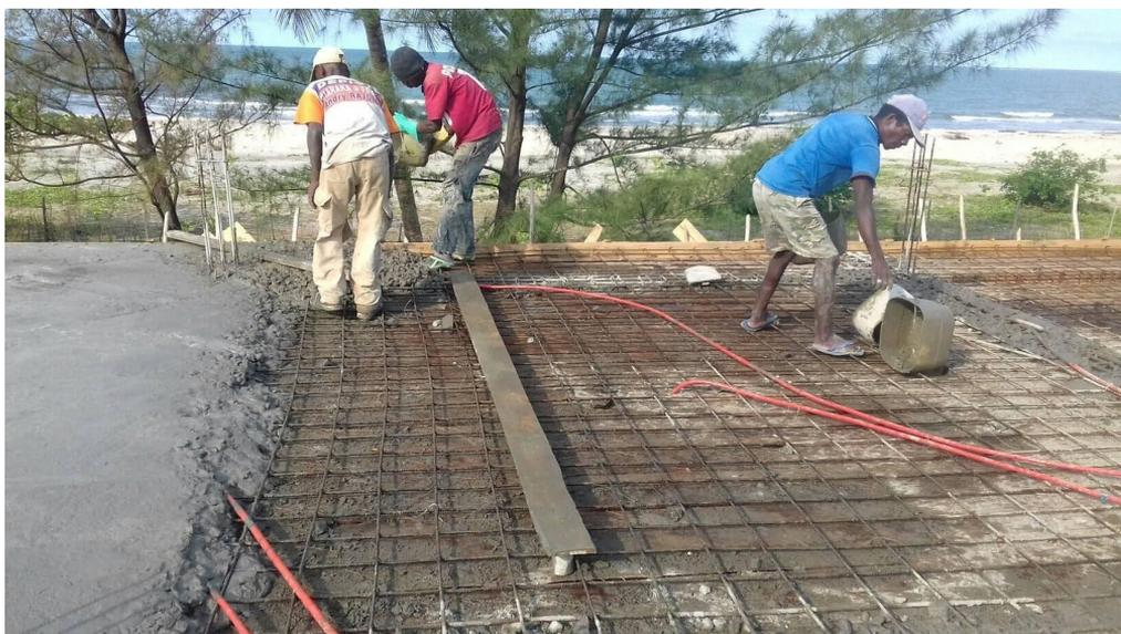
Figure 37 : Deuxième couche de béton pour la dalle de toiture
