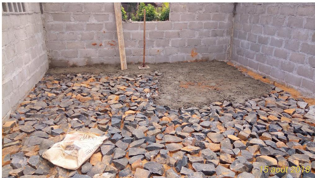
Figure 35 : Fine couche de béton servant de couche finale à la dalle de sol
