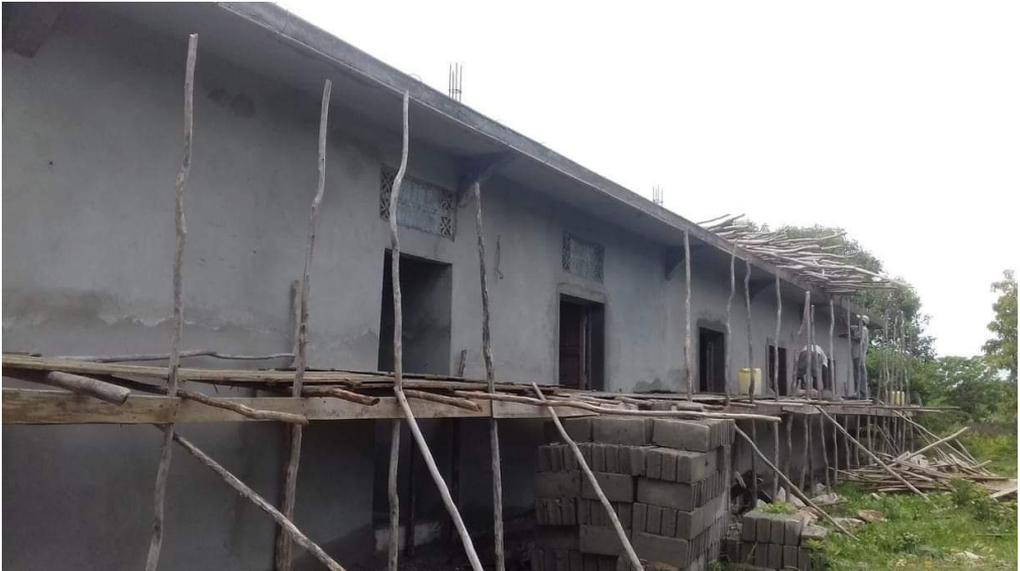
Figure 39 : Couche de cimentage sur l'ensemble des murs intérieurs/extérieurs
