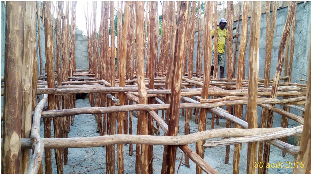
Figure 36 : Quadrillage de *boirons* servant d'éтанçons pour la dalle de toiture
