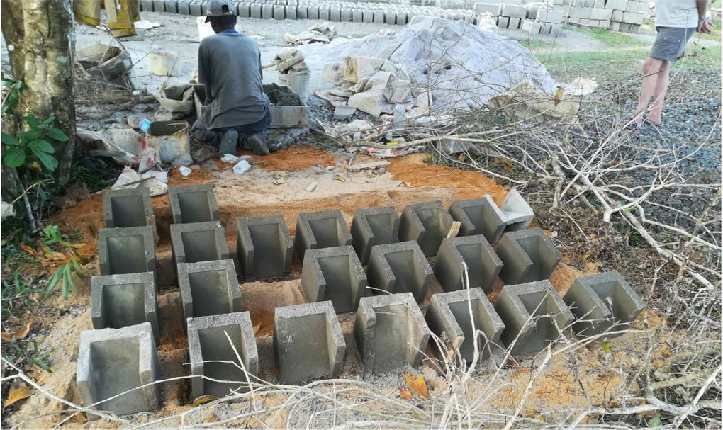
Figure 34 : Boîtes aux lettres façonnées sur chantier
