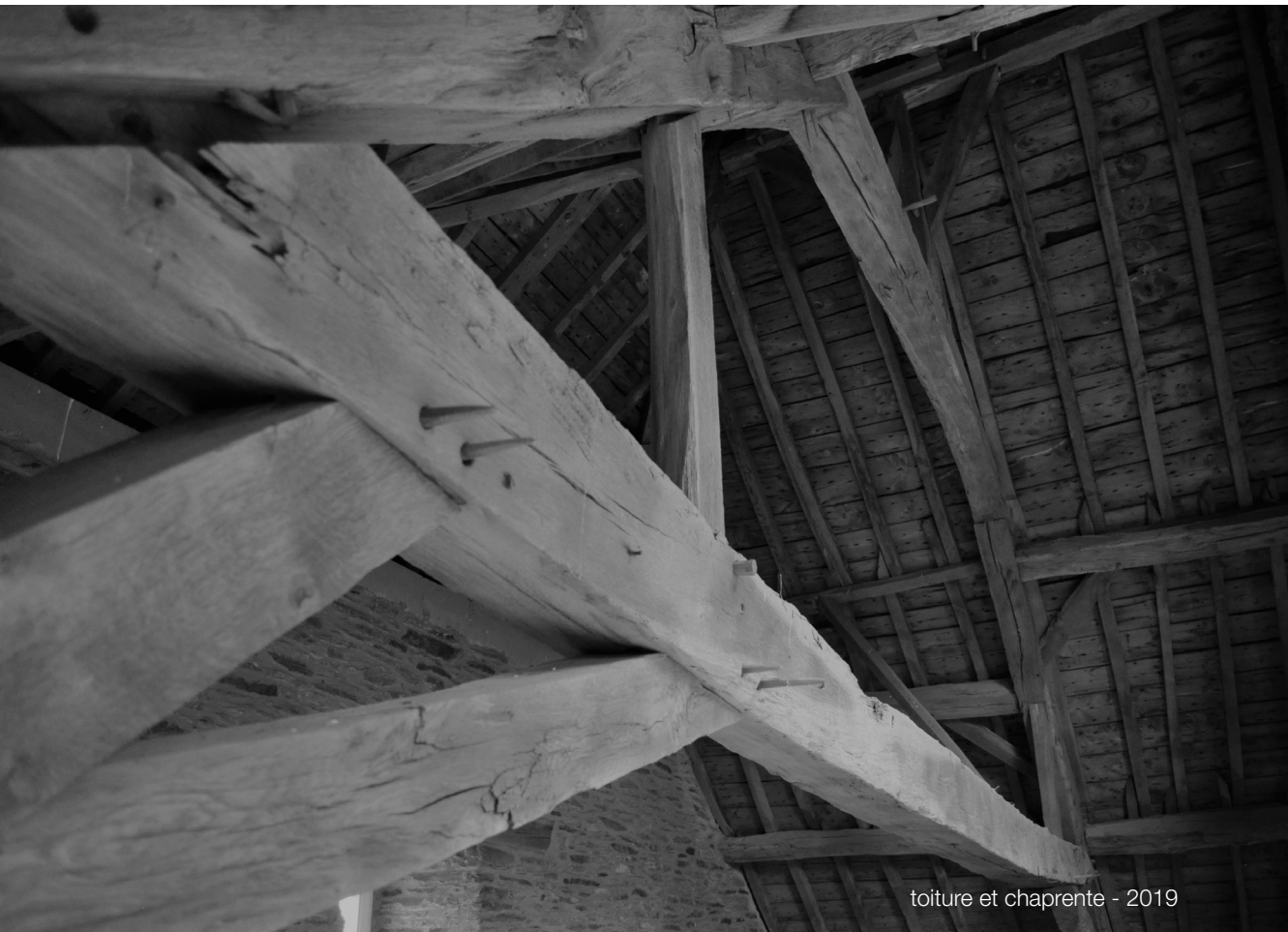
toiture et chaprente - 2019
