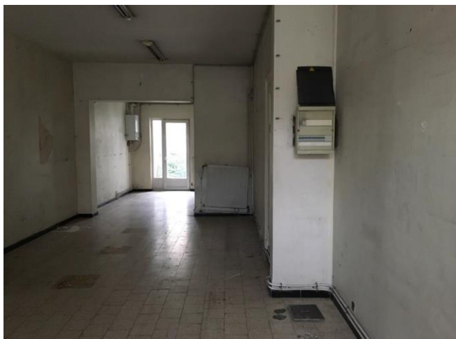
Figure 53: RDC pour le stockage des matériaux démontés (Source: BxlMrs)
