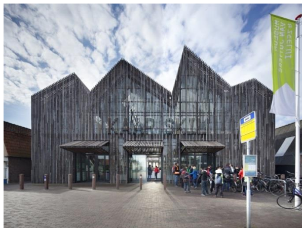
Figure 6: Bardage en palplanches de bois dur scié (Source: Mecanoo Architecten)
