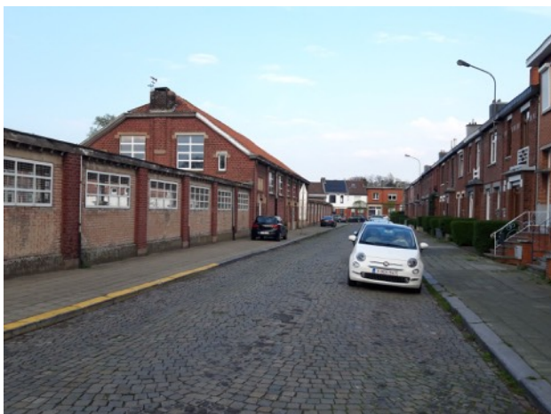
Photographie du relevé n°2 : Ecole communale de Bressoux-Haut
