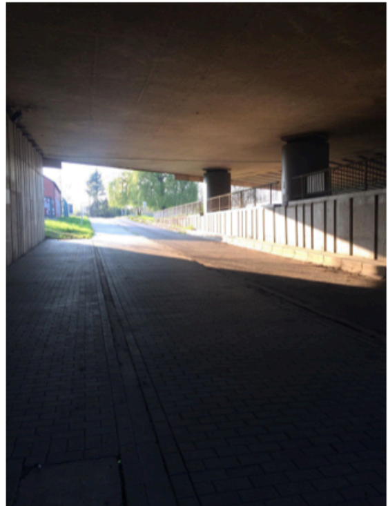
Fig 2 : Vue sous le pont.
