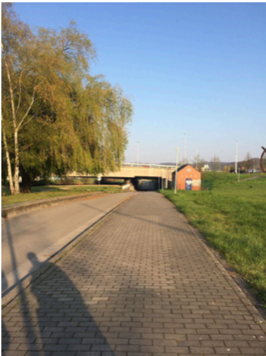
Fig 1 : Entrée au Pont des Grosses Battes de Angleur.
