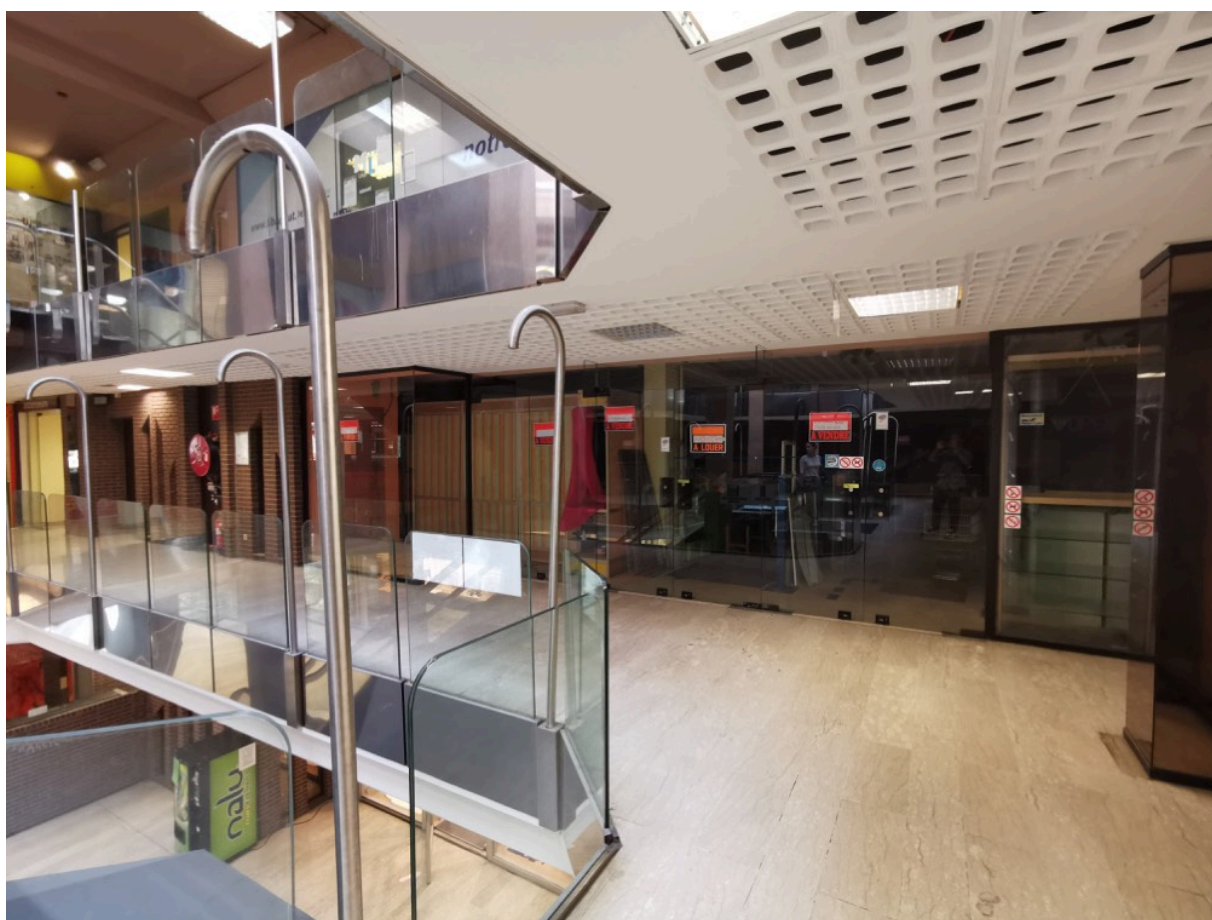
fig 3 : Activité commerciale inexistant au première étage de la Galerie des deux places, Verviers.
