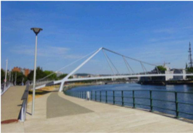
Photographie du relevé n°6 : Quai de la « belle-liégeoise », Parc de la Boverie.
