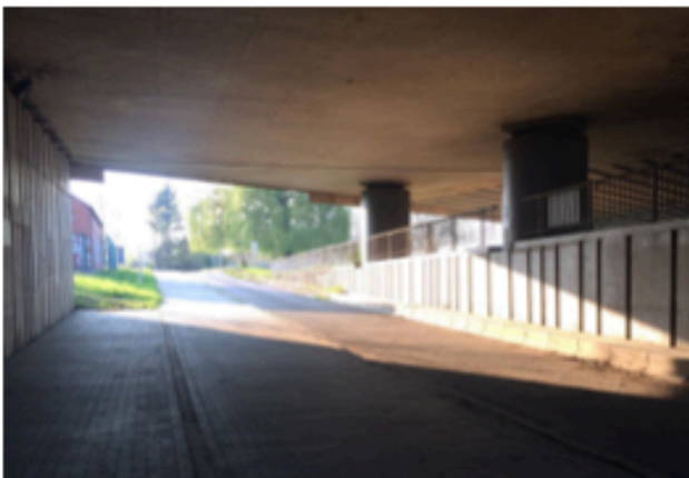
Photographie du relevé n°10 : Pont des Grosses Battes, Angleur.
