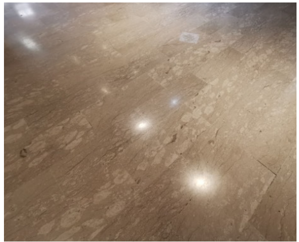
fig 6 : Revêtement de sol : dalle de type terrazzo.
