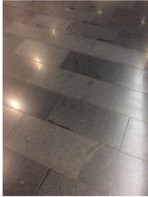
Fig 6 : Revêtement de sol de type terrazzo.
