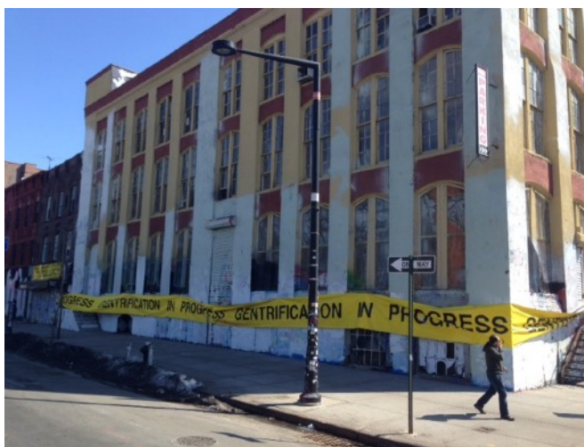
fig8 : Bâtiment du « 5 Pointz » après fermeture. Les graffitis ont été effacé par une peinture blanche.
