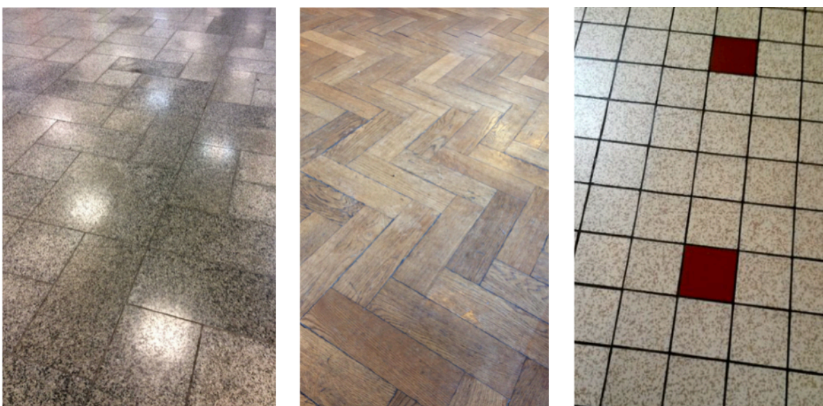
Fig 3, 4 et 5 : Revêtement de sol en pierre polie de la Gare du Palais ; Revêtement de sol en bois de la salle de gym de la haute école HELMO en Outremeuse ; Revêtement de sol en carrelage de l'école Naniot à St.Walburge
