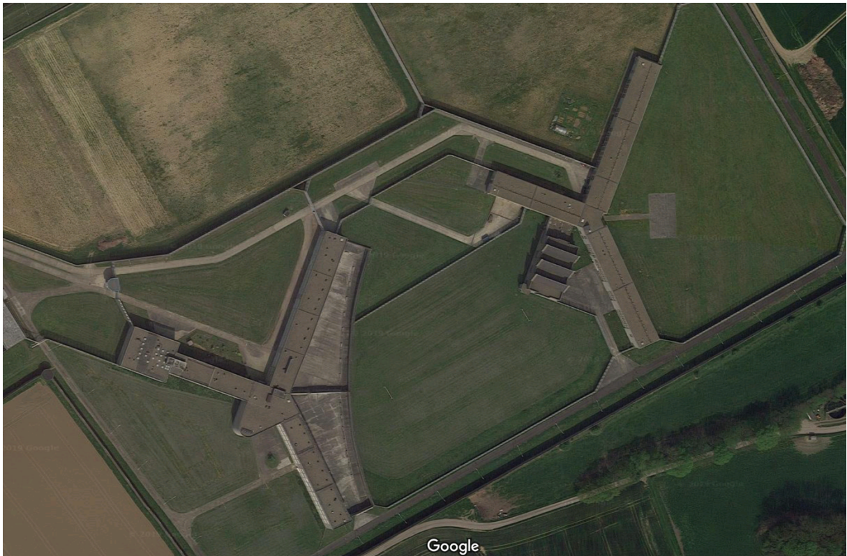
Fig. 15 : Paifve, vue aérienne des blocs cellulaires. ©Google Maps.
