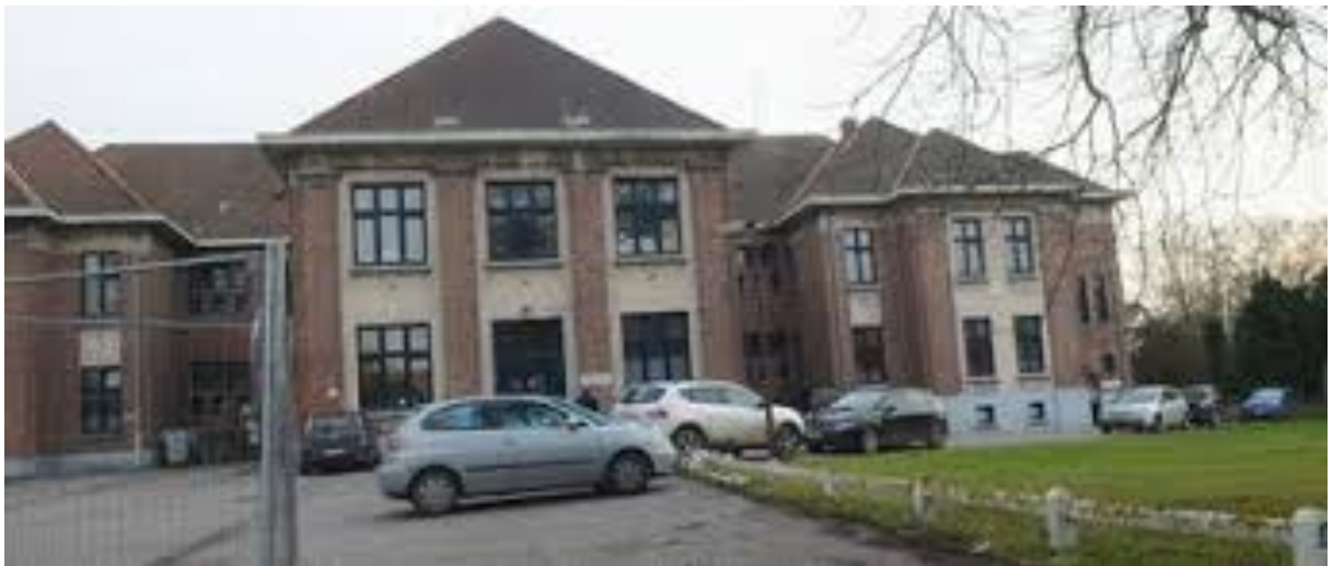
Fig. 3 : Mons, façade du site Chêne aux Haies. ©Google Street View.
