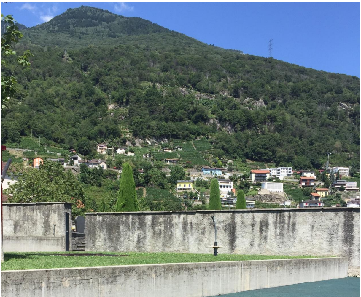
Figure 60 : photo du mur d'enceinte du cimetière
