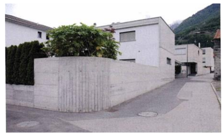
Figure 67 : photo des murets
