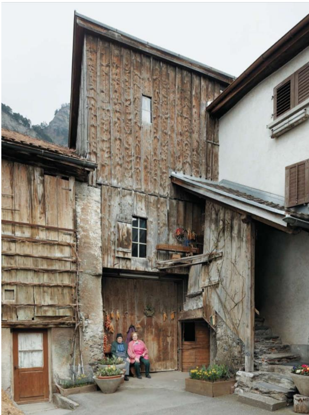
Figure 9 : photo étable - centre de Fläsch
