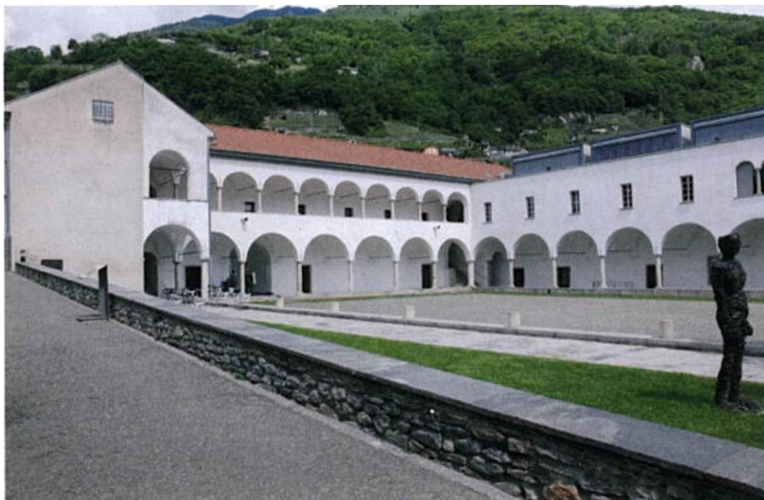
Figure 63 : photo du couvent après rénovation
