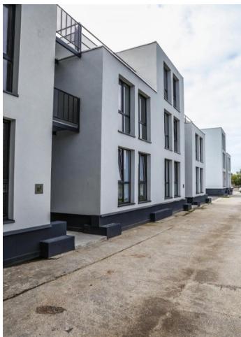
Figure 26 15 appartements à Pont-à-Celles (TH.P et CH.V, 2017)
