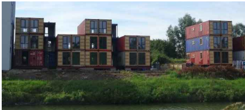
Figure 25 Chantier en cours – 15 appartements à Pont-à-Celles (BELGA, 2016)
