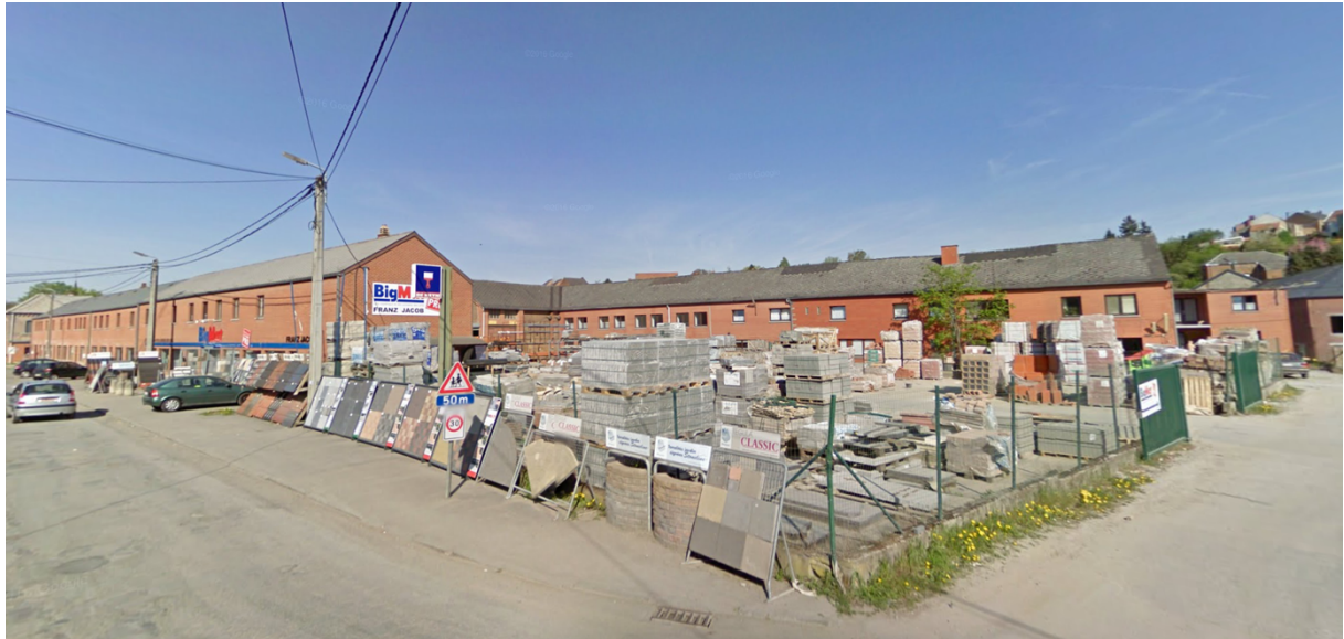
Figure 34 Photo du site de la future construction en 2010 (GOOGLE MAPS, 2010)
