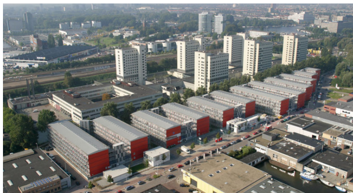
Figure 16 Vue aérienne - Keetwonen (TEMPOHOUSING, s. d.)
