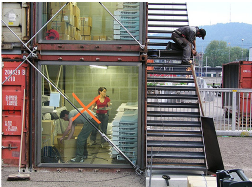
Figure 64 Technique de tirants au Freitag Flagship Store à Zurich (FREITAG, 2011)
