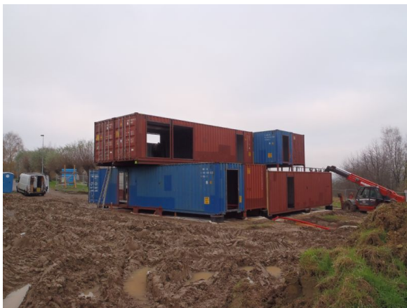
Figure 29 Chantier en cours - Logements sociaux à Visé - Okube (REGIONALE VISETOISE D'HABITATION, 2015)
