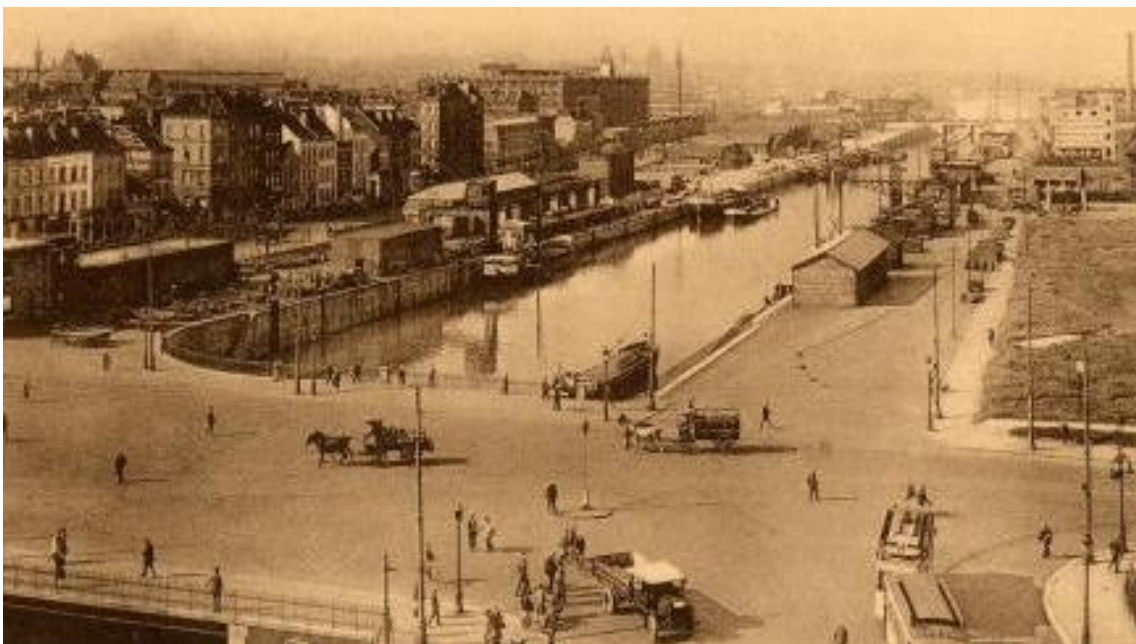
Figure 13. Vue vers le quai des matériaux
