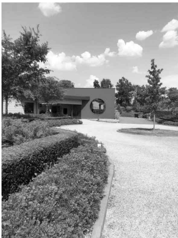
Figure 38 - Entrée au crématorium de Ciney
