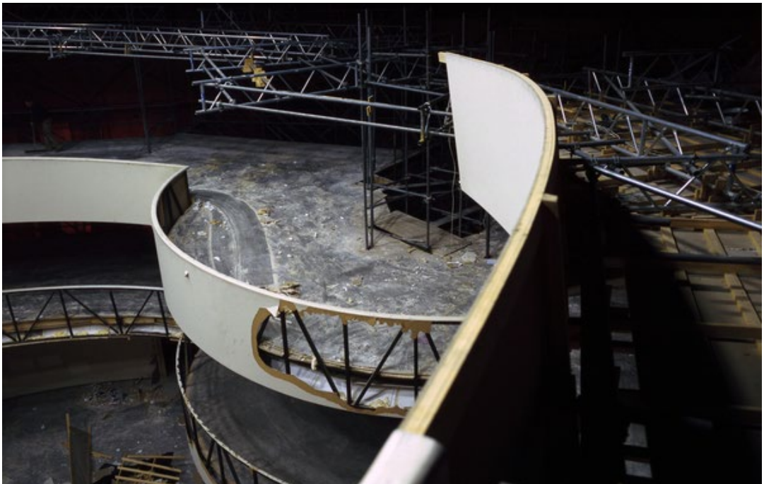
Fig. 123 à 124 Réalisation d'une maquette 1/1 du Guggenheim Museum
