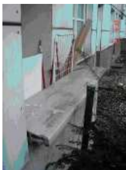
Fine couche de finition murale en plâtre contenant des fibres d'amiante, couvre mur en amiante ciment et plaques de façade en amiante-ciment de type « Glasal » couche de finition bleu-vert.
