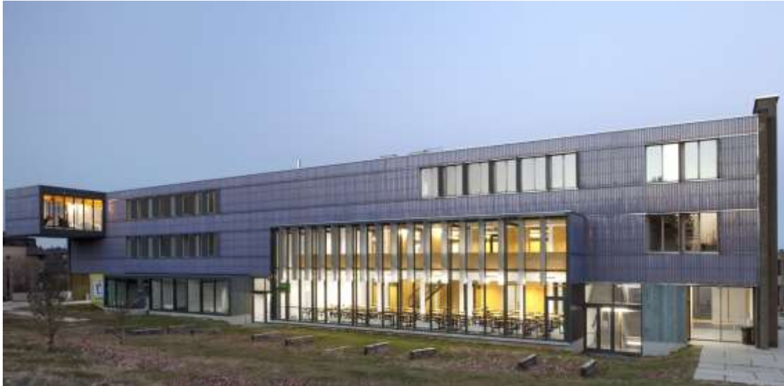
5. Résultat final avec le bardage et les niches qui ressortent.
