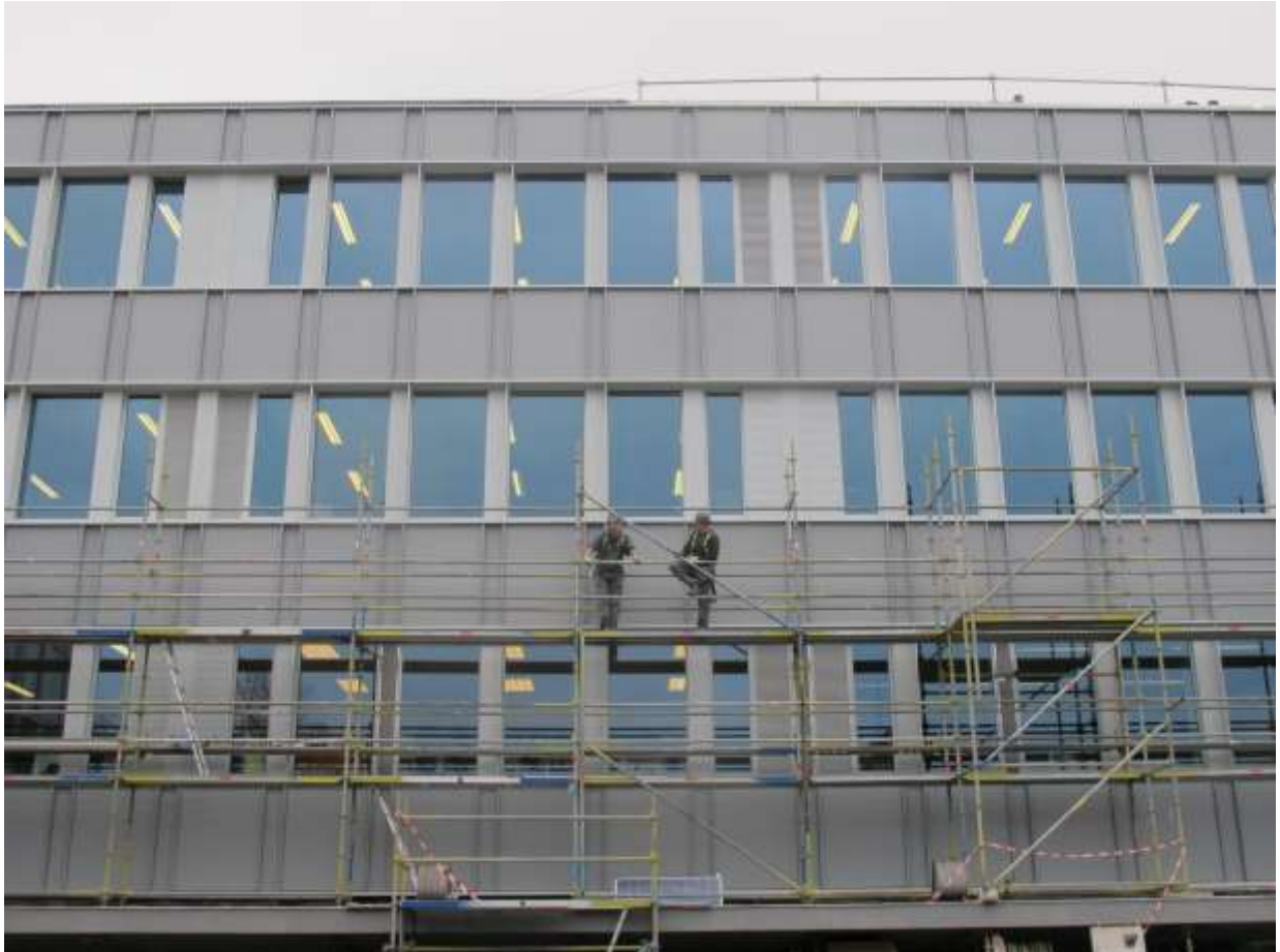
Photo d'une façade avec le système de ventilation. ©Auteur, 2019
