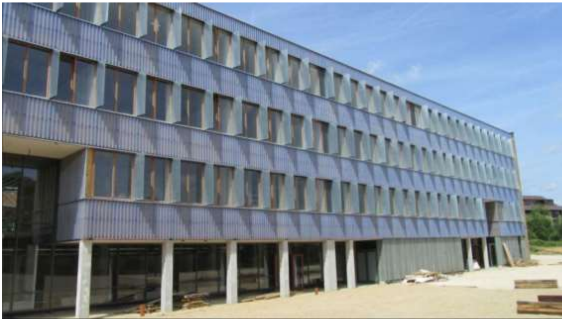
6. Façade Est avec éléments de réemploi. Photo du document colloque PEE Namur, 1 octobre.2001
