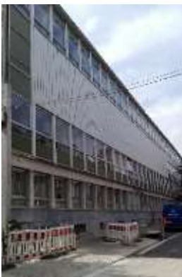
Façade Avenue Maurice Destenay, situation de l'époque avant les transformations / rénovations.
