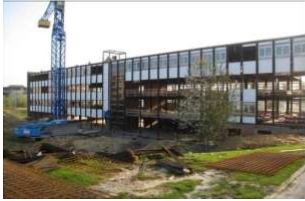
2. Façade Ouest : démontage de la façade
