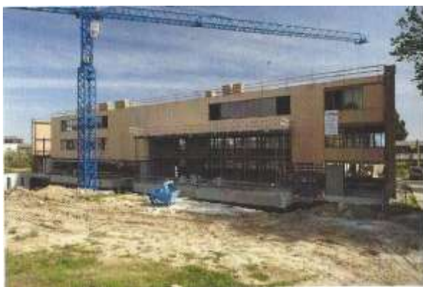
4. Nouveau complexe isolant sur la façade
