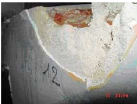
Fine couche de finition murale en plâtre contenant des fibres d'amiante, couvre mur en amiante ciment et plaques de façade en amiante-ciment de type « Glasal » couche de finition bleu-vert.
