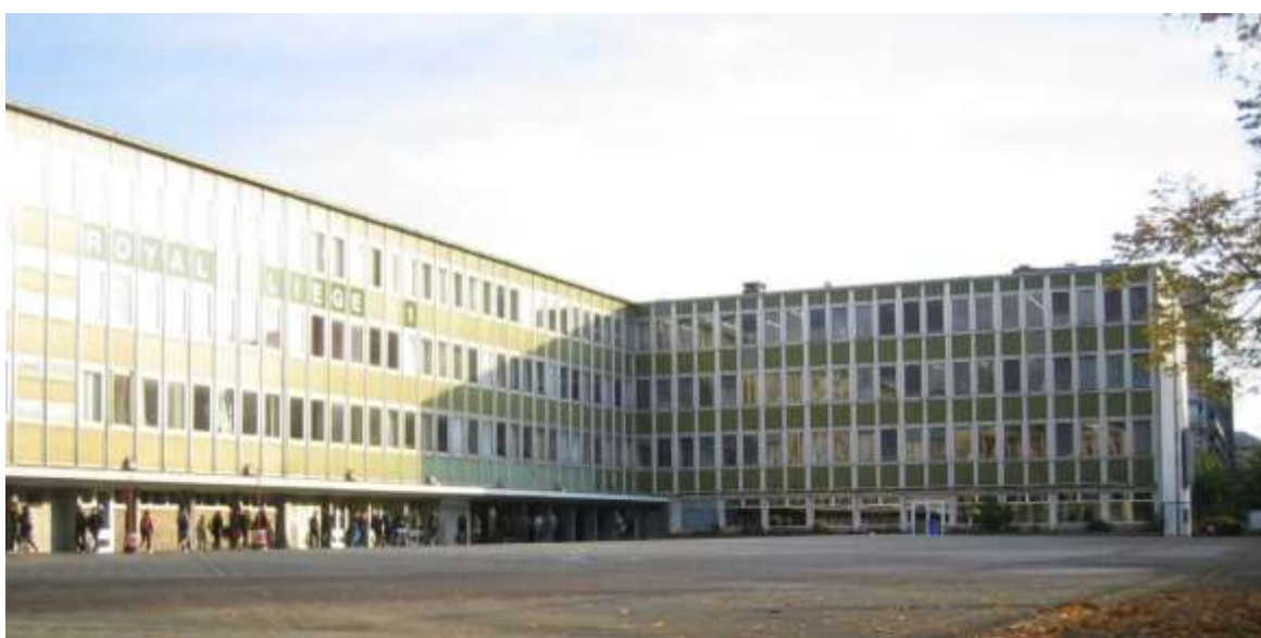
Photo de l'intérieur de la cour. © AA-AR
