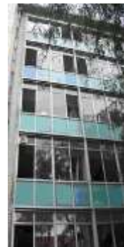
Fine couche de finition murale en plâtre contenant des fibres d'amiante, couvre mur en amiante ciment et plaques de façade en amiante-ciment de type « Glasal » couche de finition bleu-vert.
