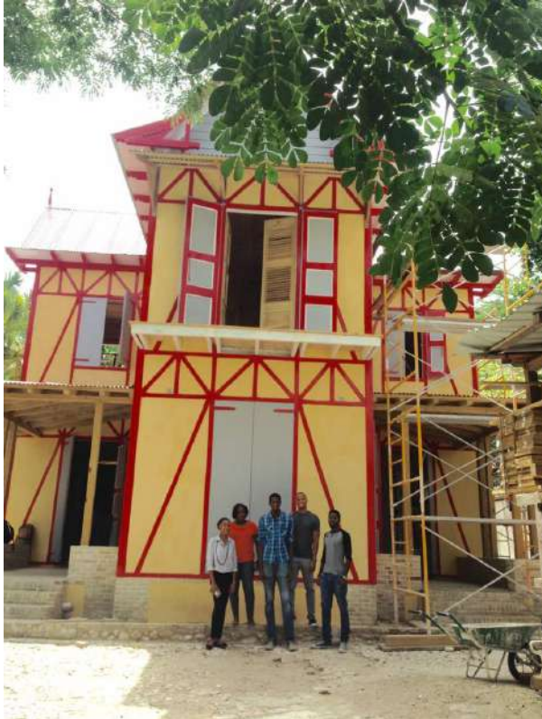
Photographie 40 : Reconstruction par la FOKAL 72 de la maison Chenet à l'« identique » en structure bois après sa destruction par les termites. Photographie prise par M. Thomas le 12 juillet 2018 lors d'une visite de la maison avec Madame Farah Hyppolite.
