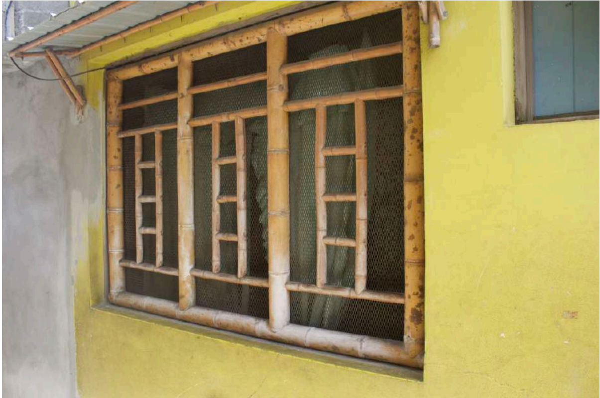
Photographie 41 : Barreaudage en bambou sur les maisons de Morne Hercule. Photographie prise par M. Thomas le 8 août 2018.
