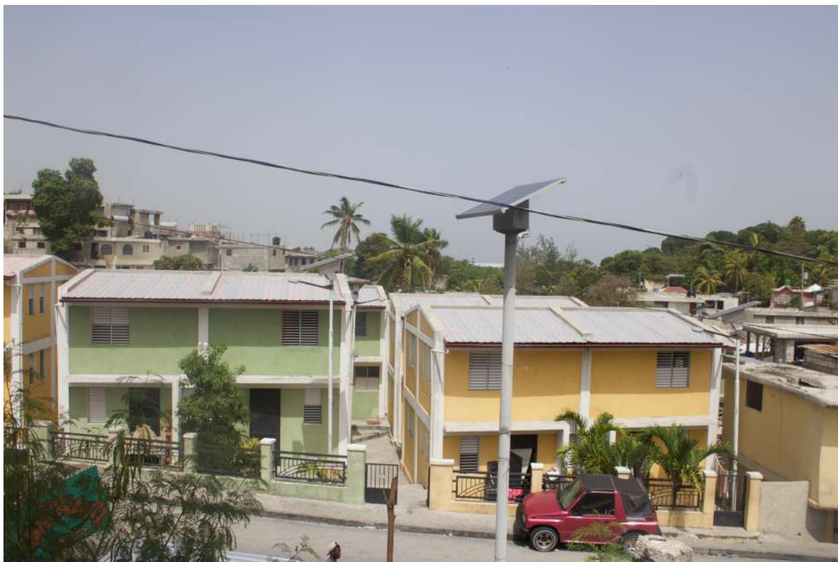
Photographie 28 : Projet Nord Alexis. Photographie prise par M. Thomas le 8 août 2018, à Texas.
