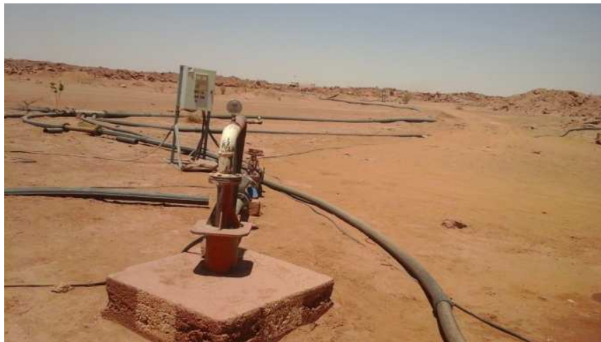
Figure 18 : Couronne de dénoyage sur Artois
