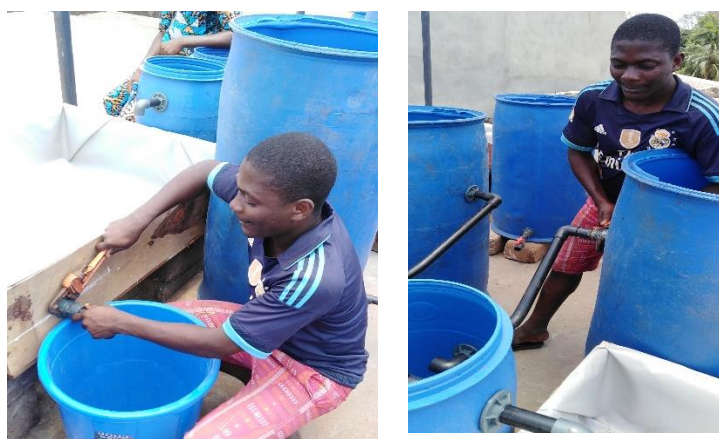
Photo 14 : Installation des unités aquaponiques (Hounsa, 2019)
