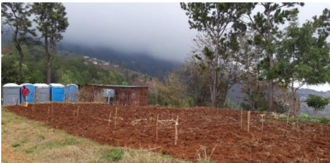
Photo 1. Travaux de mise en place du dispositif à Robin
