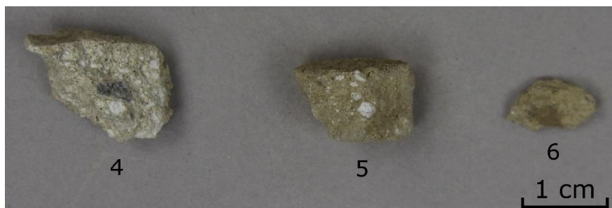
Fig. 90 – Aspect des enduits des échantillons 4, 5 et 6.
