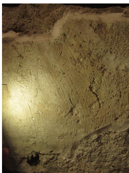
Fig. 81- Traces de lissage et de pinceau observées en lumière rasante
