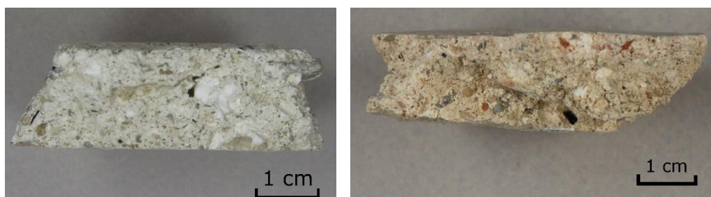
Fig. 54 – Enduit de type D1 (gauche) et de type D2 (droite)
