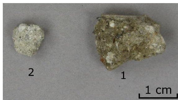
Fig. 88 – Aspects des enduits des échantillons 1 et 2
