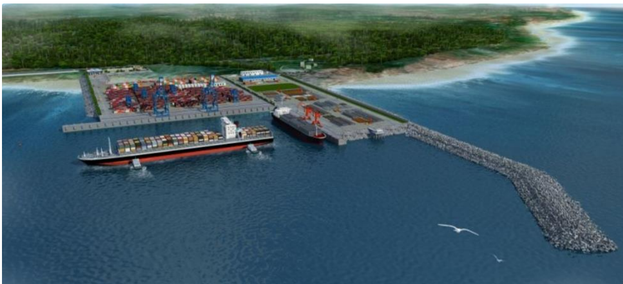
Photo 1 : Digue de protection du PAK (source : MEAO, 2016)
