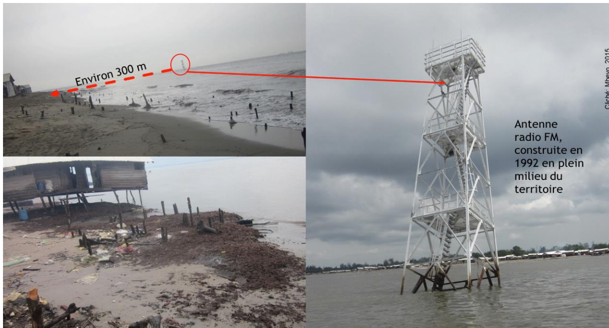
Planche photo 9 : preuves de l'érosion côtière à Cap Cameroun (cliché : Mbevo, 2015)
