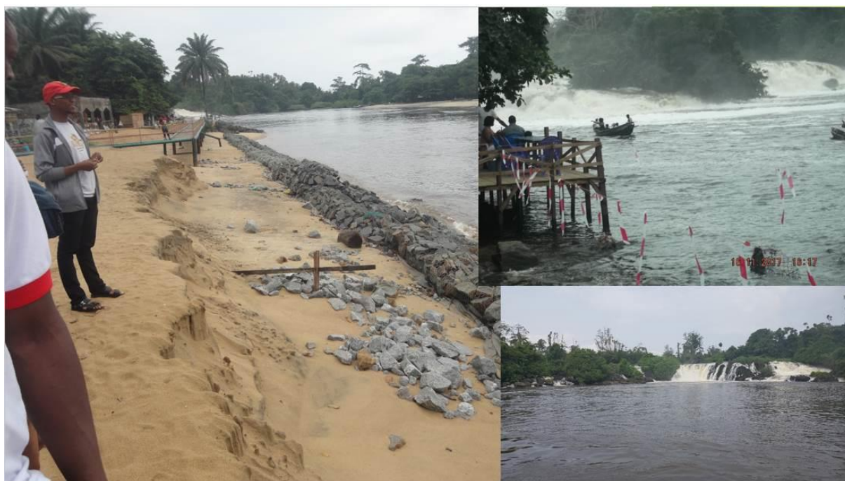
Planche photo 10 : Construction d'une digue pour la protection des chutes de la Lobé à Kribi. (Cliché : Mbevo, 2018 ; Tchindjang, 2012)
