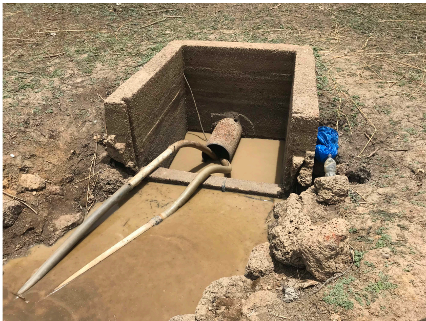
Photo n°7 : Chambre de Captage, (S.BACALU)
