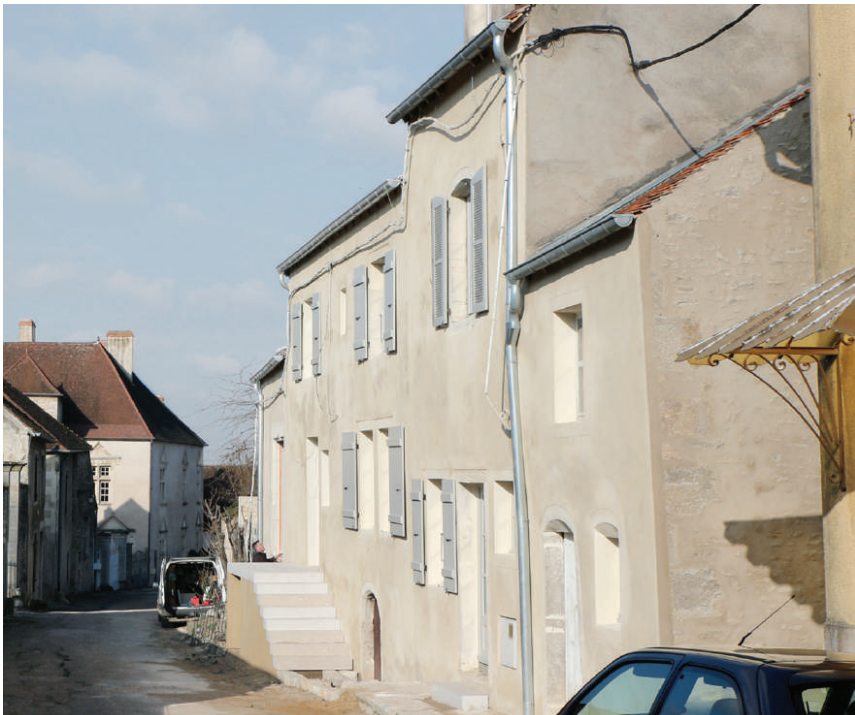
Figure 63 et 64: Exemple d'intervention à Pesmes avant - après
