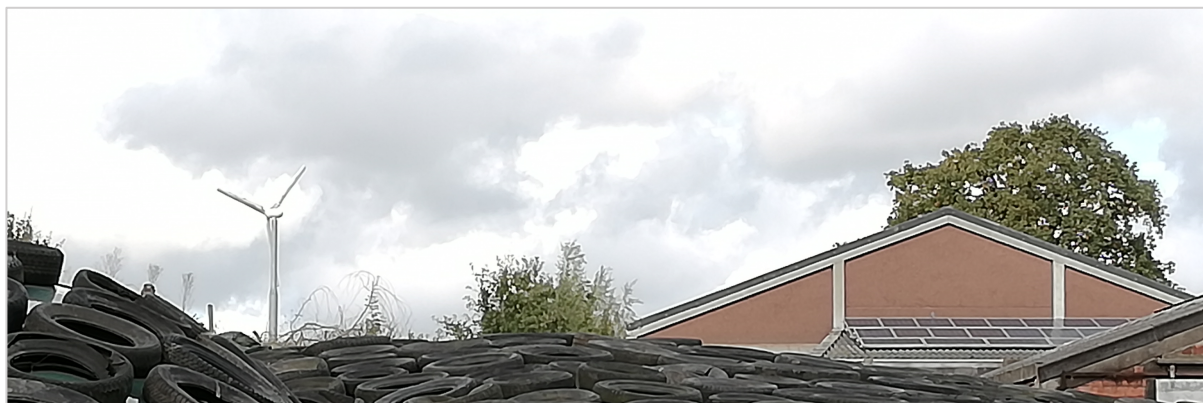
Figure 22 Photo des installations éolienne et photovoltaïque dans une ferme wallonne visitée
