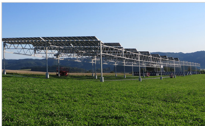
Figure 10 Agriculture et production solaire photovoltaïque sur une même surface: exemple d'agri-voltaïque, projet pilote installé en Allemagne (près du lac de Constance) 16
