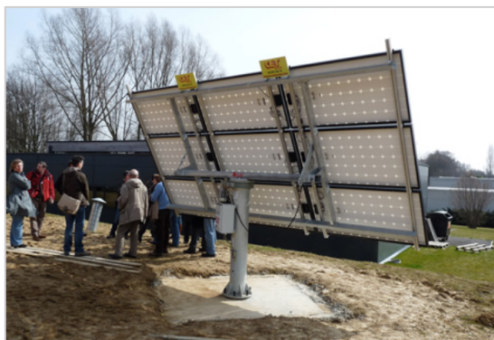
Figure 8 "Tracker" solaire sur pied 14
