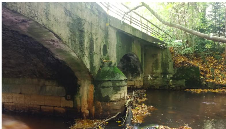
FIGURE 4.5 – Attaque alcali-silice : Photo de M. Müller, Langesthal - Eupen [Courard, 2019].
