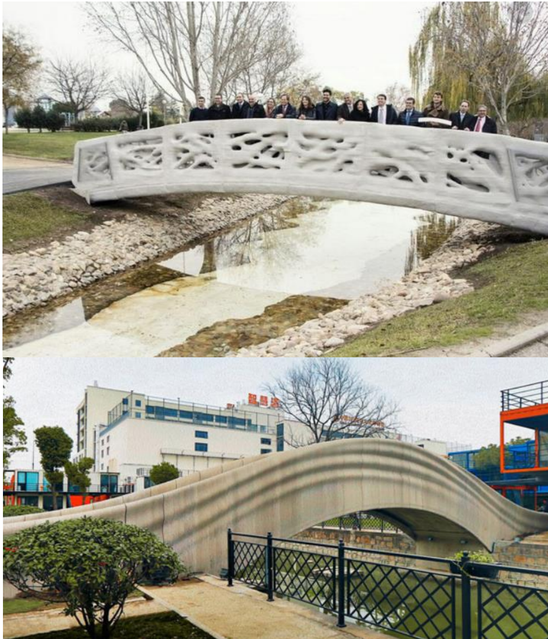
Figure 7 : En haut le premier pont imprimé en 3D à Madrid, en bas le plus long pont imprimé du monde en Chine.
