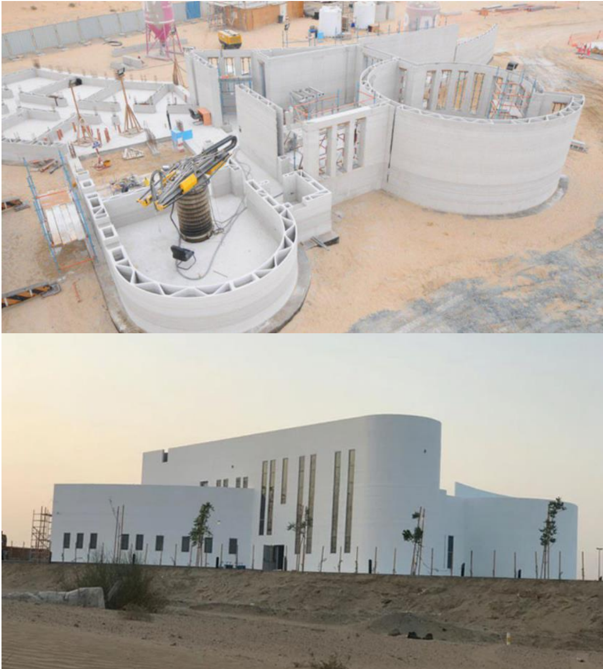
Figure 9 : Le plus grand ouvrage imprimé au monde construit par l'entreprise Apis Cor.
