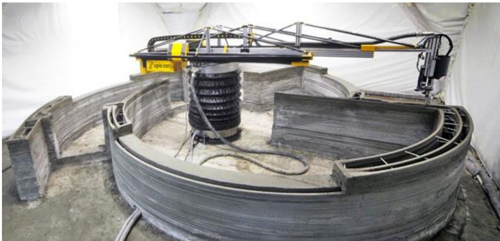
Figure 1: Technique d'impression 3D du béton par extrusion/dépôt.
