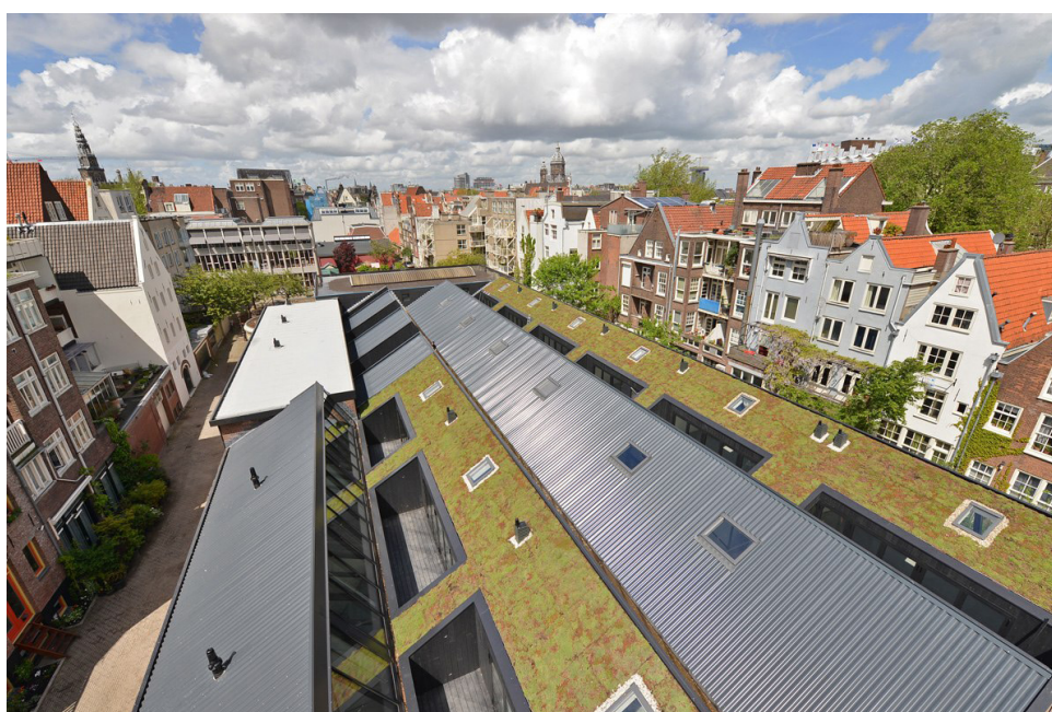
Figure 56 : Toiture en dents de scie
