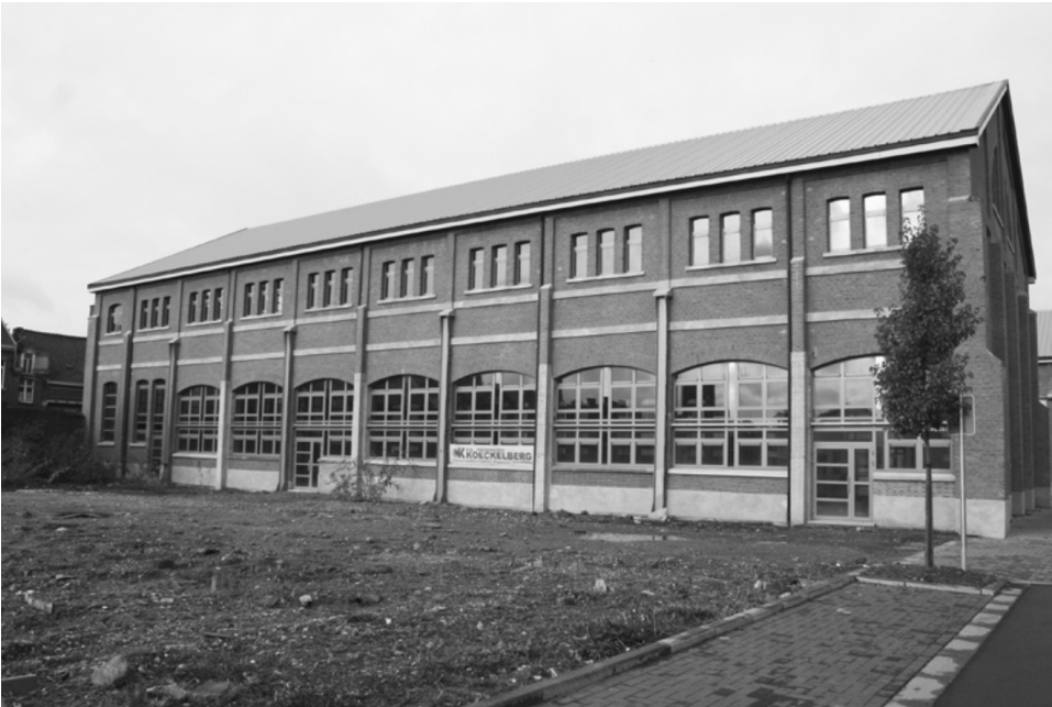
Figure 22 : Volume extérieur après une première rénovation
