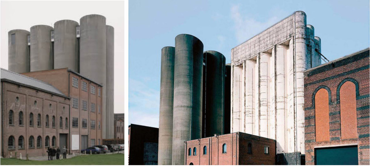
Figure 68 et 69 : Bâtiment avant reconversion
