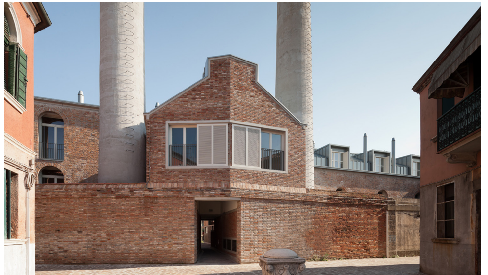
Figure 104 à 107 : Extérieur du bâtiment A
