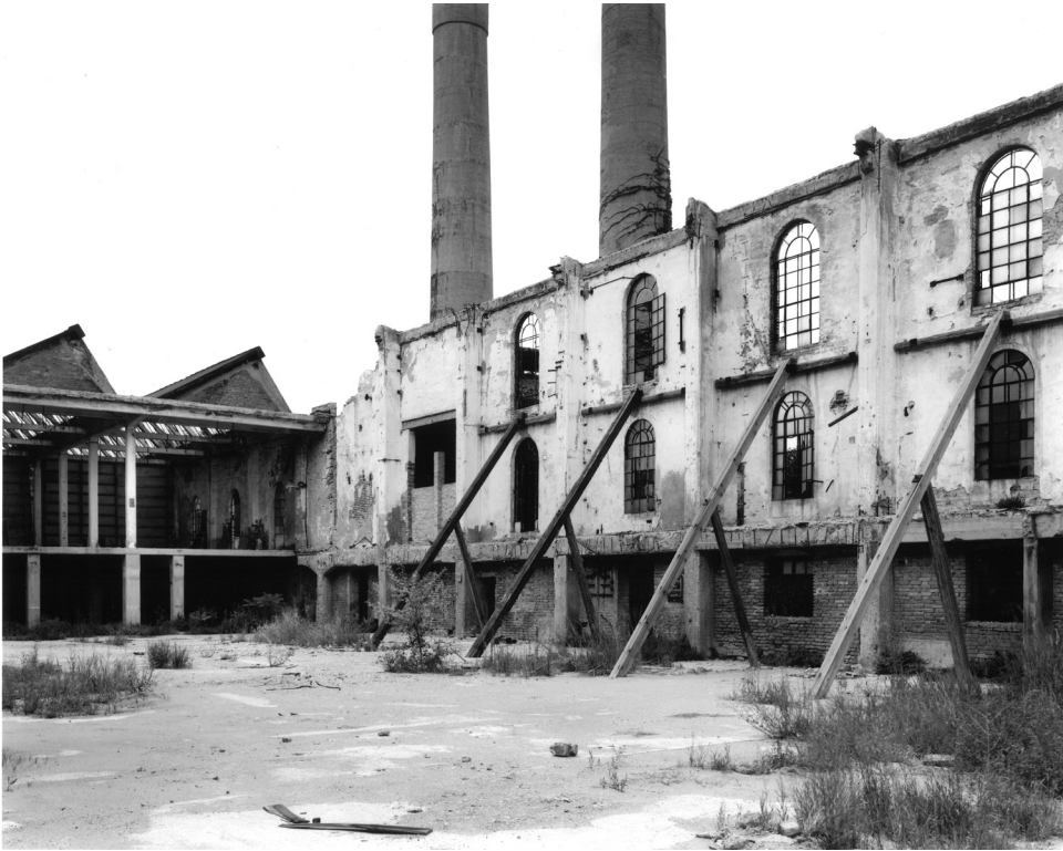
Figure 88 : Façade conservée du volume A
