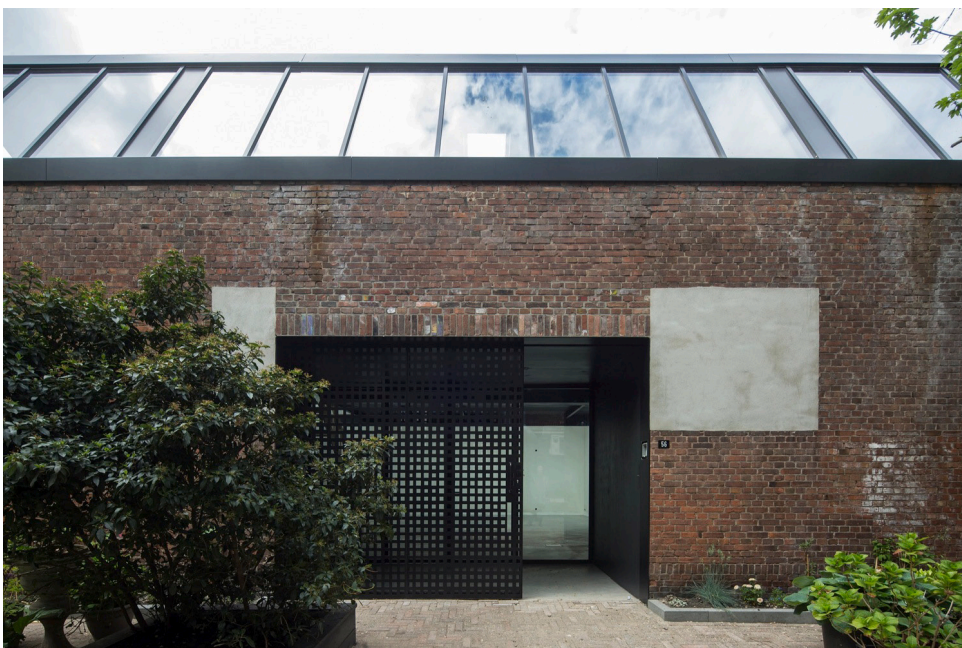
Figure 54 : Anciennes ouvertures rebouchées avec l'enduit de ciment
