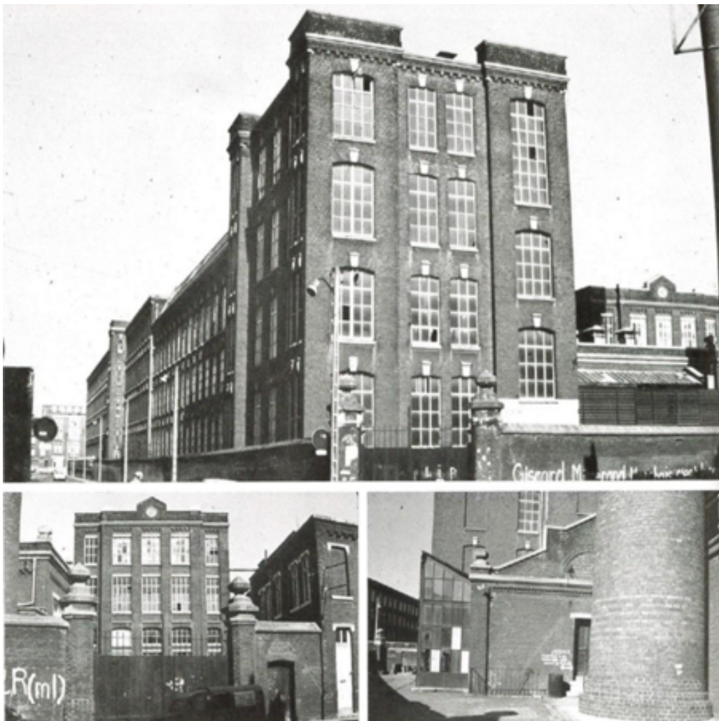
Figure 110 : Le bâtiment avant sa reconversion
