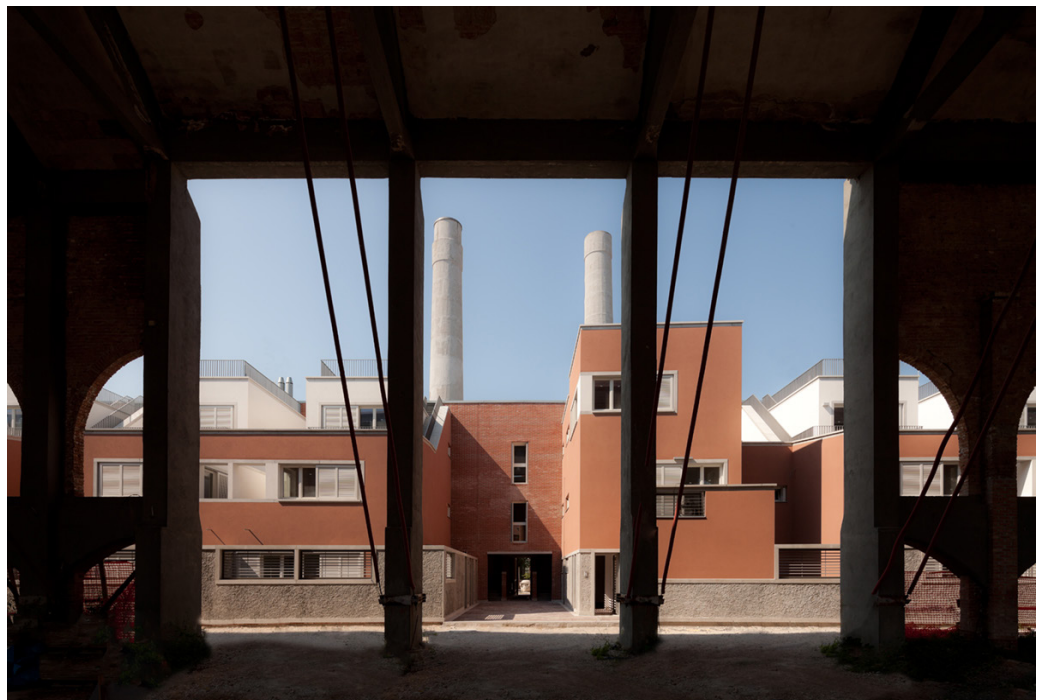
Figure 99 : Vue du bâtiment A à l'intérieur du bâtiment B
