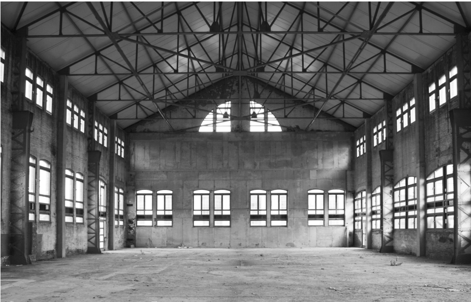
Figure 23 : Volume intérieur après une première rénovation
