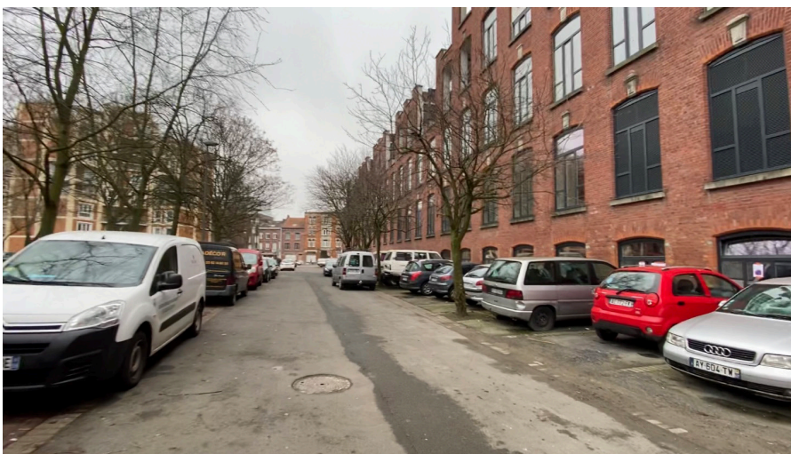
Figure 138 à 140 : Espaces extérieurs
