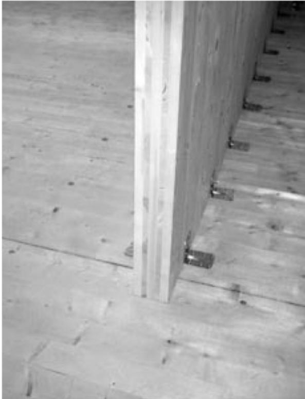
Système de fixation supplémentaire, parois intérieures
