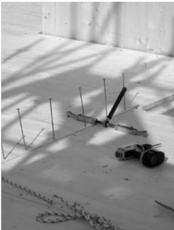
Vis de fixation des parois structurelles, outils légers
