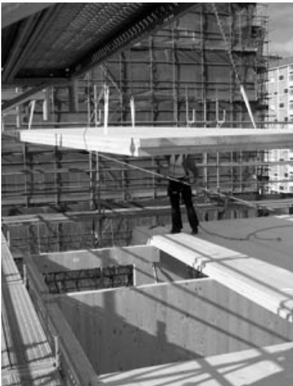
Fixation des dalles de plancher en CLT, nécessite que 2 hommes sur site et pilote pour la grue
