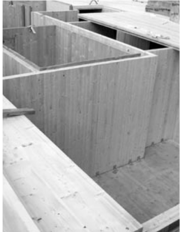
Parois intérieures structurales avant la pose de dalle
