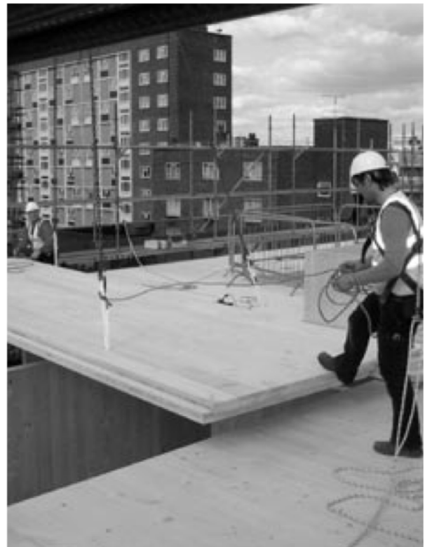
Fixation des dalles de plancher en CLT, nécessite que 2 hommes sur site et pilote pour la grue
